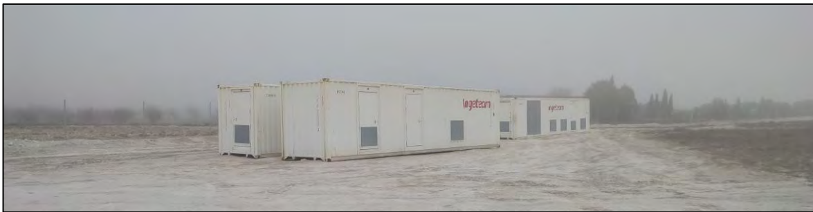
Ilustración 8. Colocación de casetas de obra.
