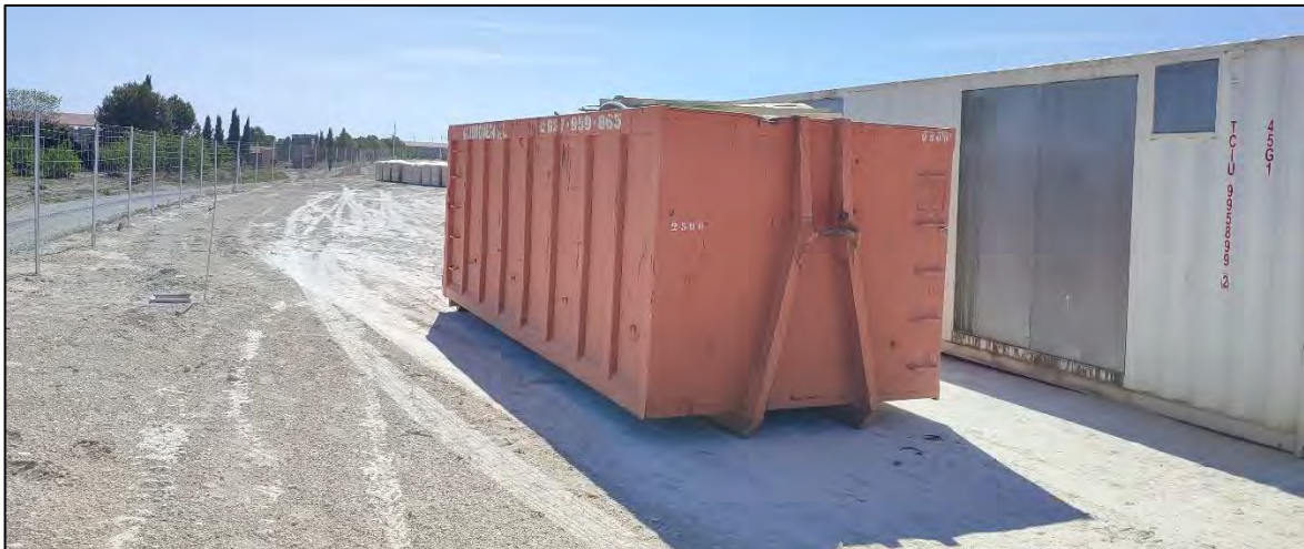
Ilustración 18. Colocación de contenedor para la gestión de residuos.
