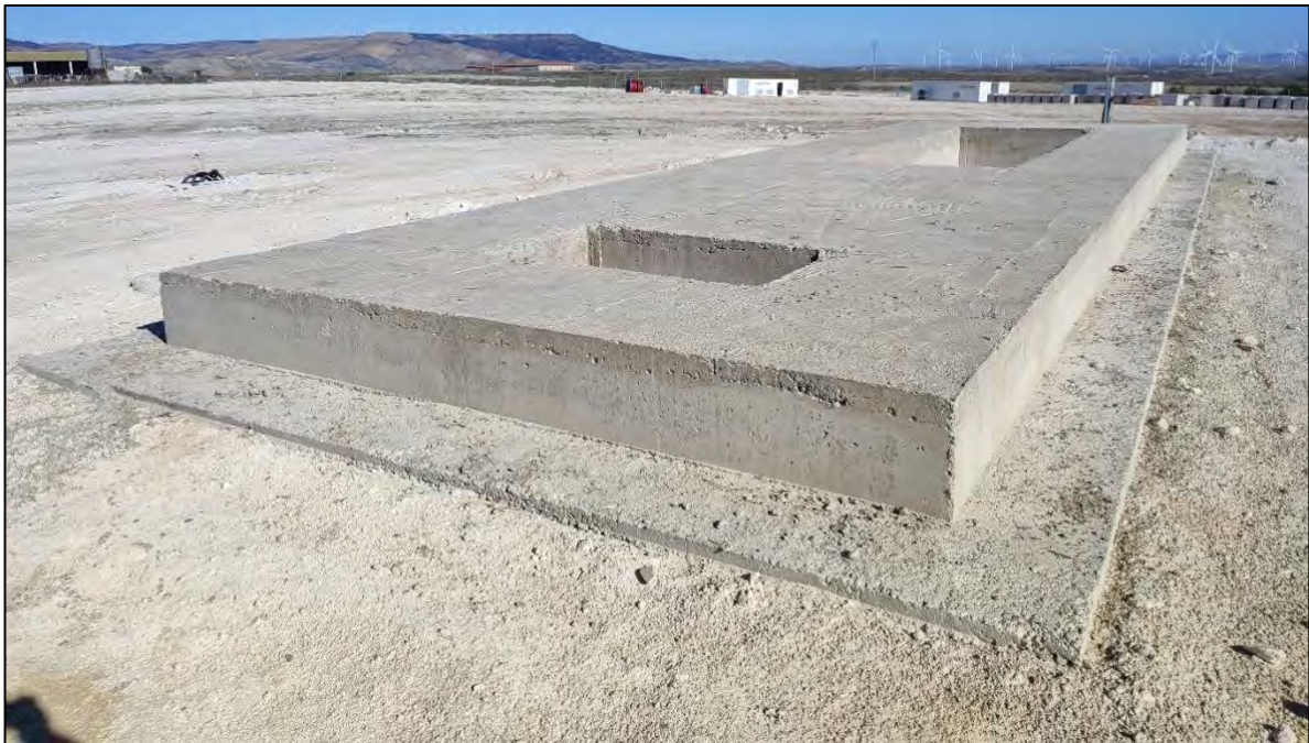
Ilustración 12. Cimentación de la base de las Power Station.
