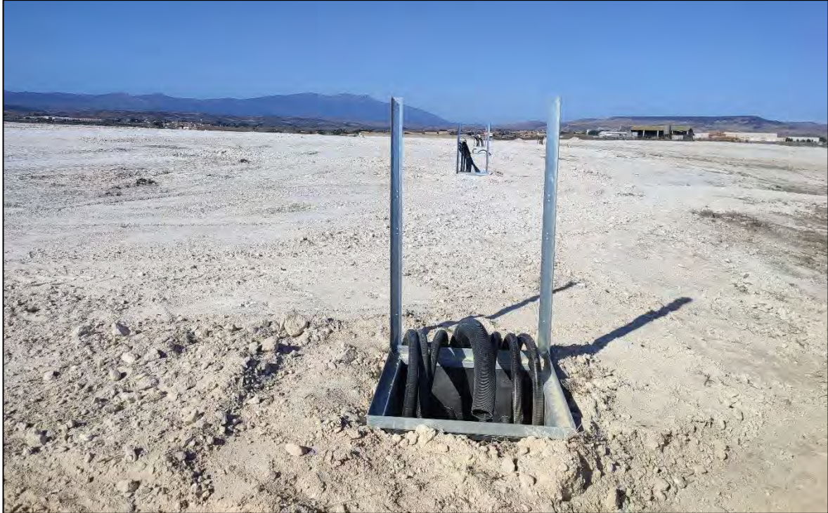
Ilustración 11. Colocación de elementos del PFV.
