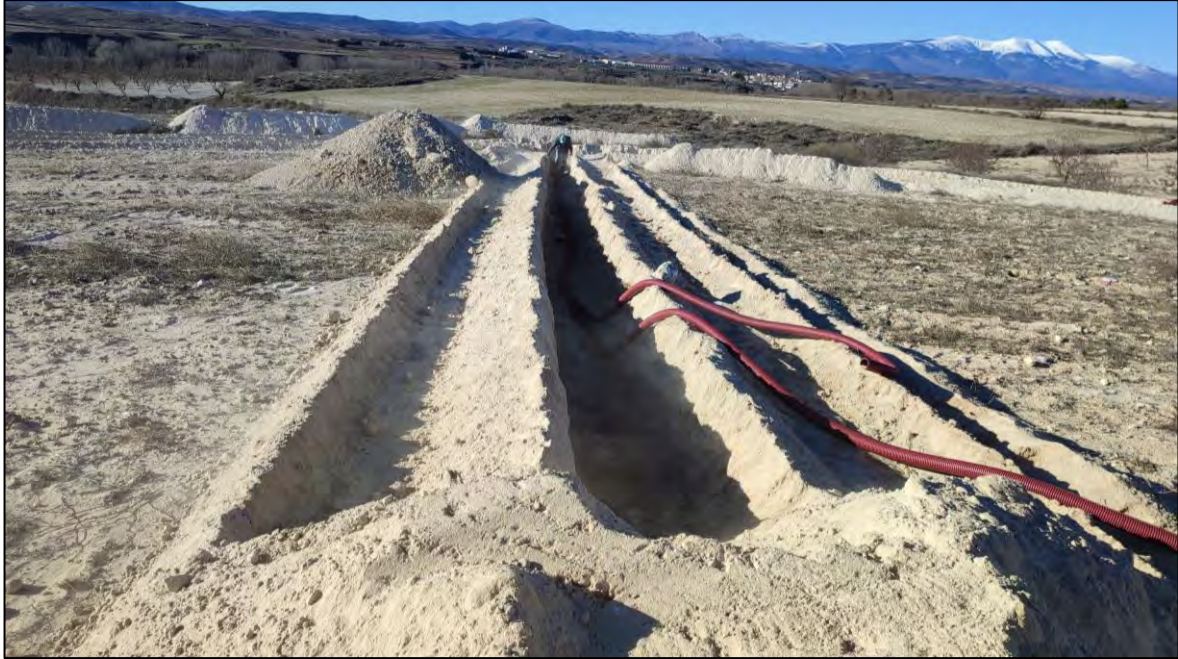
Ilustración 5. Colocación de las tuberías de cableado en las zanjas.
