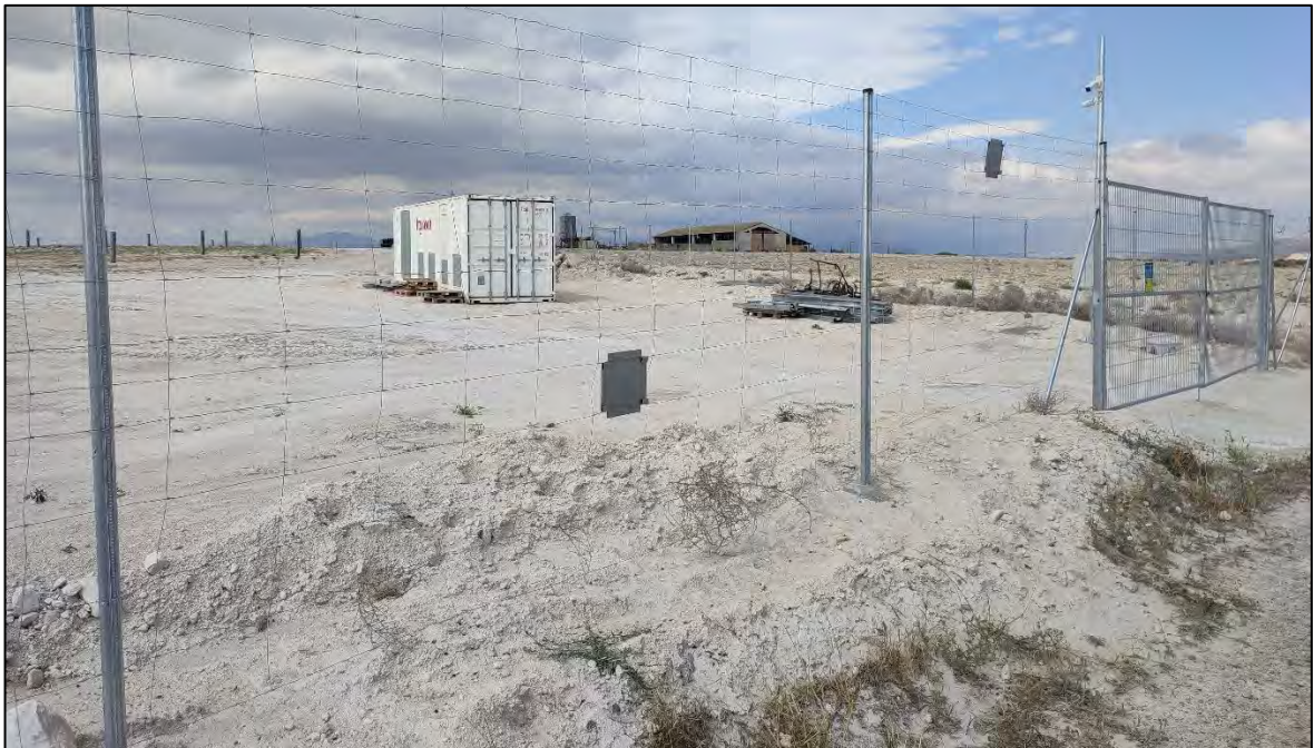
Ilustración 24. Colocación de las placas del vallado perimetral.
