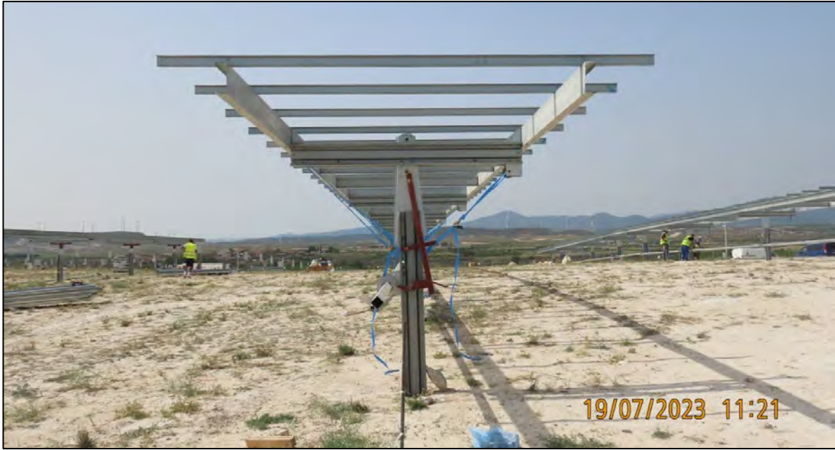
Ilustración 29. Montaje de estructuras de los seguidores.
