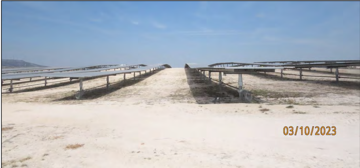
Ilustración 41. Finalización de la instalación de los paneles solares.
