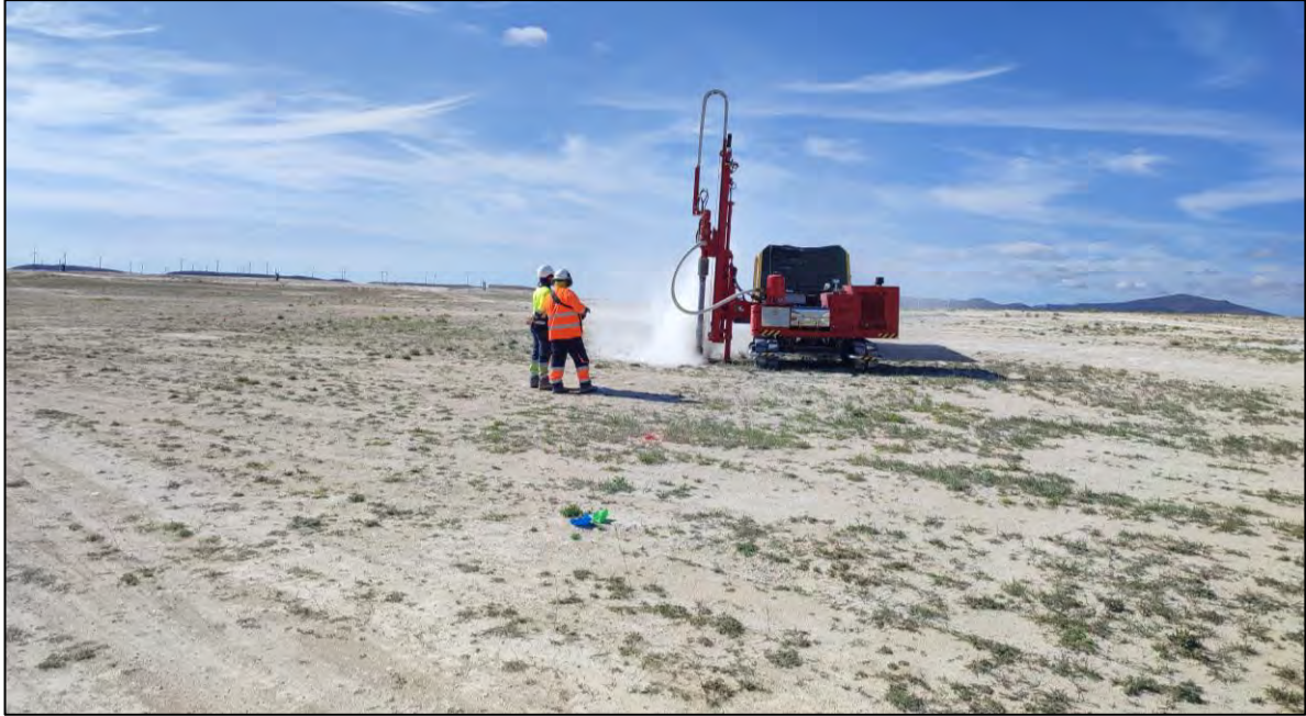
Ilustración 21. Trabajos de hincado con la hincadora.
