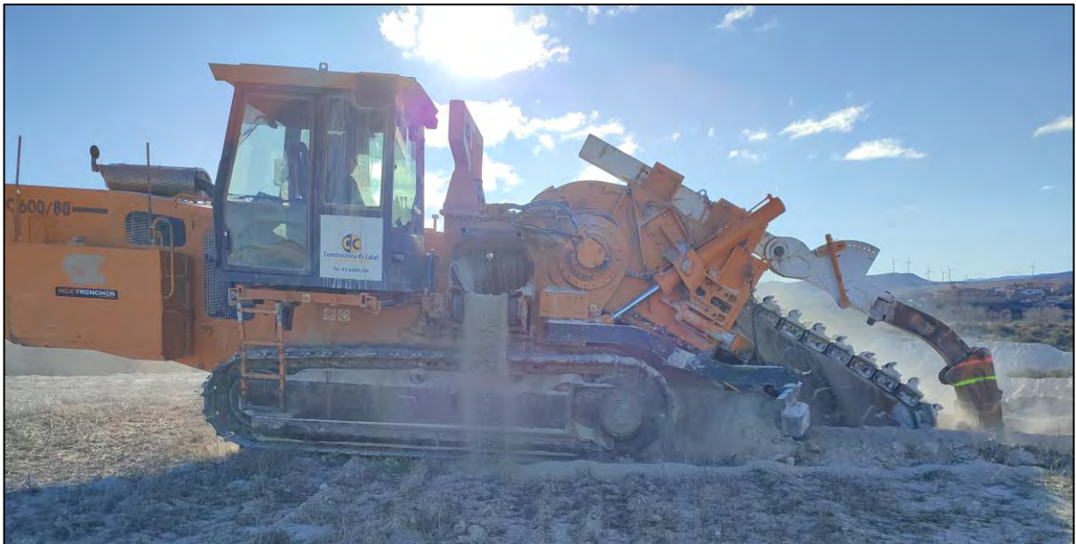
Ilustración 4. Apertura de zanjas con zanjadora.
