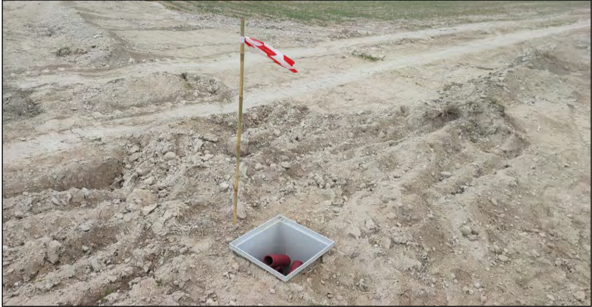
Ilustración 7. Colocación de elementos del PFV.
