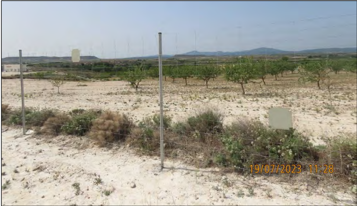
Ilustración 33. Vallado perimetral y placas visibilizadoras para la avifauna.
