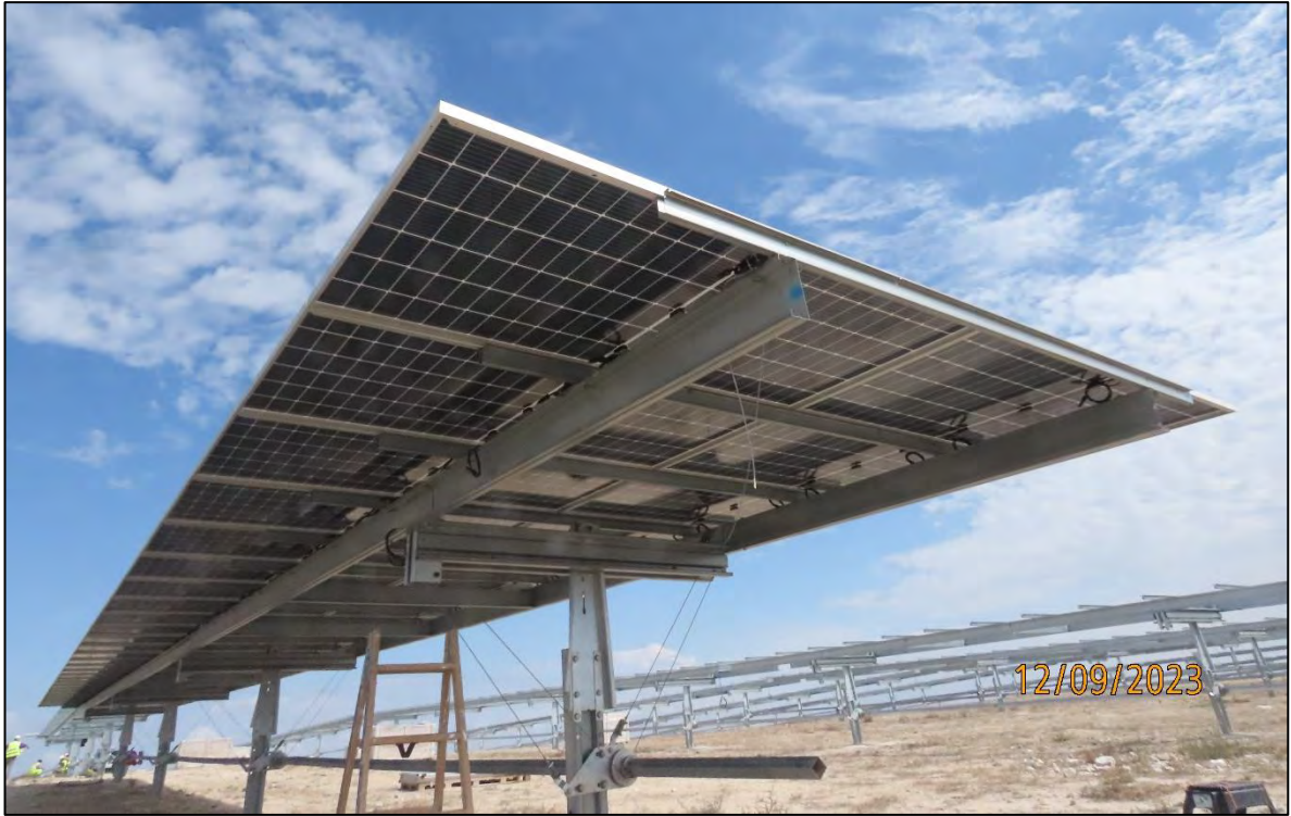
Ilustración 37. Colocación de los módulos fotovoltaicos.
