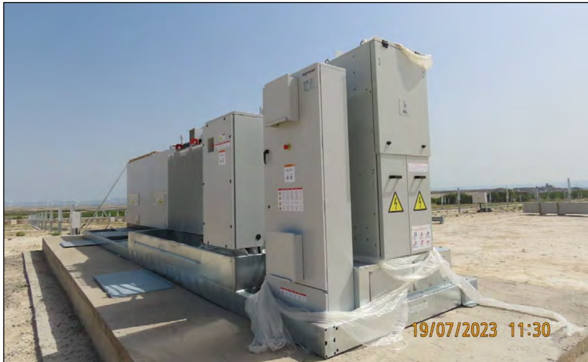
Ilustración 31. Colocación de las Power Station.
