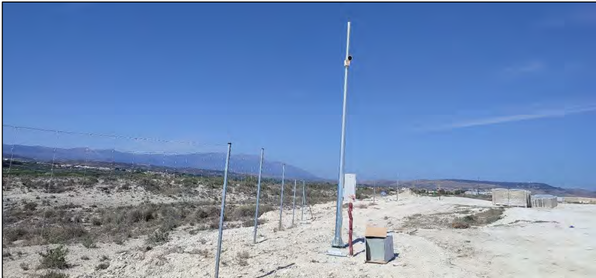
Ilustración 26. Ejecución del sistema de videovigilancia.
