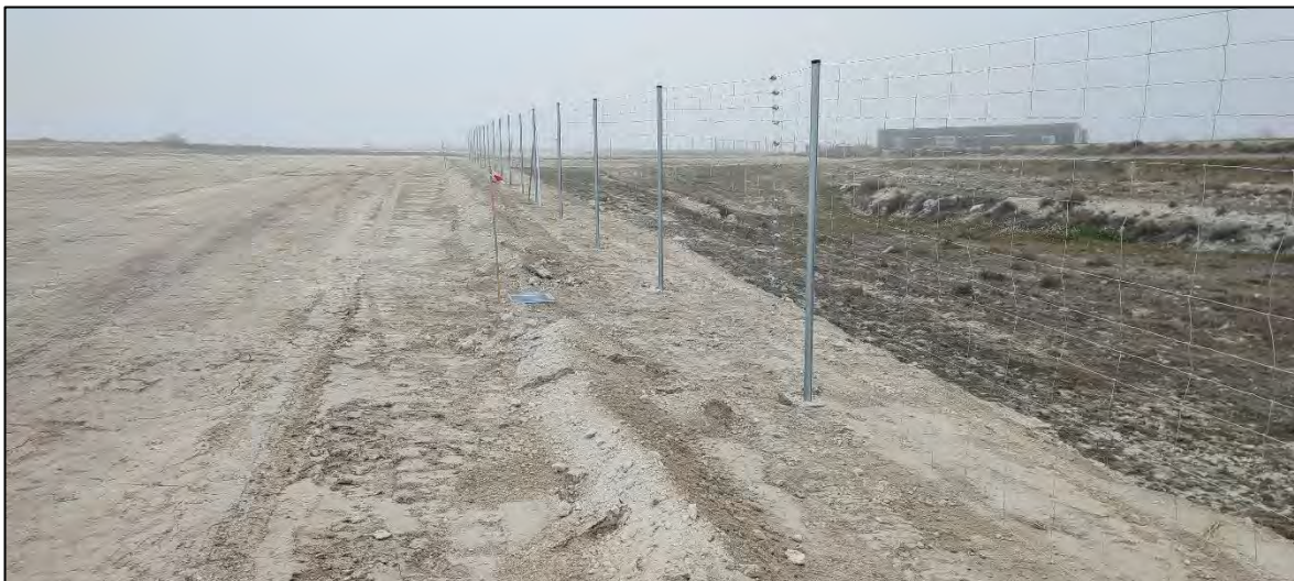
Ilustración 9. Ejecución del vallado perimetral.
