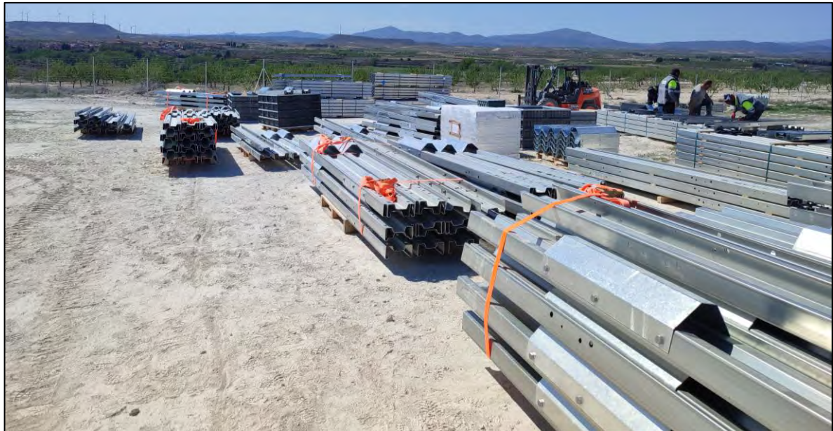
Ilustración 20. Recepción y acopio de las estructuras de los seguidores.
