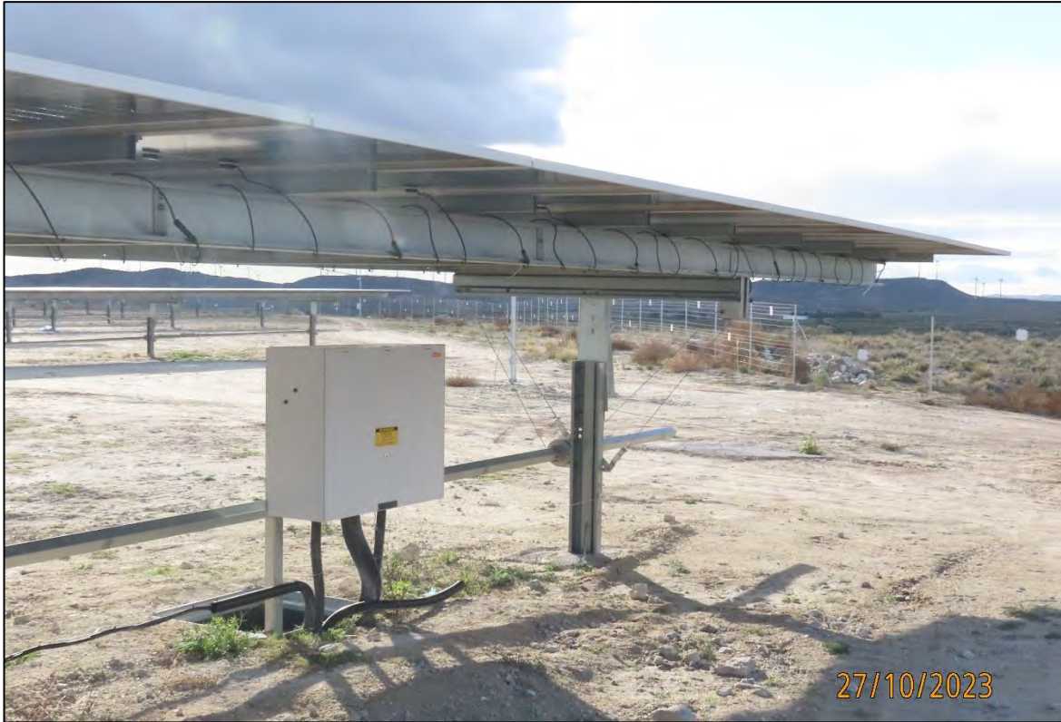
Ilustración 52. Línea de placas terminada.
