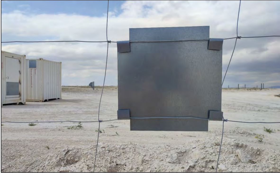
Ilustración 25. Placas que hacen visible el vallado a la avifauna.
