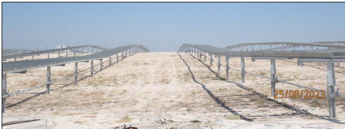
Ilustración 35. Estructuras de los seguidores ejecutadas.
