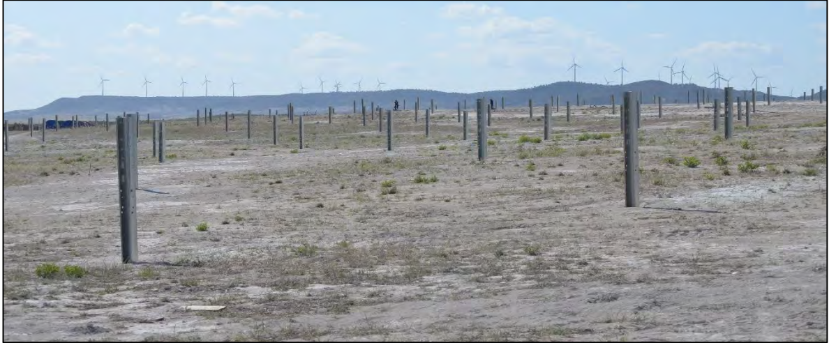
Ilustración 23. Finalización de los trabajos de hincado.
