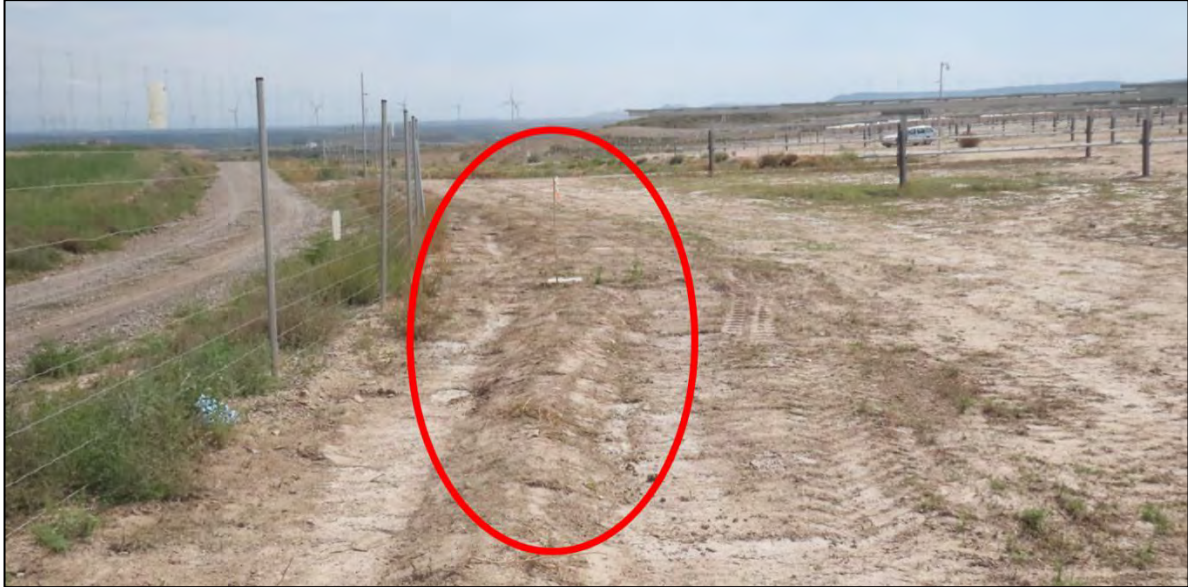
Ilustración 39. Restauración de regueros generados por lluvias intensas.
