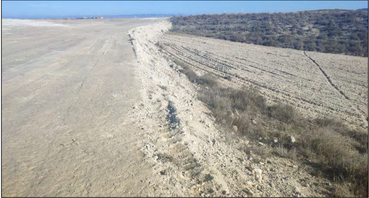
Ilustración 3. Preparación del terreno.
