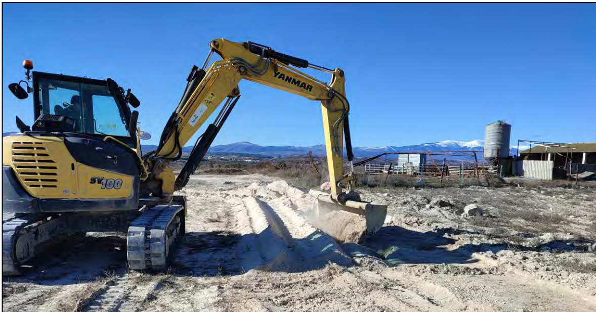
Ilustración 6. Tapado de zanjas.
