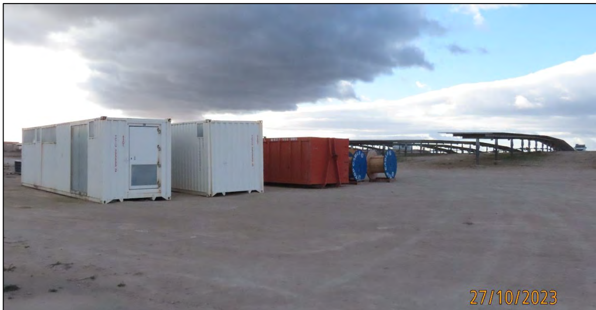
Ilustración 45. Zona de casetas de obra.
