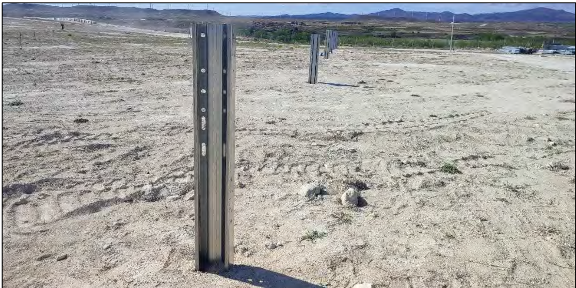
Ilustración 22. Hincas colocadas.
