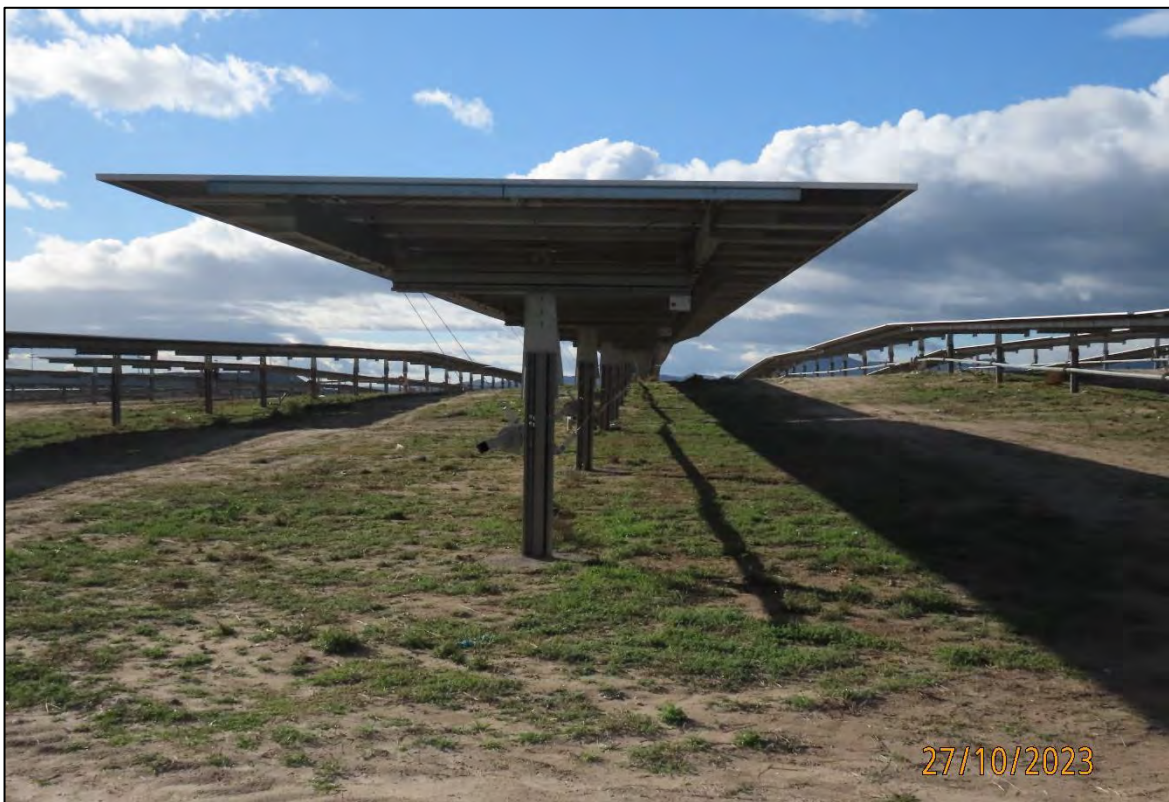
Ilustración 53. Líneas de placas y pasillos interiores.
