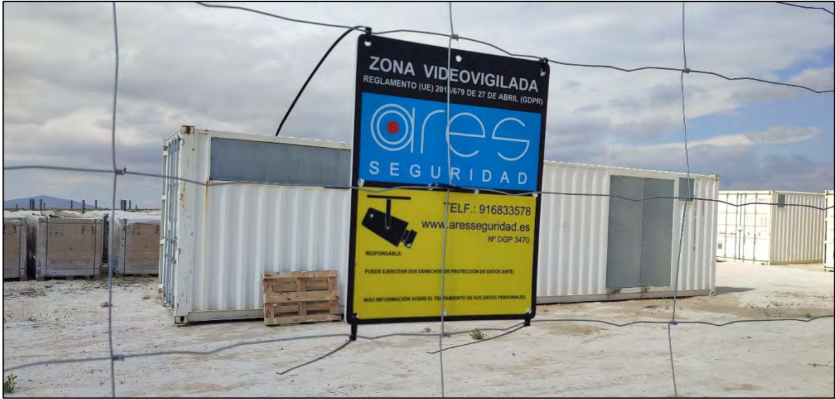
Ilustración 27. Señalización del sistema de seguridad.
