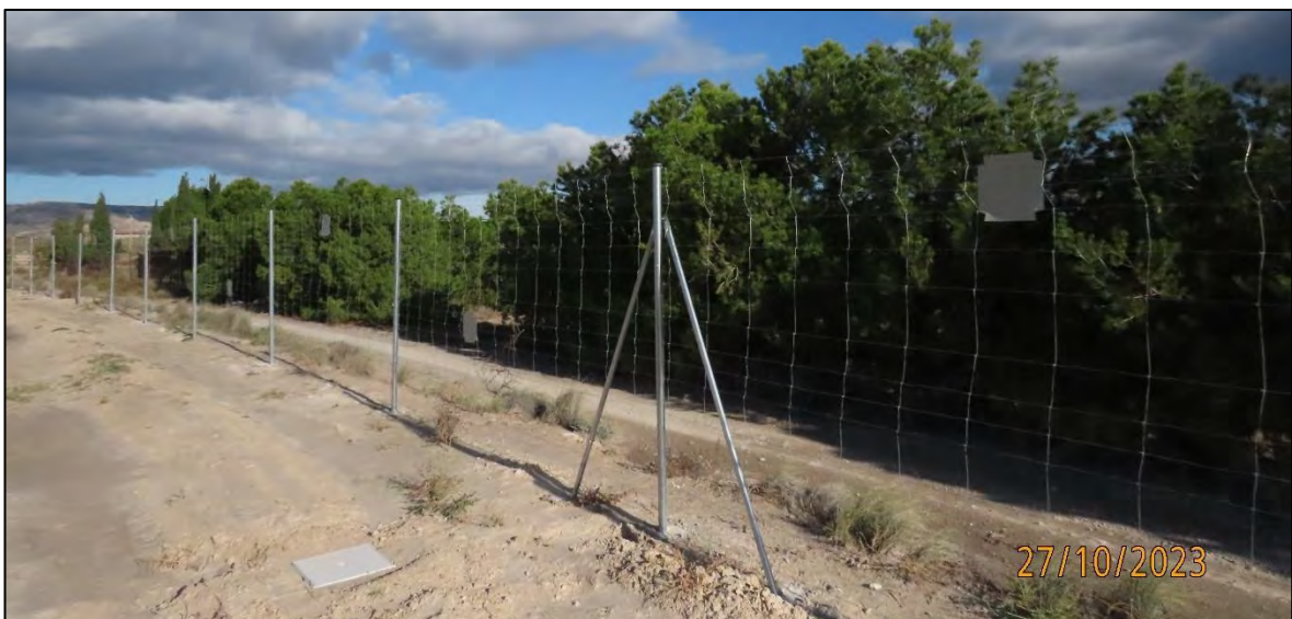
Ilustración 48. Vallado perimetral con sus placas para la avifauna.
