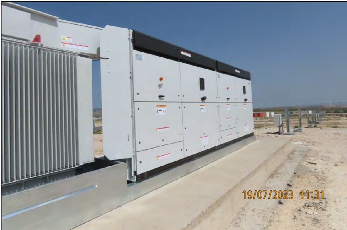
Ilustración 30. Colocación de las Power Station.
