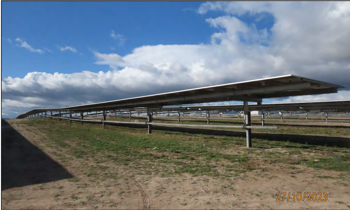
Ilustración 54. Líneas de placas y pasillos interiores.
