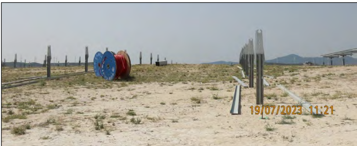
Ilustración 28. Montaje de estructuras de los seguidores.
