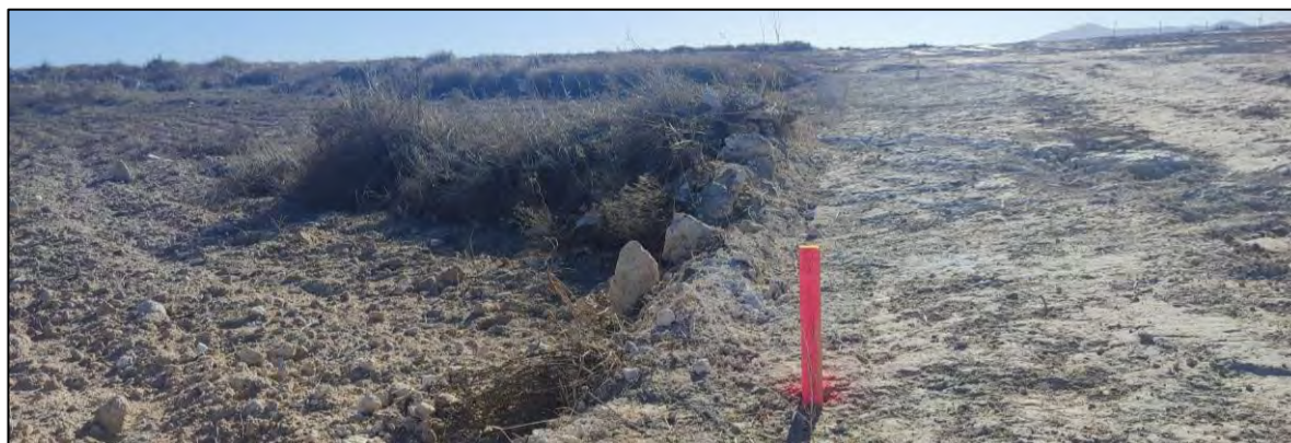
Ilustración 2. Balizamiento de las zonas de obra.
