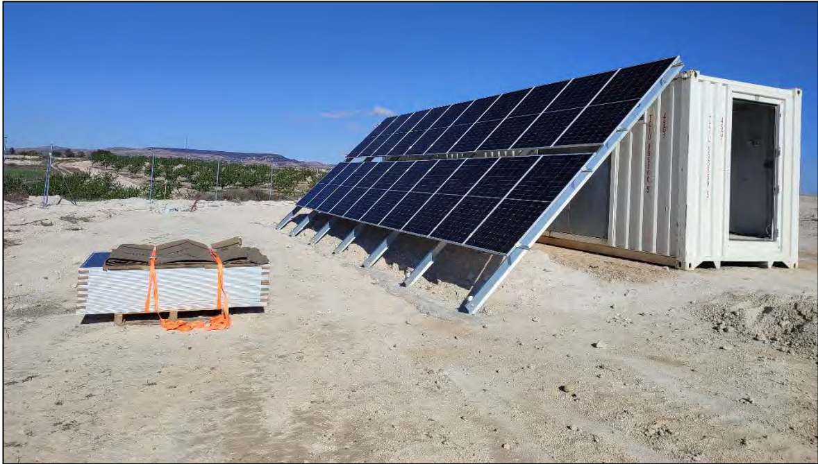
Ilustración 15. Colocación de sistema energético para las casetas de obra.
