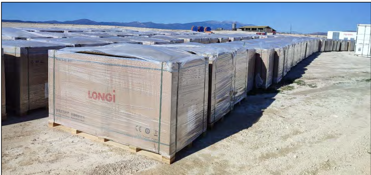
Ilustración 16. Recepción y acopio de los paneles solares.
