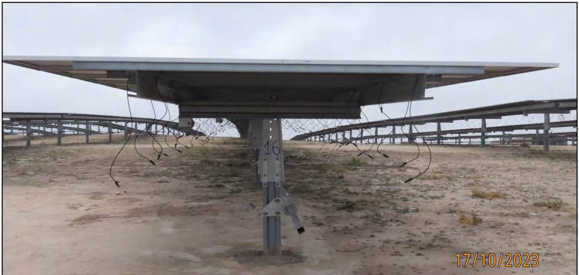
Ilustración 42. Finalización de la instalación de los paneles solares.
