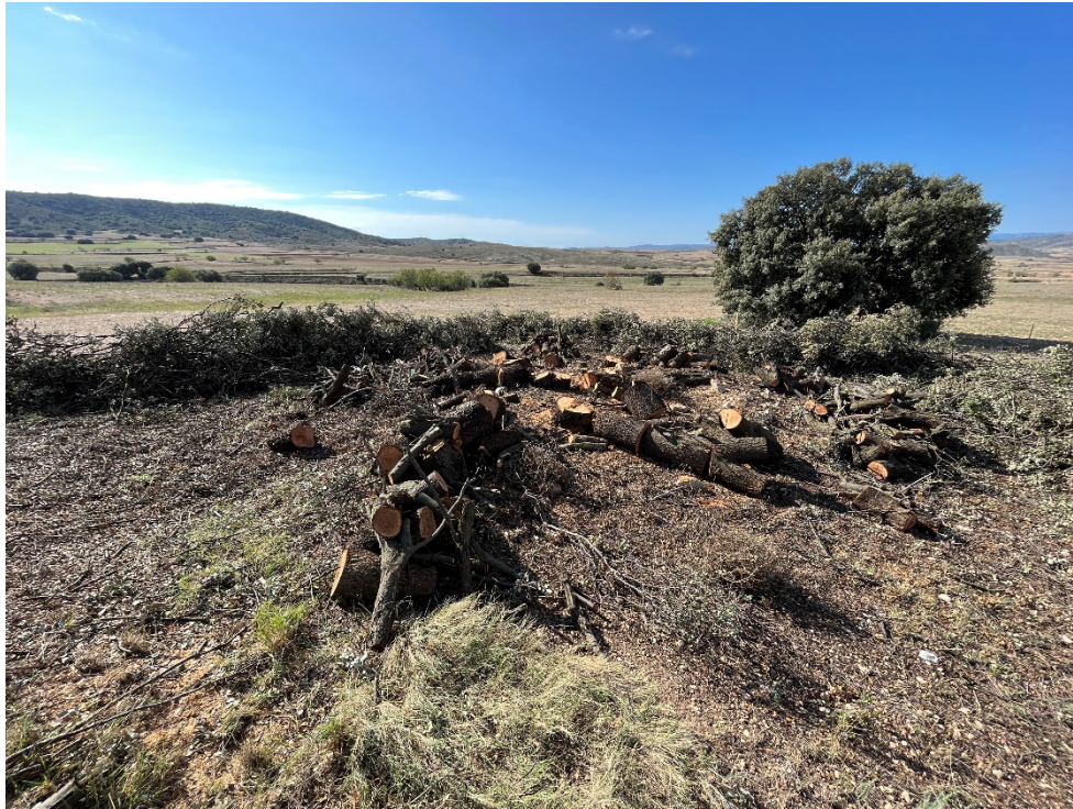
Figura 12 Tronzado de los rodales de encina presentes en la zona de implantación de la PSFV
