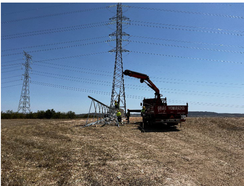
Figura 4 Montaje de los apoyos
