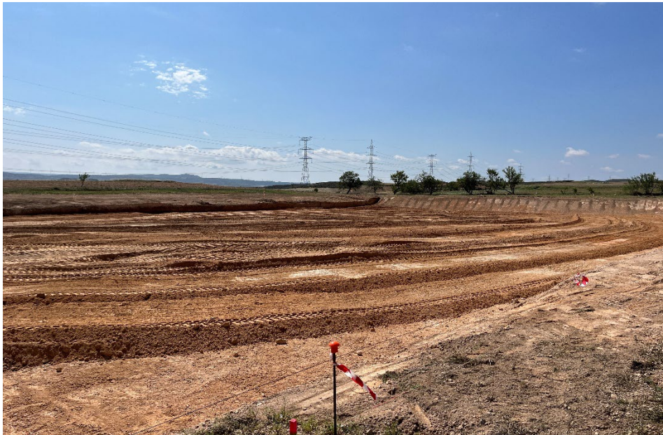
Figura 8 Movimientos de tierras SET Aguasvivas
