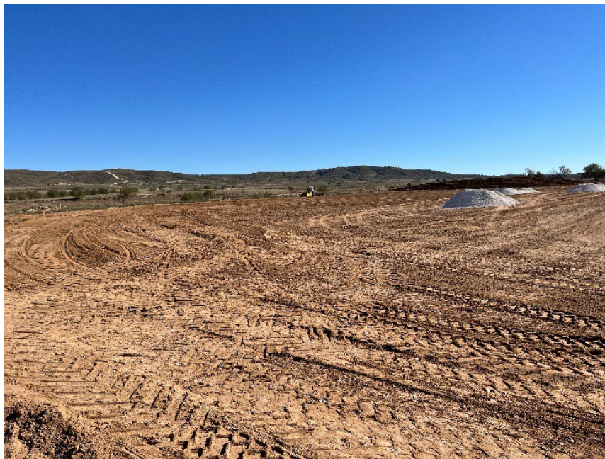
Figura 2 Habilitado de la campa de casetas y acopios
