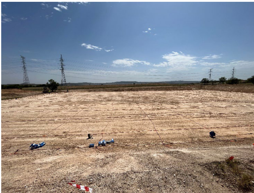
Figura 3 Tendido del cable de cobre
