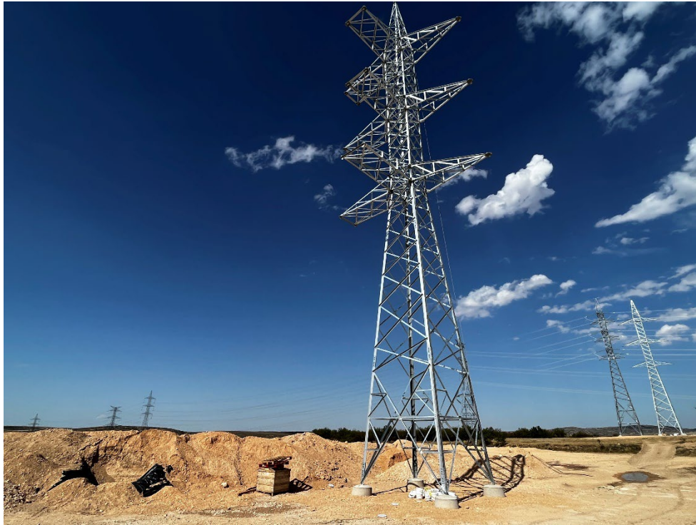
Figura 14 Izado de los apoyos de la LAAT
