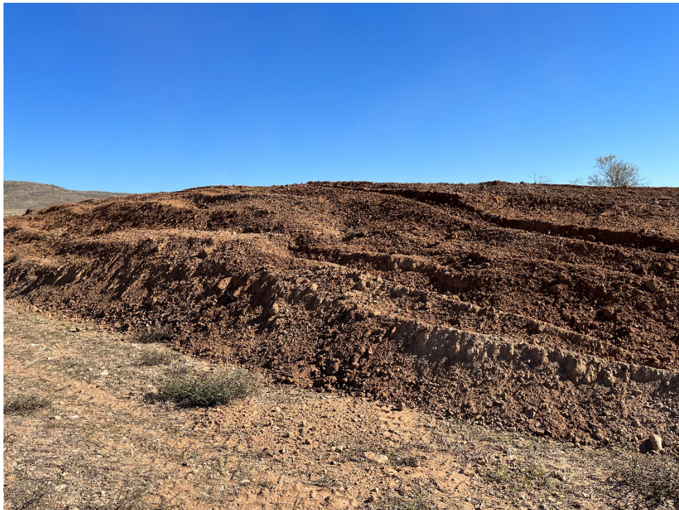
Figura 15 Acopio de tierra vegetal
