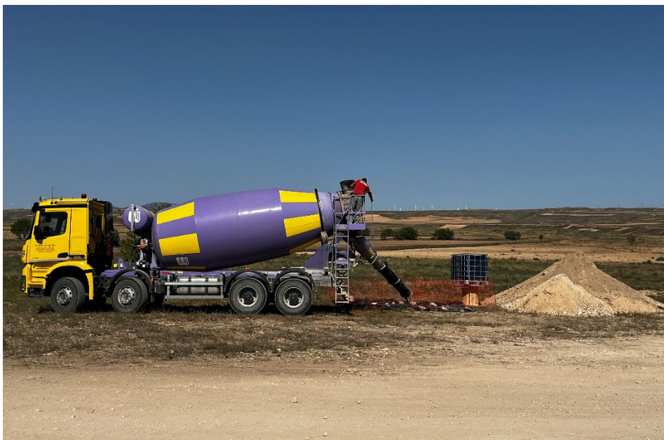
Figura 9 Limpieza de las cubas de hormigón
