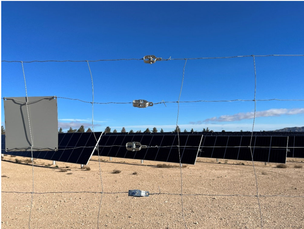
Figura 6 Vallado perimetral con elementos punzantes
