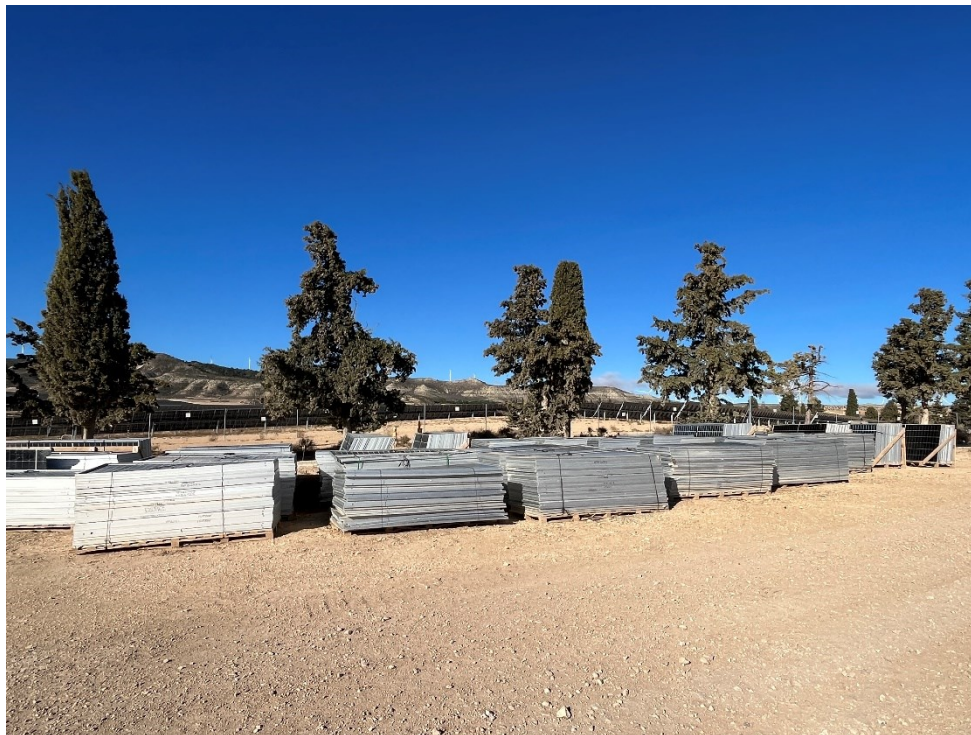
Figura 5 Acopio del material de construcción
