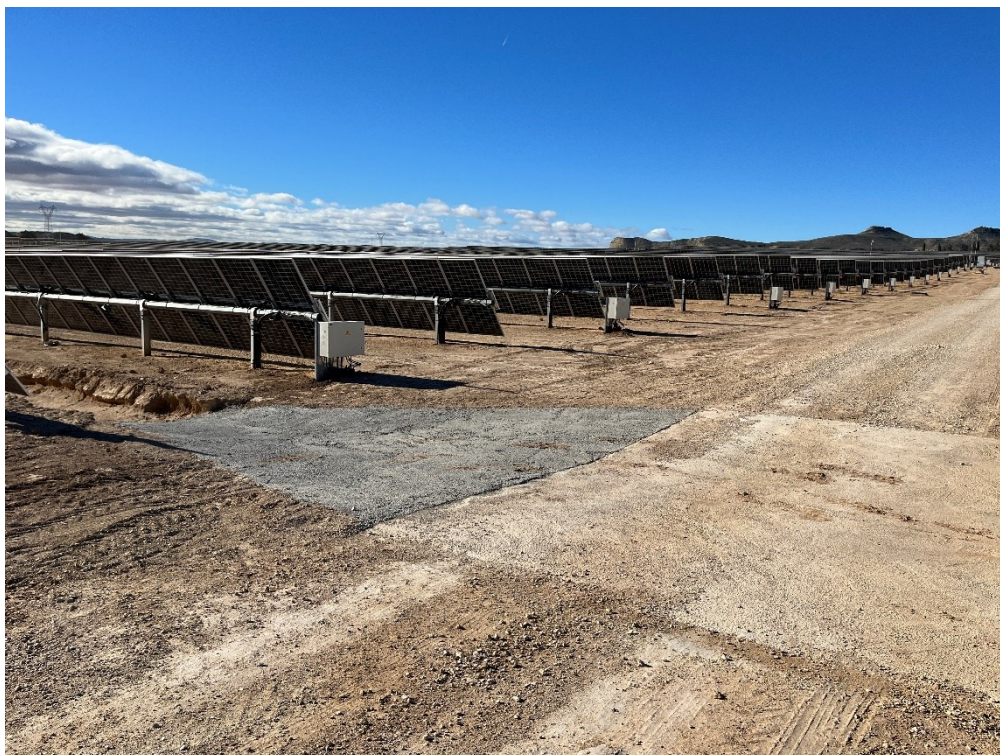
Figura 2 Cimentación del vial
