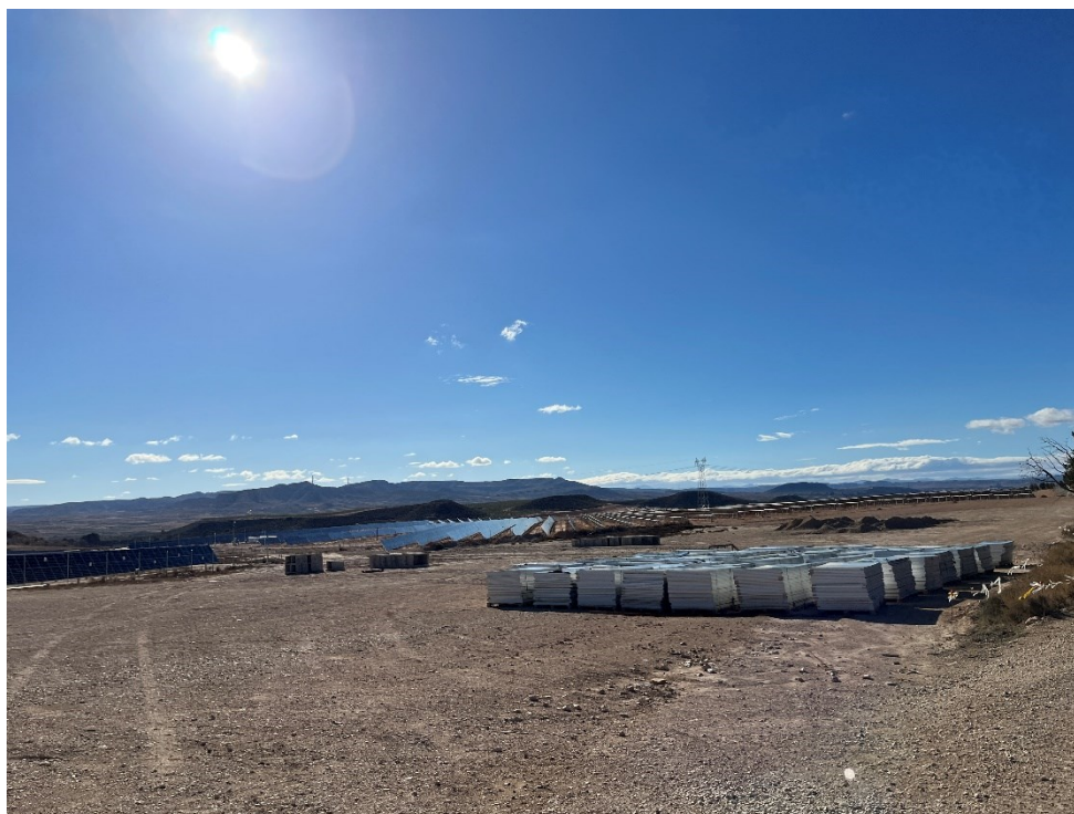
Figura 5 Acopio del material de construcción
