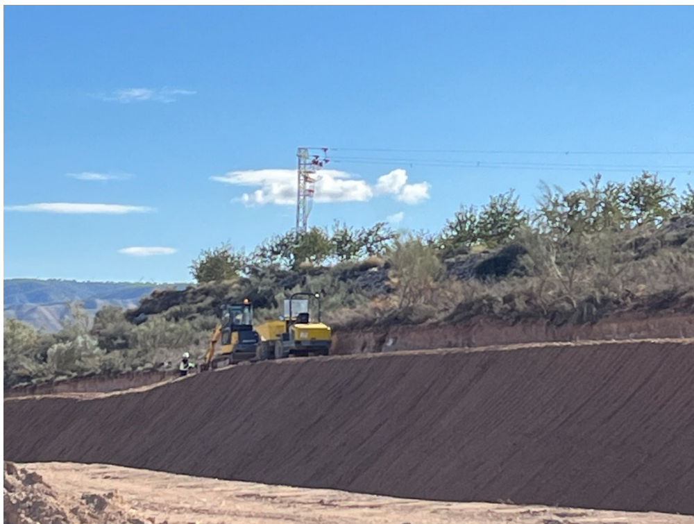
Figura 2 Apertura de cunetas
