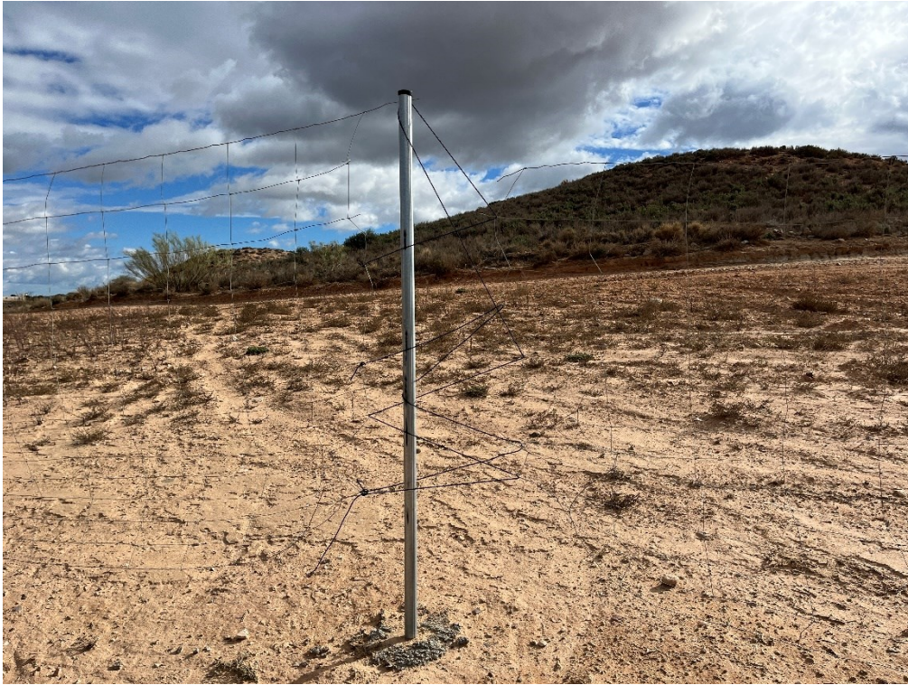
Figura 6 Vallado perimetral con elementos punzantes
