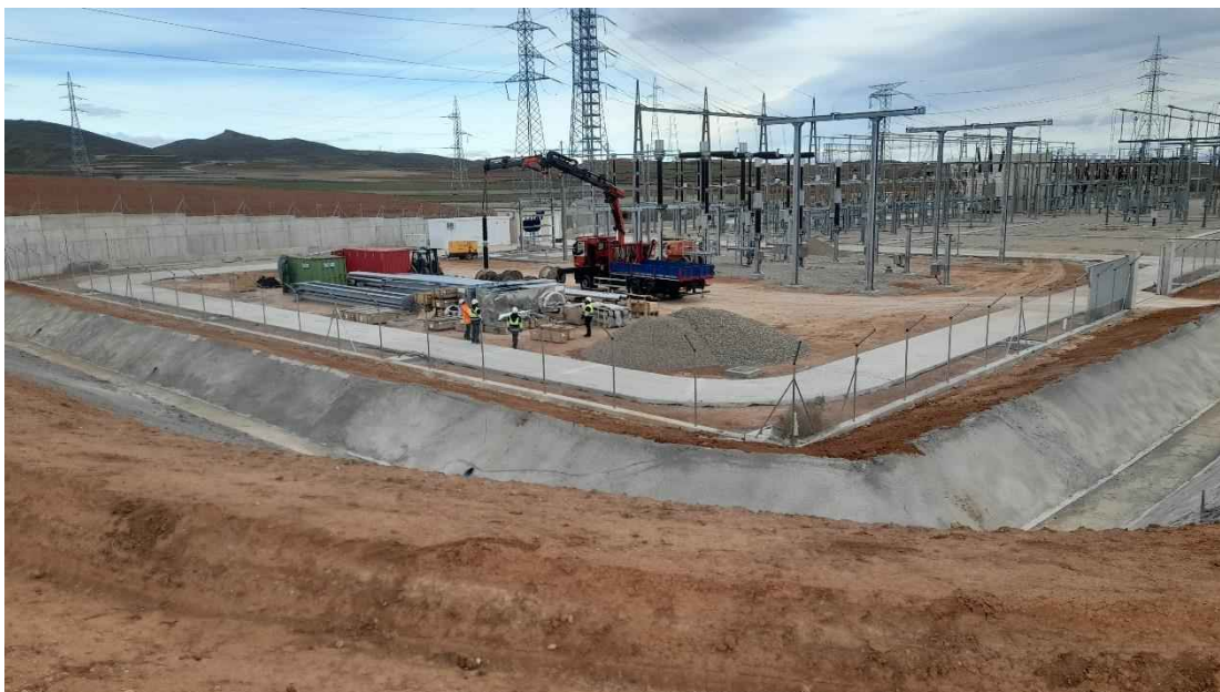
Foto 48. Vista general de la zona de obra. Mes de febrero 2023.
