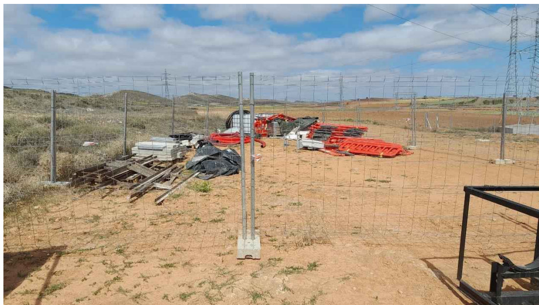
Foto 45. Zona de acopios.
