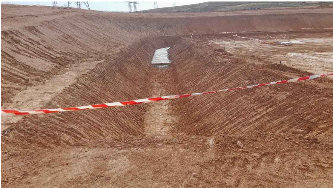
Foto 37. Avance de trabajos de cuneta de drenaje.
