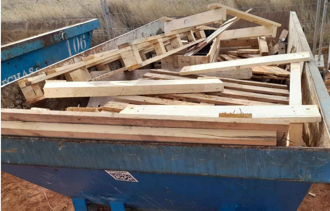
Foto 16. Zona de residuos de construcción y demolición (RCD). Contenedor de maderas.
