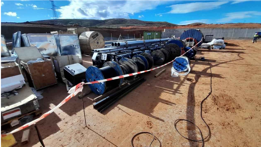
Foto 46. Acopios en zona de ejecución de la ampliación de la subestación.
