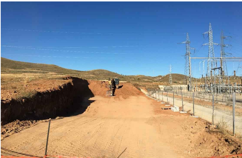
Foto 35. Excavación en Ampliación SET Muniesa.
