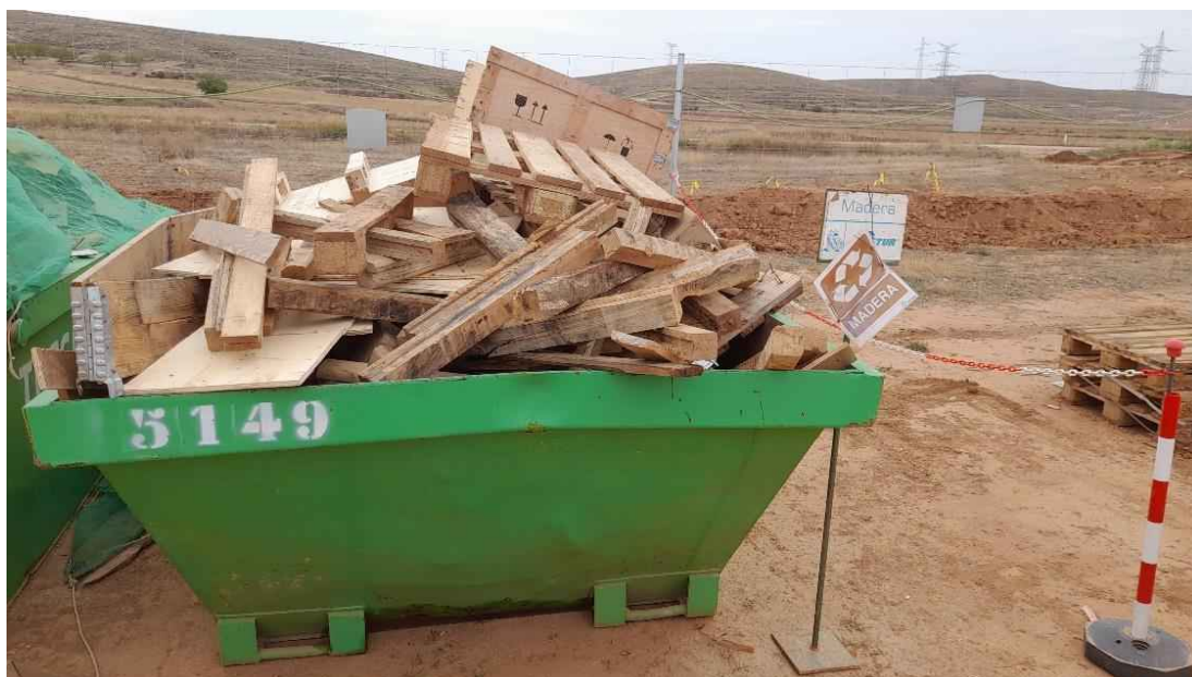
Foto 9. Zona de residuos de construcción y demolición (RCD). Contenedor de madera.
