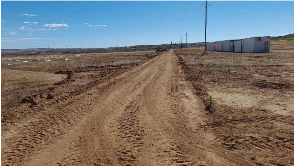
Foto 1. Avance de la ejecución de viales. Zona de oficinas localizada en la margen derecha y zona de seguidores en la margen izquierda (hincas depositadas en el suelo). Comienzo de la instalación.
