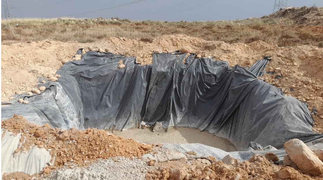
Foto 38. Zona de lavado de canaletas de camiones hormigonera
