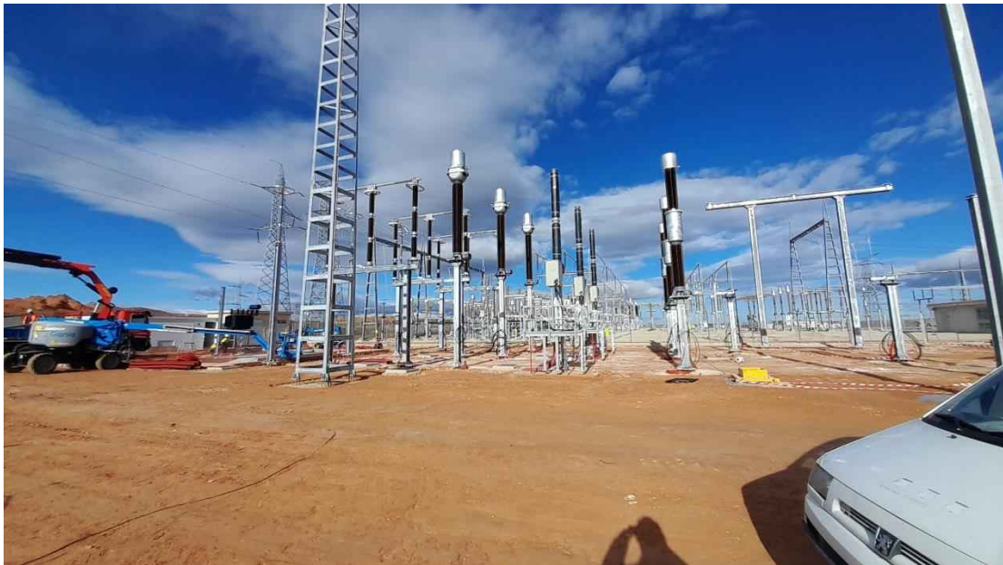
Foto 47. Avance del montaje de embarrados. Mes de diciembre 2022.
