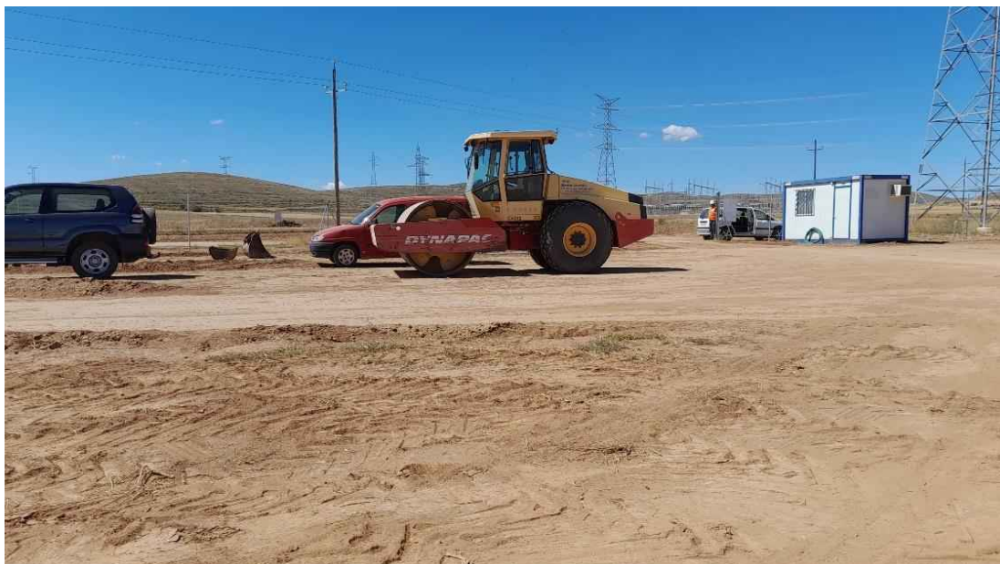
Foto 5. Compactador en zona de obra
