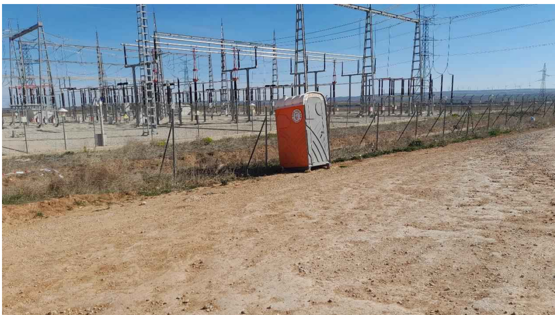
Foto 43. Baño químico instalado en las obras de la SET.
