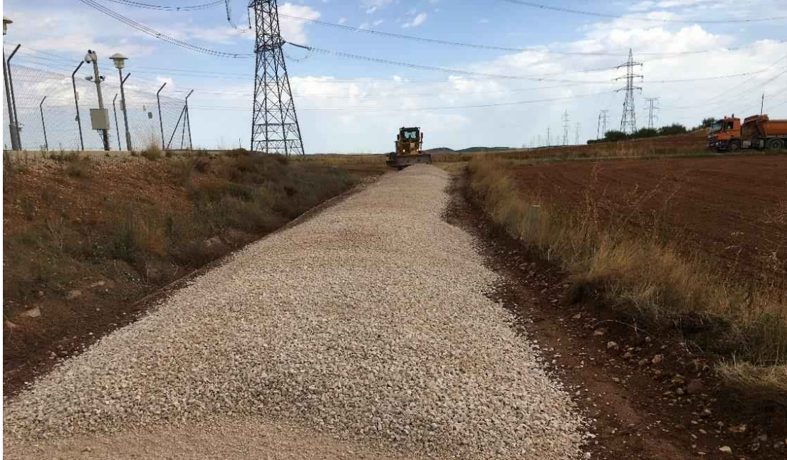
Foto 36. Ejecución de camino provisional de acceso en Ampliación SET Muniesa.
