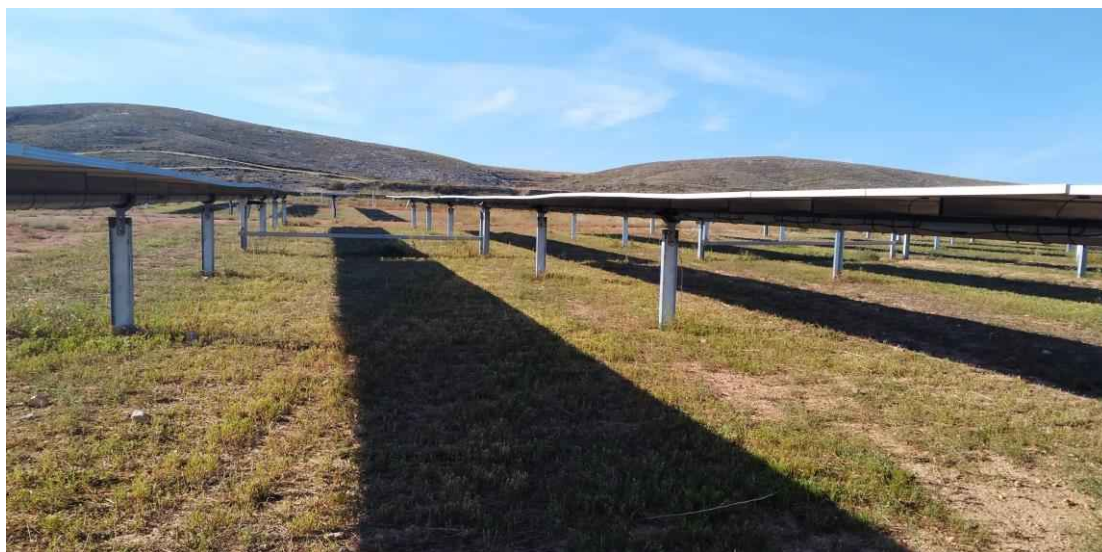
Foto 24. Aspecto de la cubierta vegetal bajo seguidores tras su desbroce
