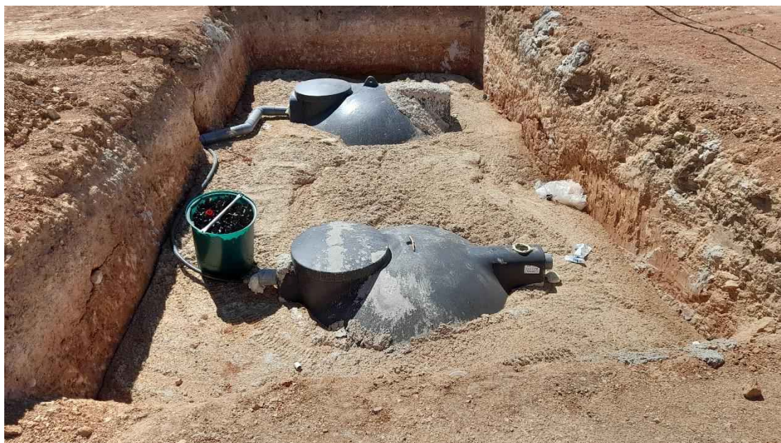
Foto 14. Progreso de la instalación de fosa séptica y depósito de agua para el edificio de control.
