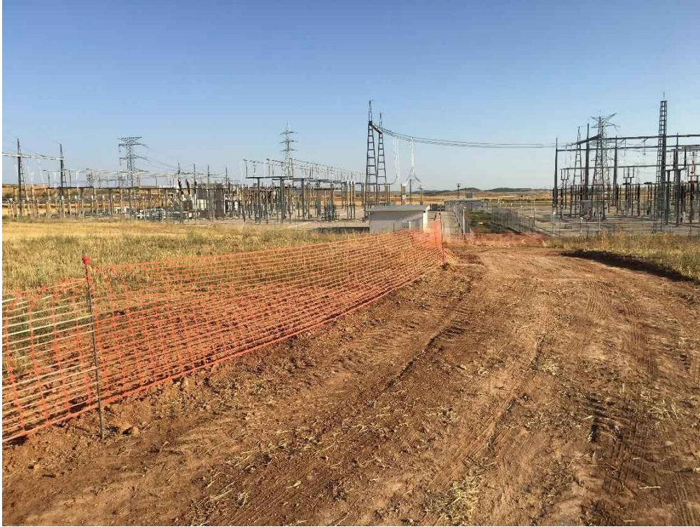
Foto 34. Balizamiento de obra en Ampliación SET Muniesa.
