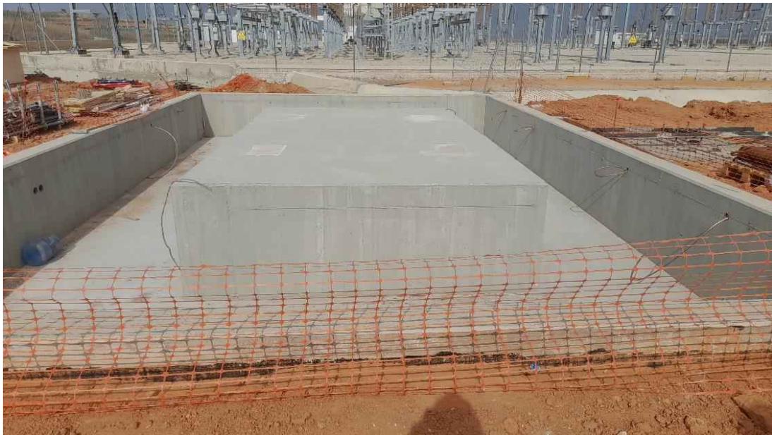
Foto 39. Vista de avance de trabajos de hormigonado
