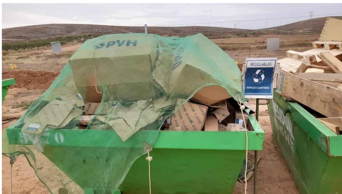
Foto 8. Zona de residuos de construcción y demolición (RCD). Contenedor de papel y cartón.
