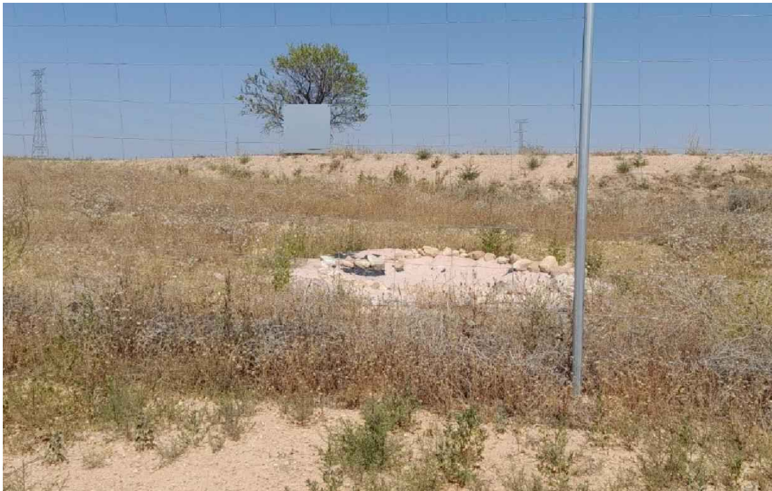
Foto 30. Balsa ejecutada en el perímetro de la planta
