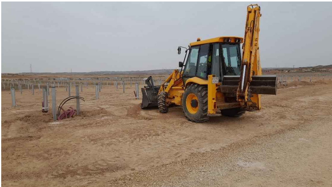
Foto 18. Trabajos de tapado de zanjas. Mes de octubre 2022.
