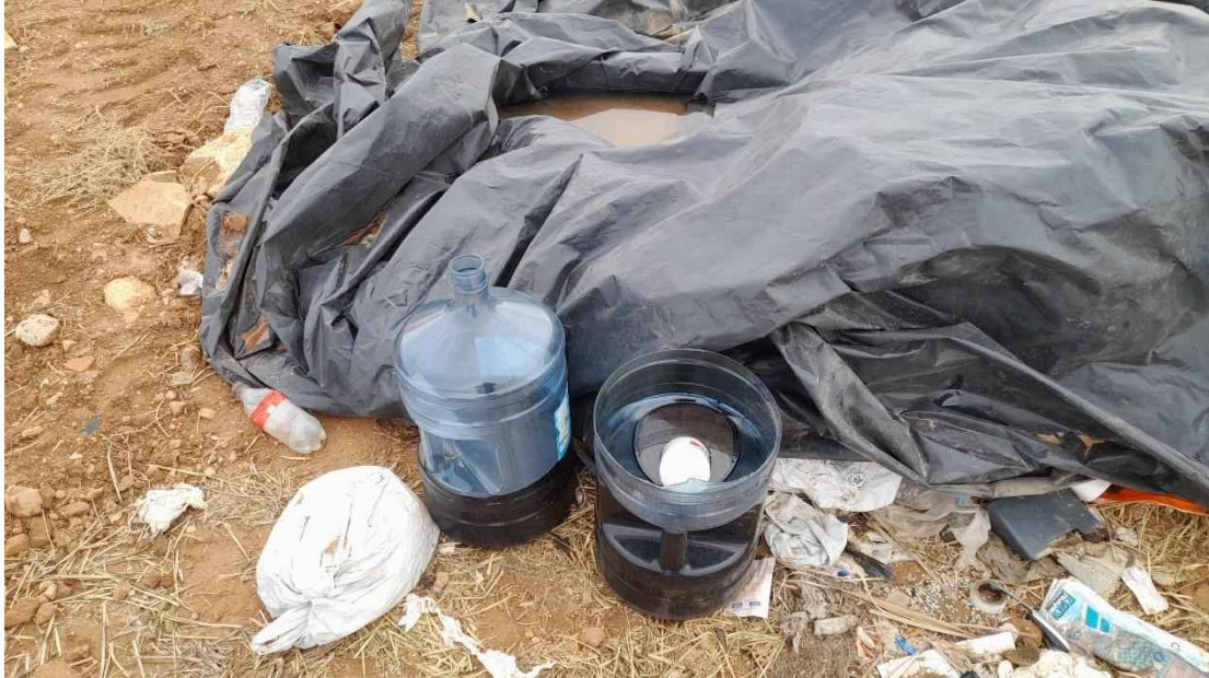
Foto 11. Evidencias de mantenimiento de maquinaria fuera de zona establecida para ello y almacenamiento de residuos peligrosos fuera de punto limpio (incidencia detectada en noviembre de 2022).
