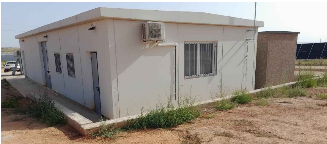
Foto 27. Oficina de O&M finalizada
