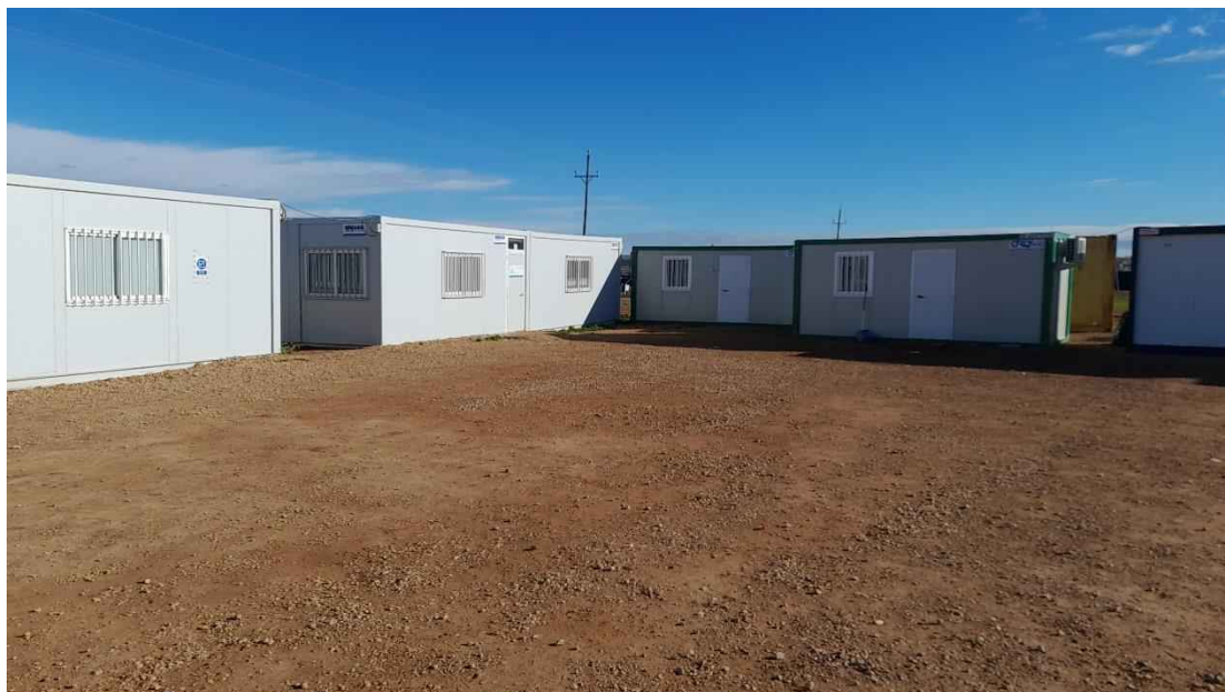
Foto 16. Vista general de área de oficinas
