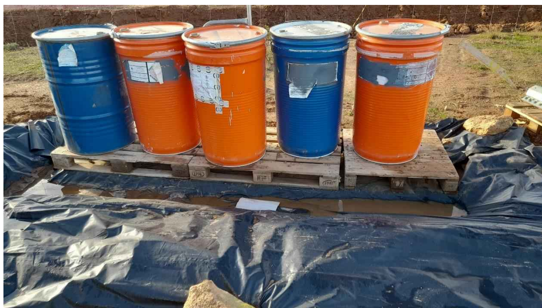
Foto 10. Contenedores para almacenamiento de residuos peligrosos
