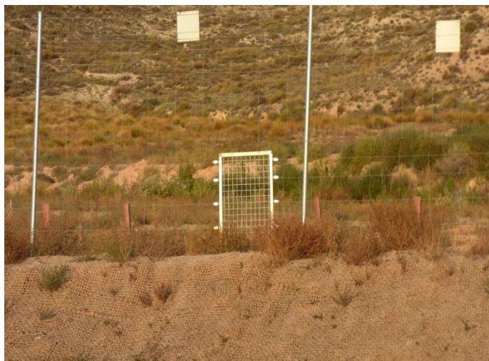
Imágenes 26 y 27. Paso de fauna con puerta (imagen izquierda), y paso de fauna con puerta dañada por las obras (imagen derecha).
