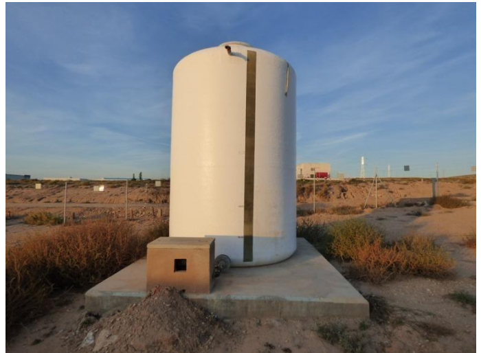
Imágenes 1 y 2. Depósito estanco en el que se almacenan las aguas residuales, y depósito de agua limpia (imágenes izquierda y derecha respectivamente).
