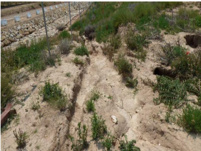
Imágenes 15 y 16. Proceso erosivo ocasionado por la escorrentía superficial durante el mes de junio (imagen izquierda). Medida correctiva implementada durante el mes de agosto, destinada a la prevención de futuros eventos erosivos (imagen derecha).
