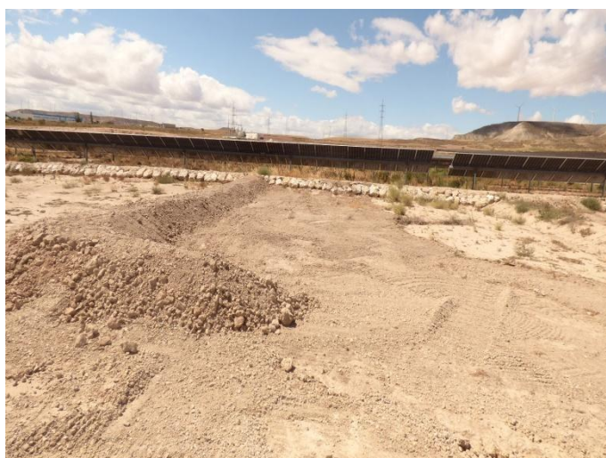
Imagen 19. Dique de tierra reparado y modificado.
