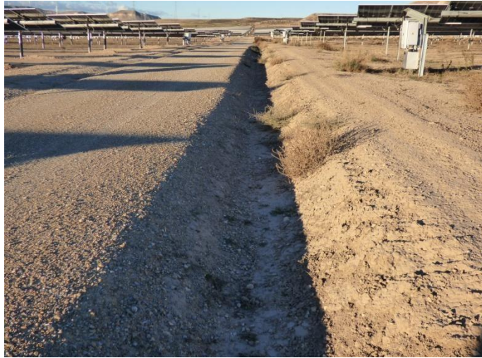
Imagen 4. Cuneta paralela a algunos de los viales internos.
