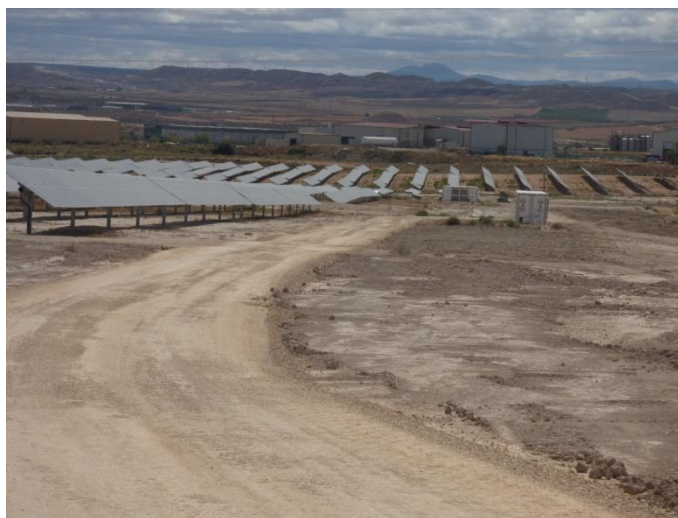
Imagen 10. Vial interno cuyo trazado se ha desplazado para evitar que resulte afectado por procesos erosivos.
