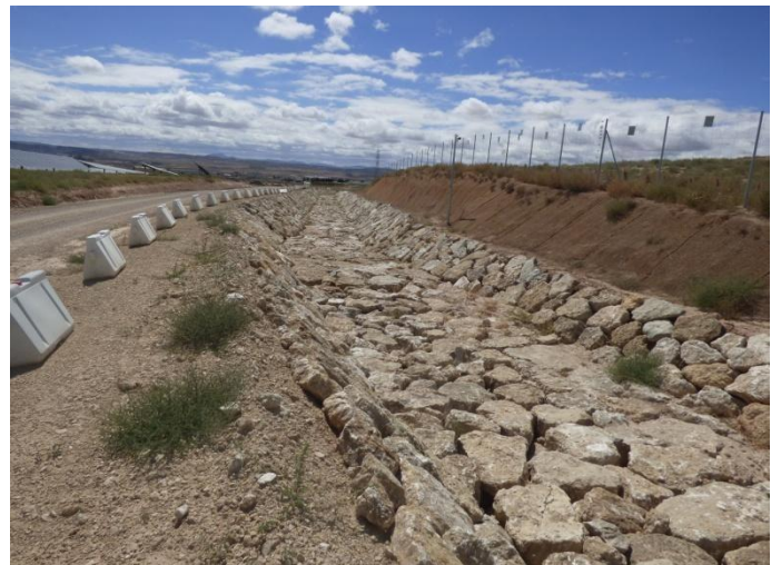
Imágenes 5 y 6. Zanja de drenaje encachada dirección Norte-Sur dentro de la planta fotovoltaica.
