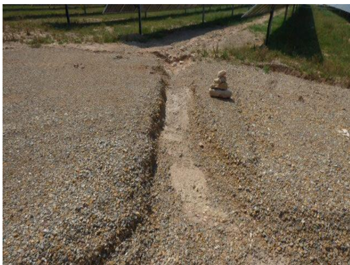
Imágenes 11 y 12. Proceso erosivo ocasionado por las lluvias torrenciales del mes de junio (imagen izquierda). Medida correctiva aplicada durante el mes de agosto (imagen derecha).
