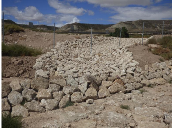
Imágenes 15 y 16. Proceso erosivo ocasionado por la escorrentía superficial durante el mes de junio (imagen izquierda). Medida correctiva implementada durante el mes de agosto, destinada a la prevención de futuros eventos erosivos (imagen derecha).
