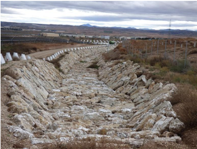
Imágenes 5 y 6. Zanja de drenaje encachada dirección Norte-Sur dentro de la planta fotovoltaica.
