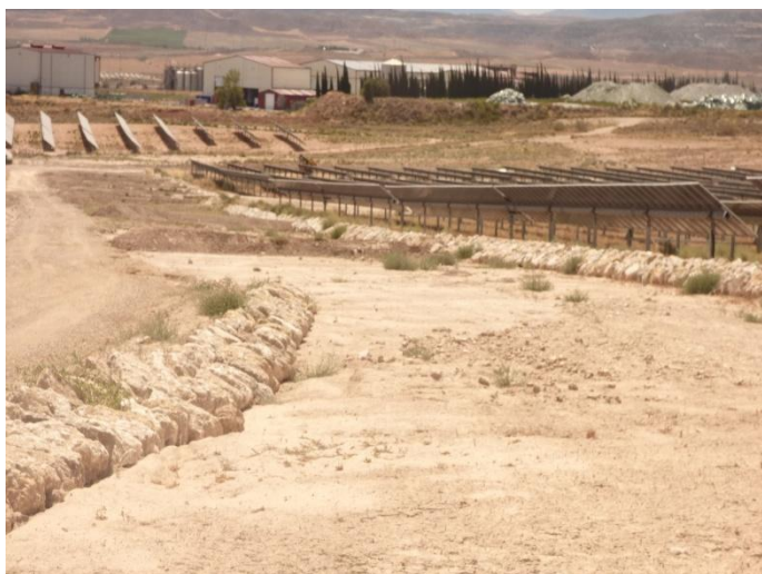
Imágenes 17 y 18. Incremento del número de diques de contención en tierra, ubicados al final de la zanja de drenaje dirección norte-sur. Vistos desde la cara norte (imagen izquierda), y vistos desde la cara sur (imagen derecha).
