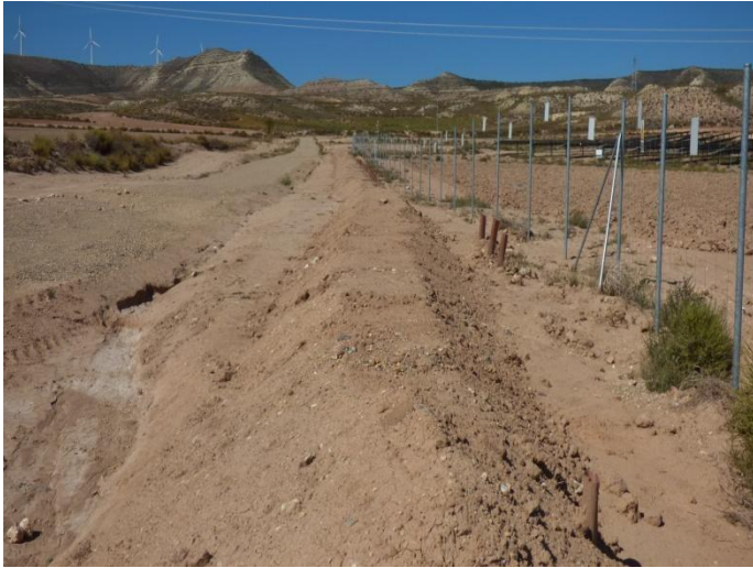
Imágenes 13 y 14. Dique de tierra paralelo al vallado junto a la entrada de la planta fotovoltaica (imagen izquierda). Dique de tierra en la cara norte y este de los inversores (imagen derecha).
