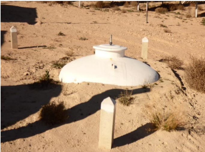
Imágenes 1 y 2. Depósito estanco en el que se almacenan las aguas residuales, y depósito de agua limpia (imágenes izquierda y derecha respectivamente).
