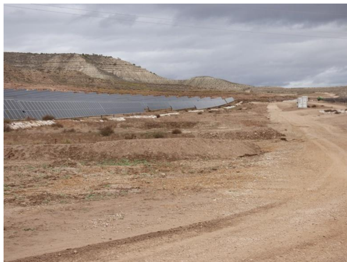
Imágenes 17 y 18. Incremento del número de diques de contención en tierra, ubicados al final de la zanja de drenaje dirección norte-sur. Vistos desde la cara norte (imagen izquierda), y vistos desde la cara sur (imagen derecha).
