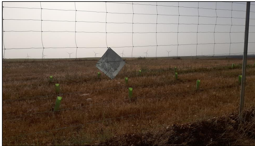
Figura 19: Placa anticollisión descolgada parcialmente.
