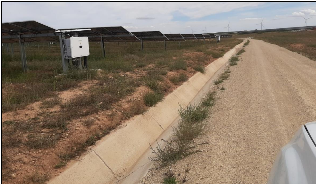
Figura 27: Canal de drenaje en buen estado en el la PSFV
