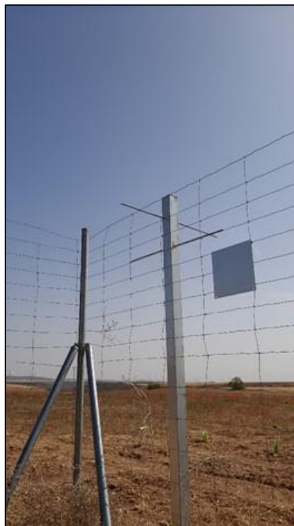
Figura 10: Ejemplo de poste posadero instalado en uno de los vértices del perímetro de la instalación.
