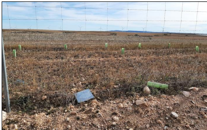
Figura 20: Placa anticollisión descolgada y tendida en el suelo.
