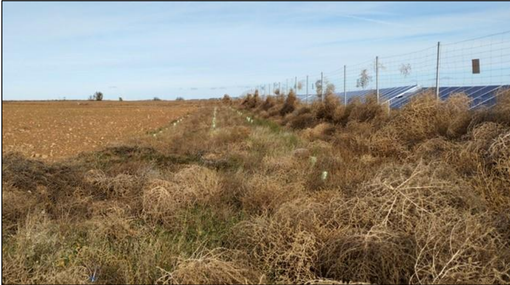
Figura 33: Vegetación rodada acumulada contra el vallado de la PSFV en su cara externa.
