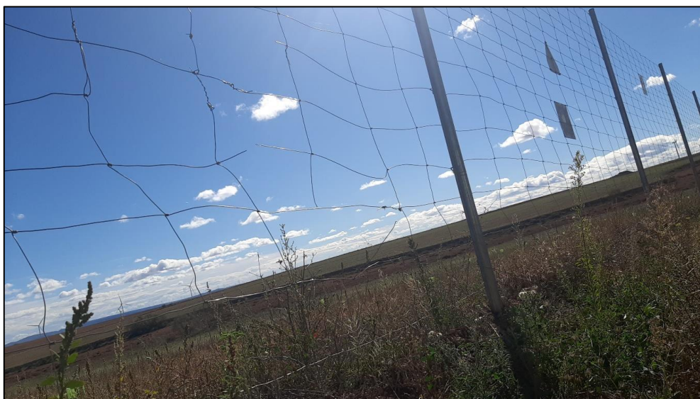
Figura 29: Tramo del vallado con pequeñas roturas.
