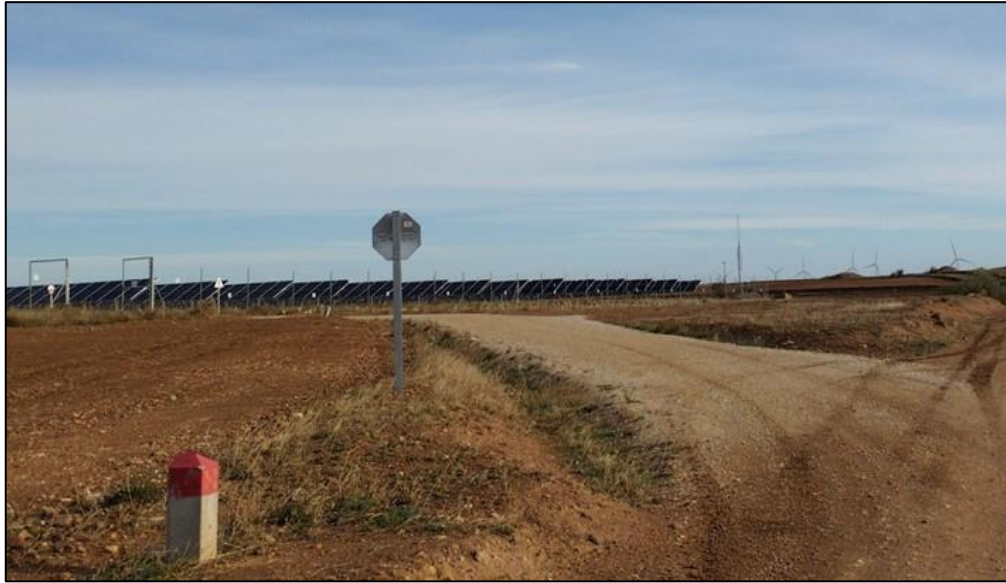
Figura 26: Vial exterior de acceso
