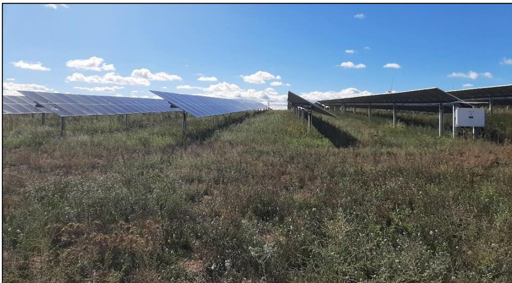
Figura 18: Vegetación entre las filas de paneles solares en el mes de octubre.
