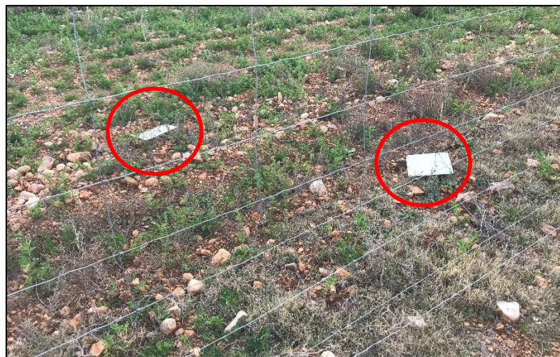
Figura 13: Varias placas anticolidión descolgadas y tendidas en el suelo.
