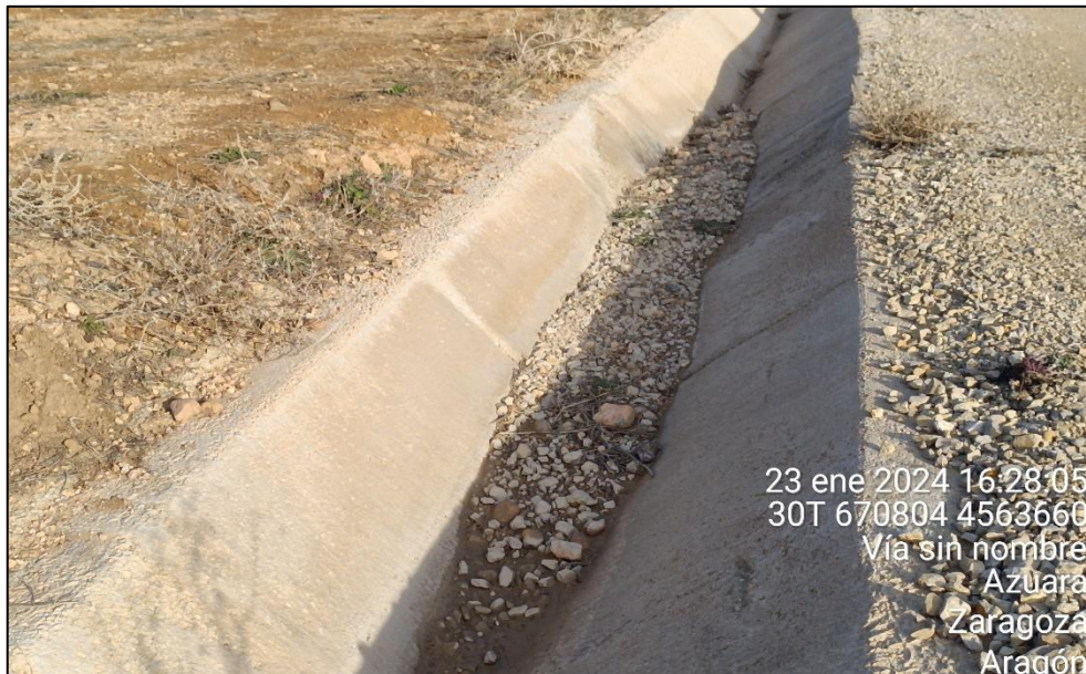
Figura 22: Canal de drenaje con pequeña acumulación de sedimentos y grava.
