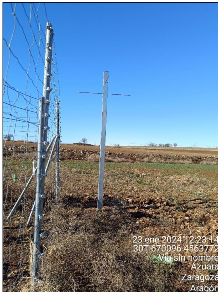
Figura 6: Ejemplo de poste posadero instalado en uno de los vértices del perímetro de la instalación.
