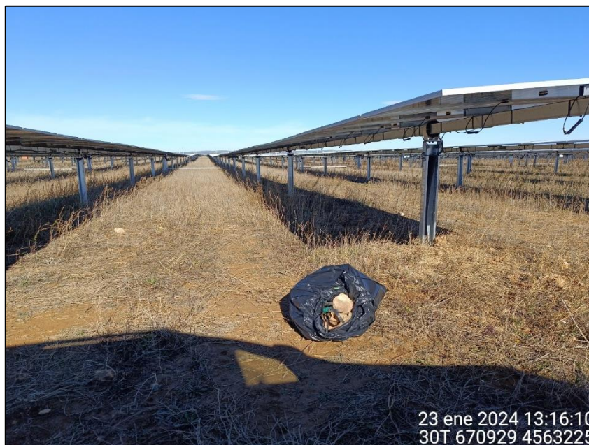
Figura 18: Bolsa con residuos depositada en el interior del recinto de la PSFV.
