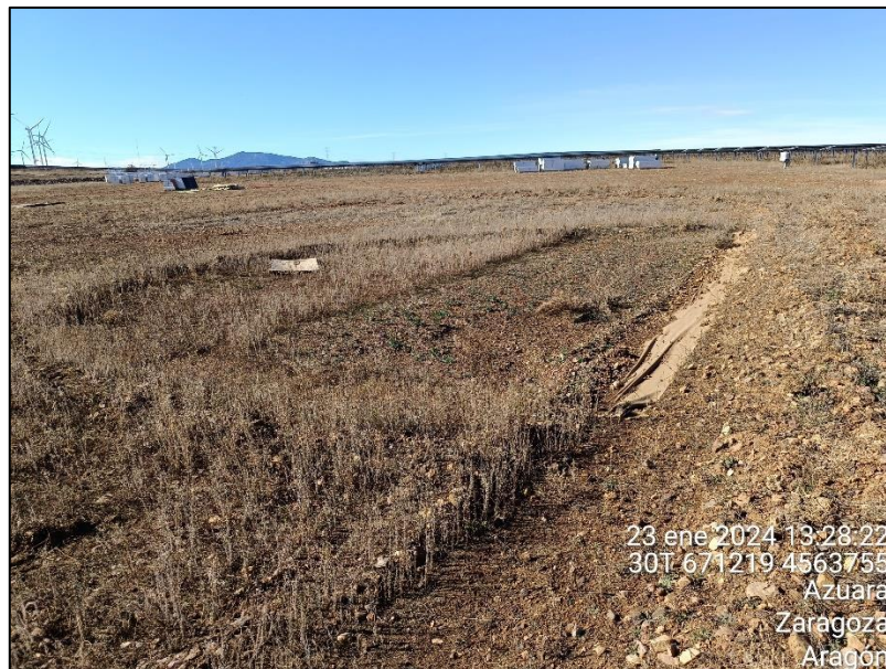
Figura 11: Balsete construido en el interior del perímetro de la PSFV Tico Solar I.
