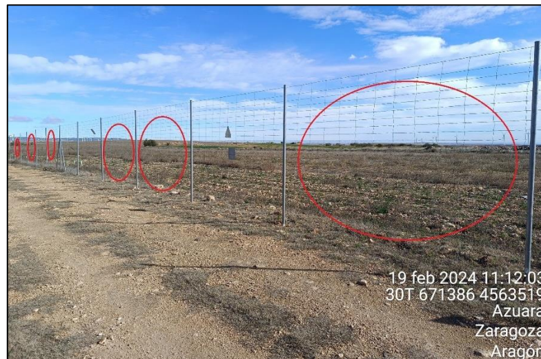
Figura 12: Tramo de vallado de la cara este de la PSFV en el que faltan numerosos paneles anticolidión.
