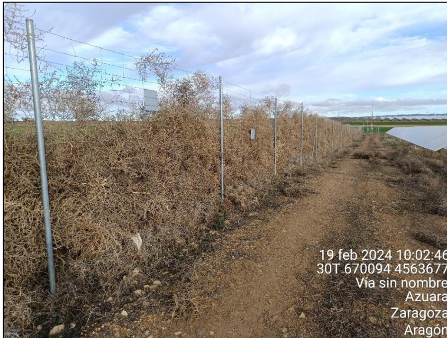
Figura 25: Vegetación rodada acumulada contra el vallado de la PSFV en su cara externa.
