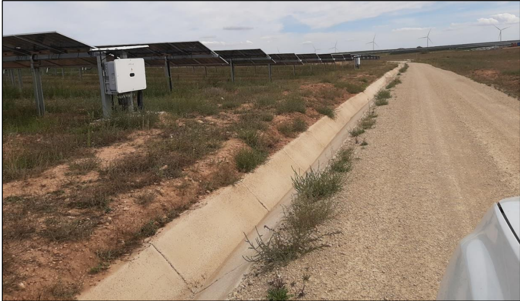
Figura 33: Canal de drenaje en buen estado en el la PSFV
