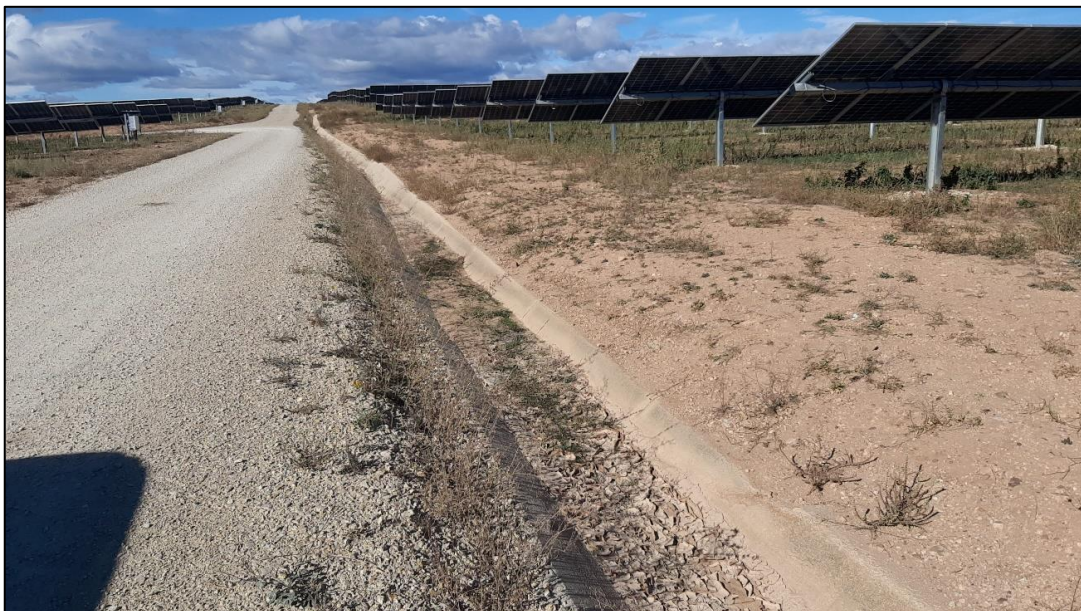
Figura 34: Canal de drenaje con pequeña acumulación de sedimentos en octubre de 2023 tras un episodio de lluvias.
