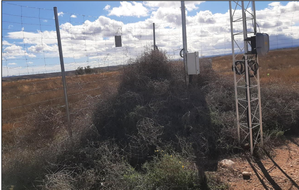
Figura 39: Vegetación rodada acumulada en una esquina dentro del perímetro vallado de la PSFV cubriendo parcialmente estructuras eléctricas
