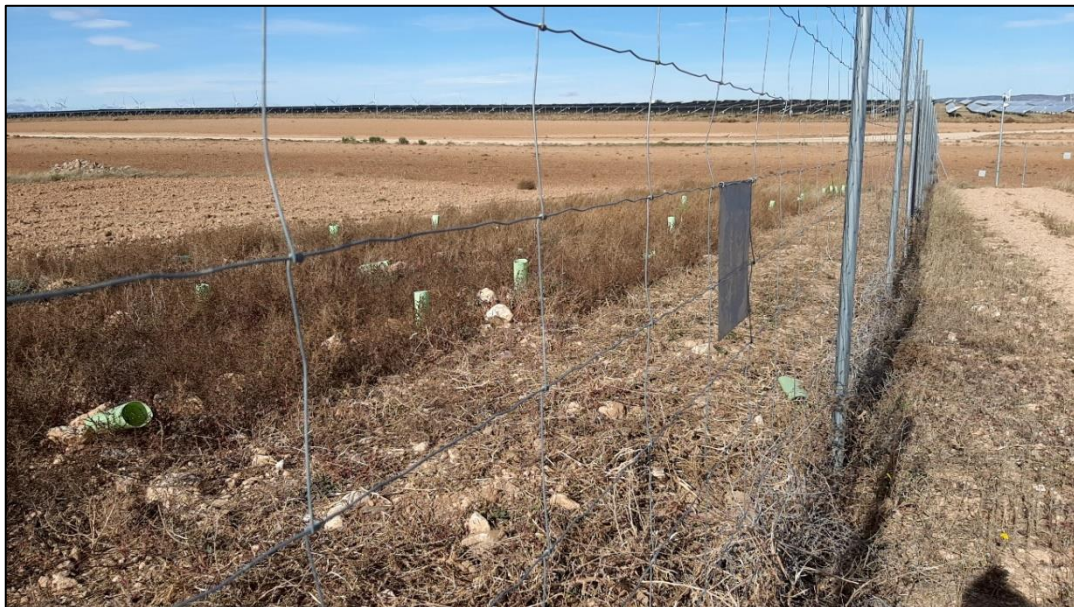
Figura 40: Tramo de vegetación desbrozada junto al vallado en el sector NW de la PSFV
