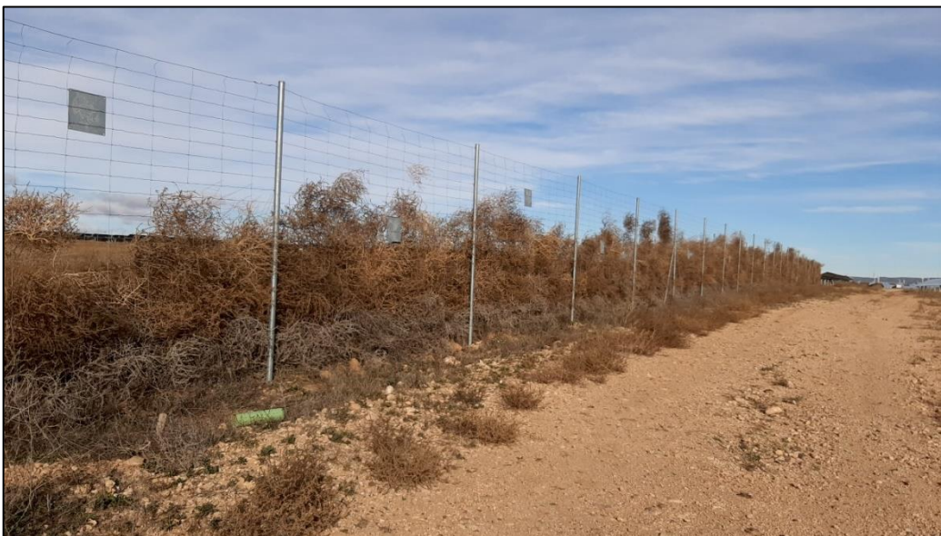
Figura 38: Vegetación rodada acumulada contra el vallado de la PSFV en su cara externa.
