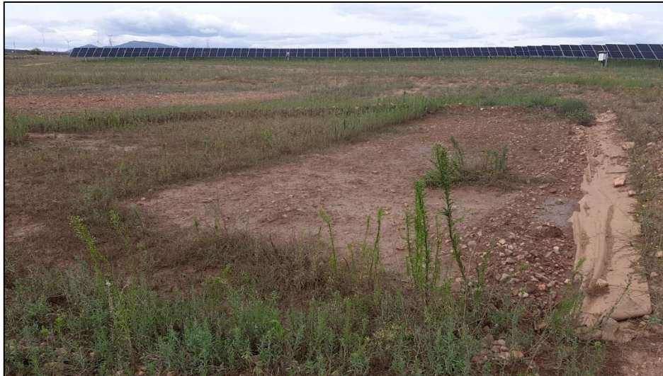
Figura 17: Basete construido en el interior del perímetro de la PSFV Tico Solar I.
