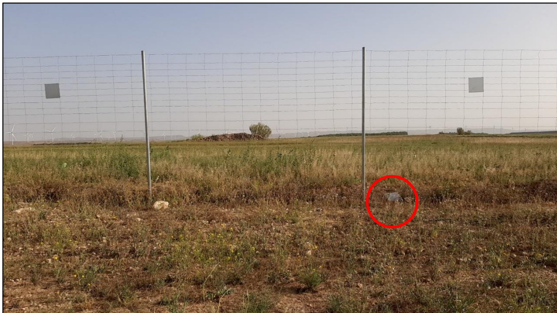
Figura 23: Placa anticolidión descolgada y tendida en el suelo.
