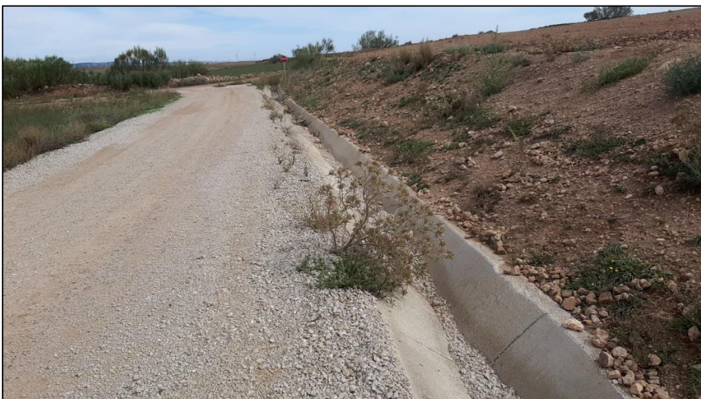
Figura 32: Vial exterior de acceso
