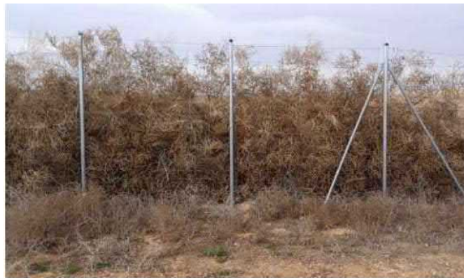
Imagen 4. Acumulaciones de capitanas en la cara exterior del vallado perimetral
