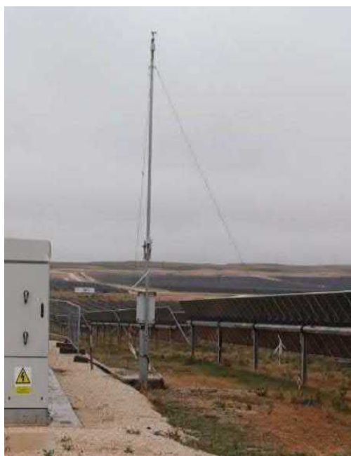
Imagen 6. Tiras de cinta de balizamiento instaladas en los cables de las torres anemométricas con el objetivo de incrementar su visibilidad para la avifauna y quirópteros
