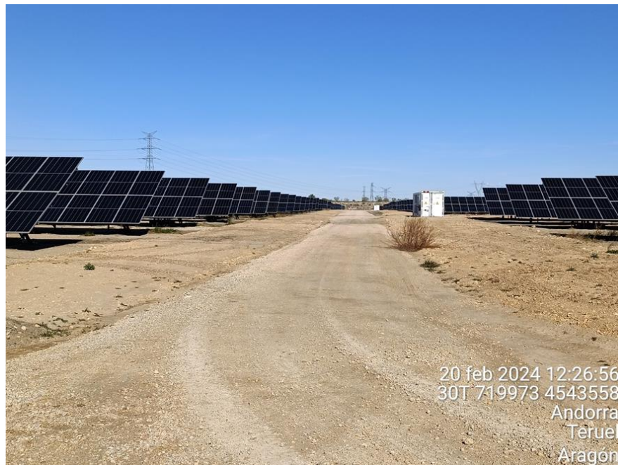
Figura 16: Aspecto del vial principal
