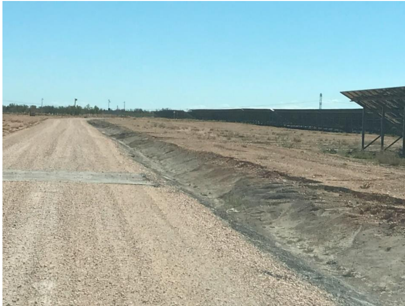
Figura 18: Aspecto de uno de los drenajes perpendiculares a un camino interior de la PSFV SEDEIS V.
