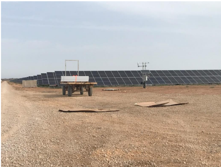
Figura 15: Residuos dispersos en la PSFV SEDEIS V procedentes de la contrata de construcción (NERVIÓN).
