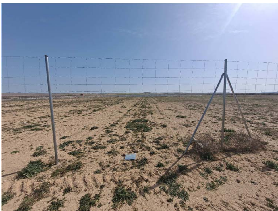
Figura 8.10. Vano sin placa de visibilidad, la cual se observa en el suelo
