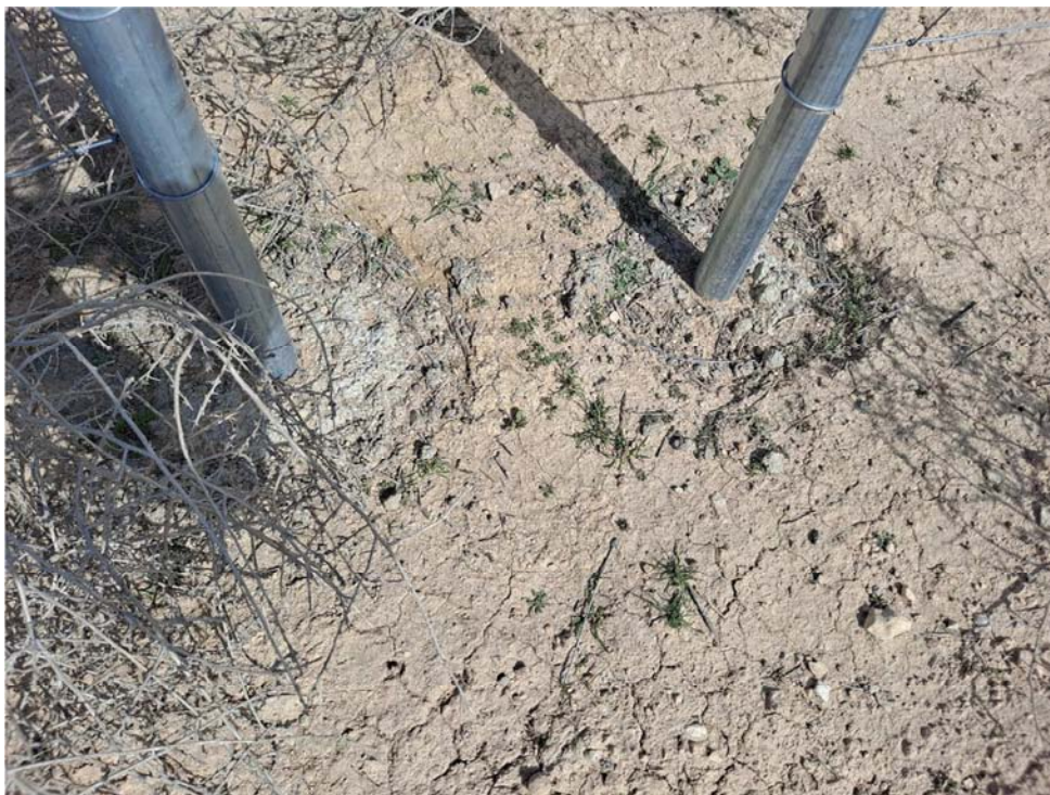
Figura 8.9. Alambres en el suelo junto a los pasos de fauna, observados en los dos recintos de la planta a fecha 14-03-24
