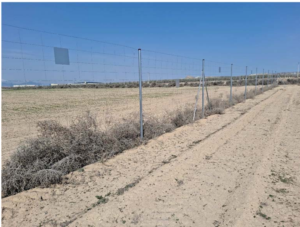
Figura 8.3. Acumulaciones de vegetación que quedan retenidas especialmente en el límite occidental del vallado
