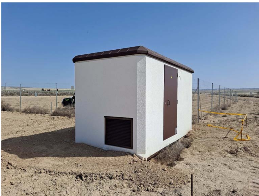
Figura 8.1. Relleno parcial de la excavación realizada para la instalación de la caseta prefabricada donde se instalará un centro de transformación, junto al recinto de “San Pedro B”
