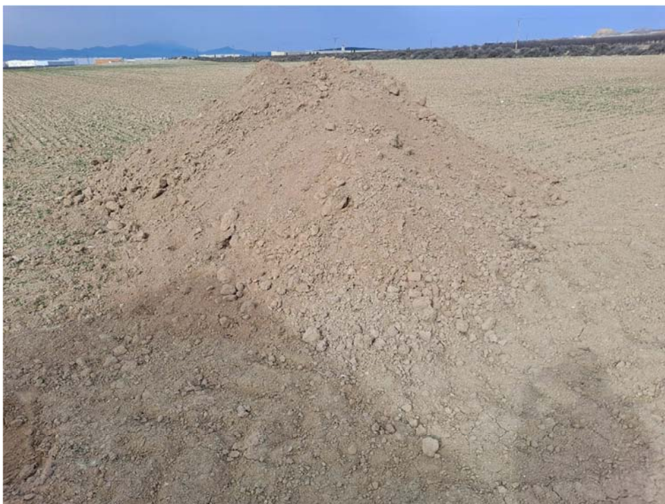
Figura 8.2. Tierra vegetal acopiada junto a la caseta, procedente del hueco excavado para su instalación
