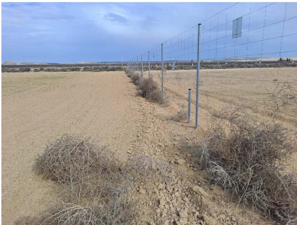
Figura 8.3. Acumulaciones de vegetación que quedan retenidas en algunos puntos del vallado
