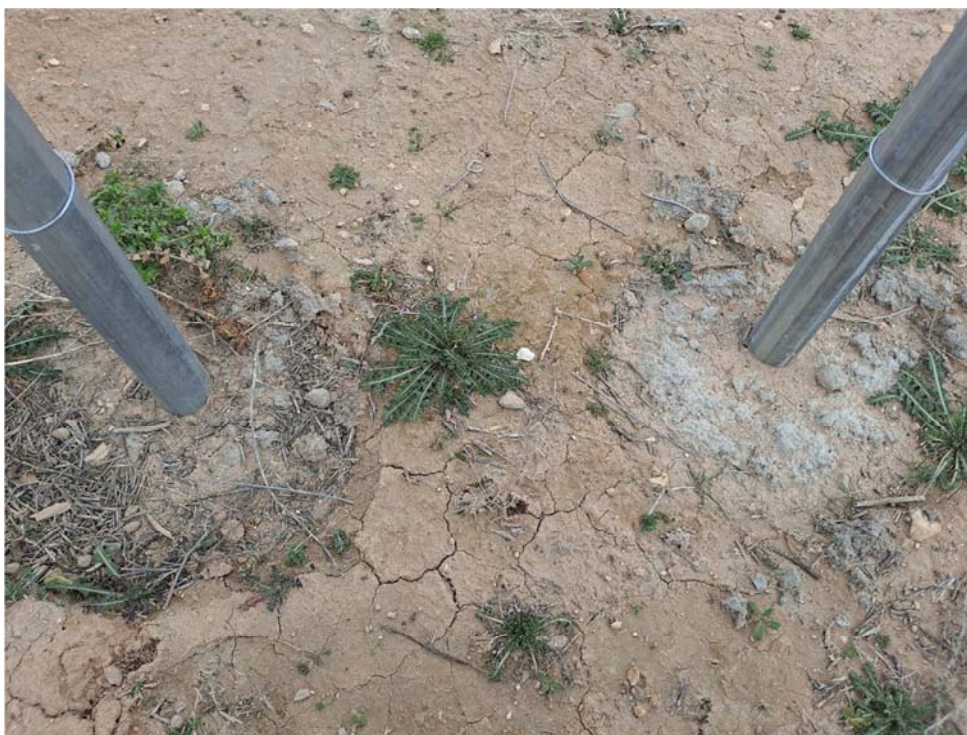
Figura 8.8. Alambres en el suelo junto a los pasos de fauna, observados en los dos recintos de la planta a fecha 15-02-24
