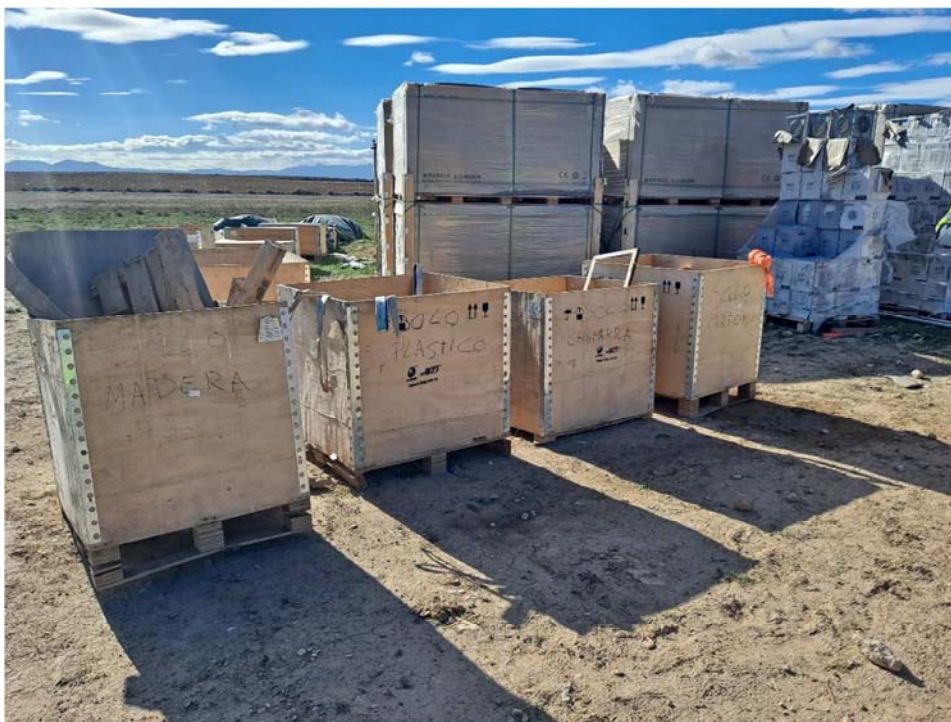
Figura 8.3. Cajones instalados para la recogida de los residuos en el recinto “San Pedro A”, antes de su traslado a los contenedores localizados en “San Pedro B”
