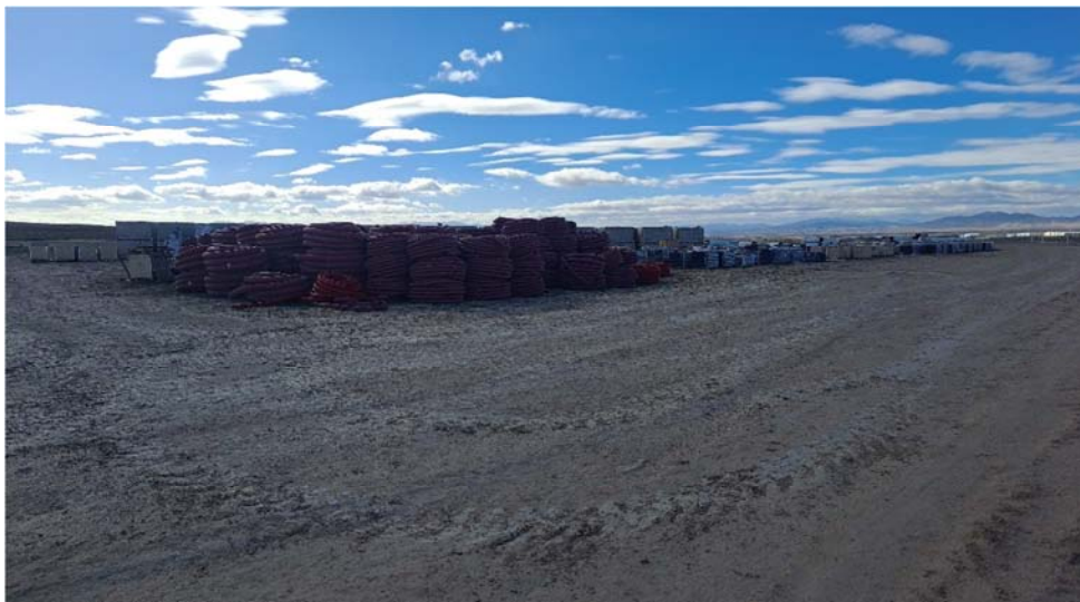
Figura 8.1. Área de acopios de material en el recinto “San Pedro A”
