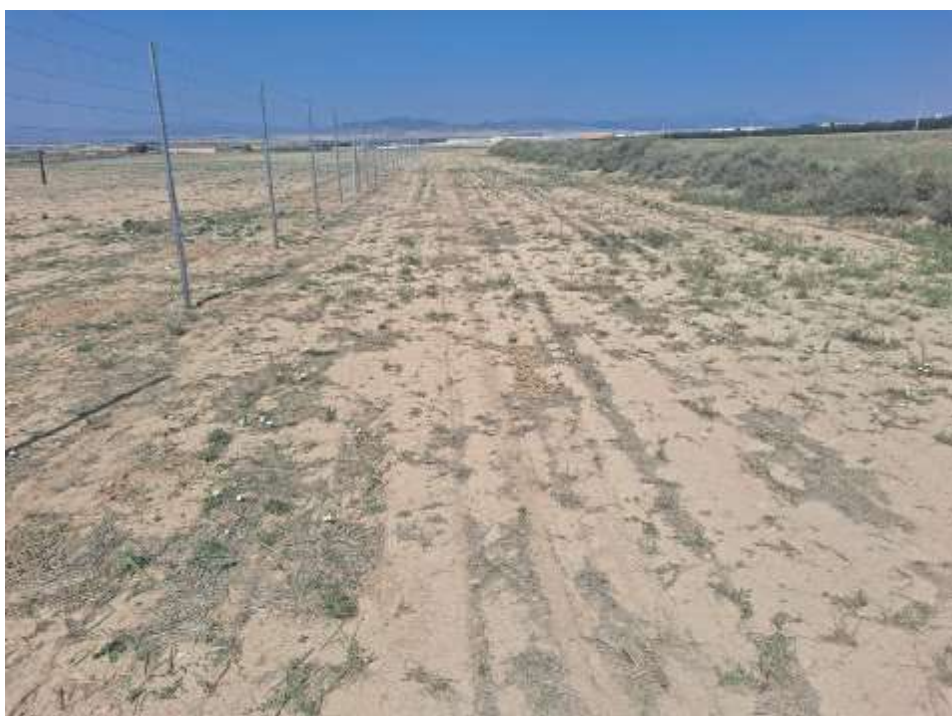
Figura 8.2. Retranqueo de 10 del vallado respecto al límite de la parcela
