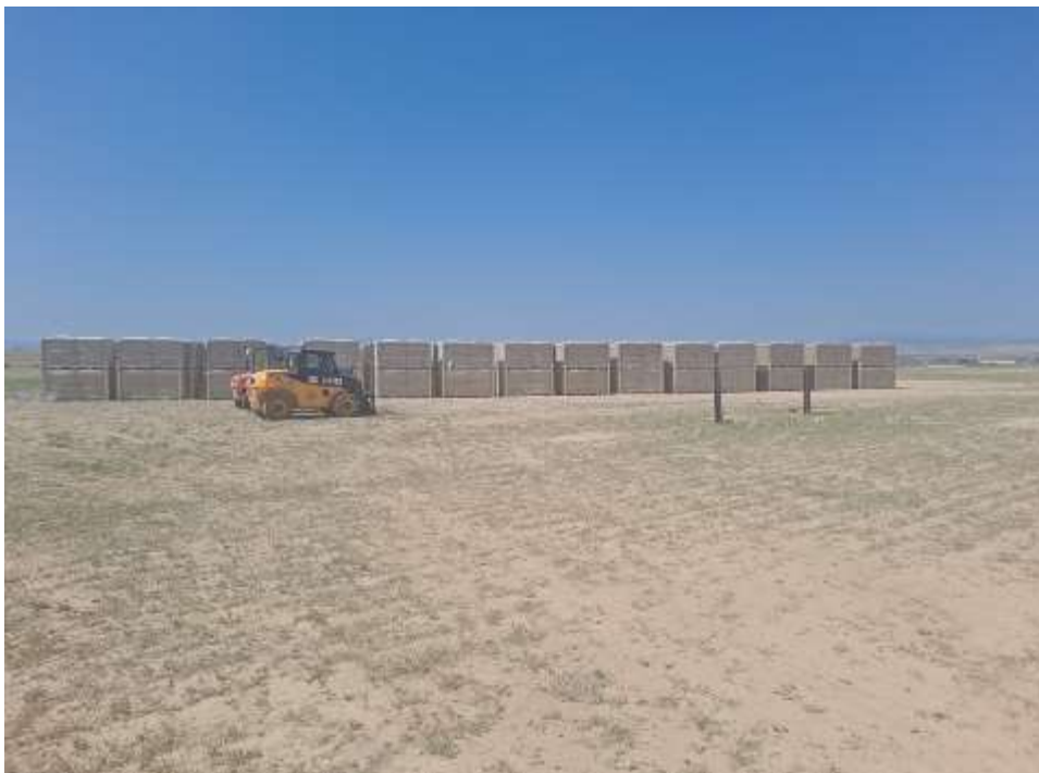
Figura 8.9. Acopios de material y maquinaria aparcada dentro del recinto de la planta (fecha 20-07-2023)
