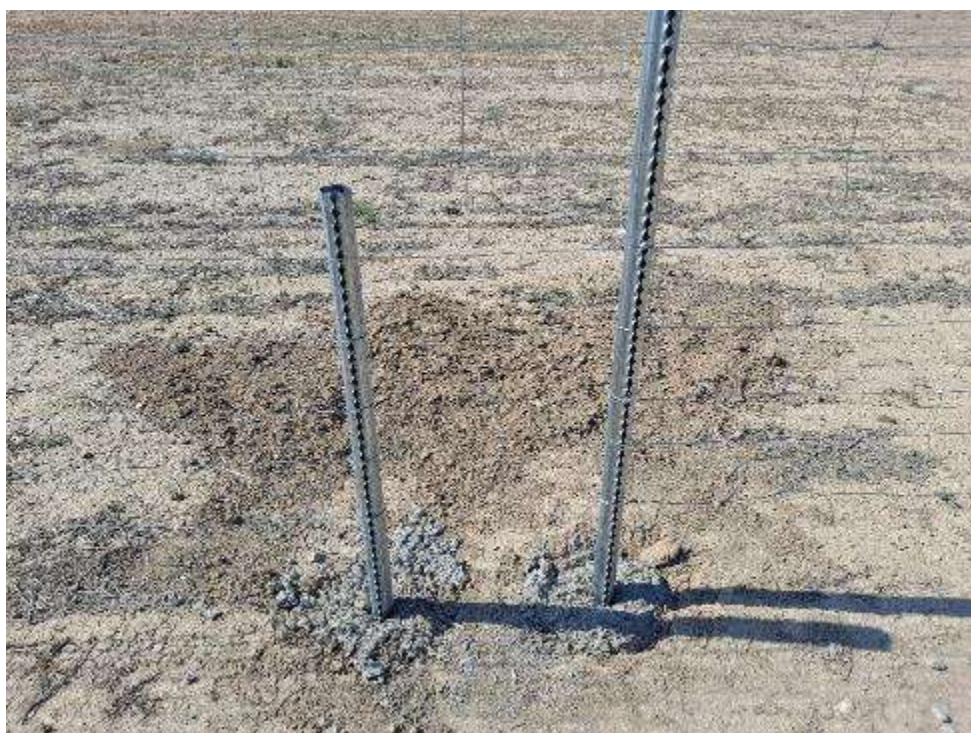
Figura 8.8. Paso para fauna en el vallado ya terminado en recinto San Pedro B (fecha 27-07-2023)
