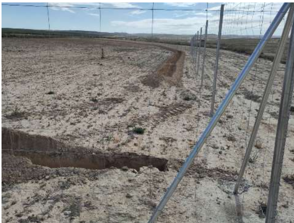
Figura 8.12. Zanjas perimetrales para instalación del cableado del sistema de seguridad
