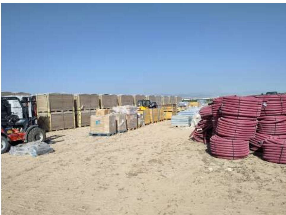
Figura 8.10. Acopios de material y maquinaria aparcada dentro del recinto de la planta (fecha 10-08-2023)
