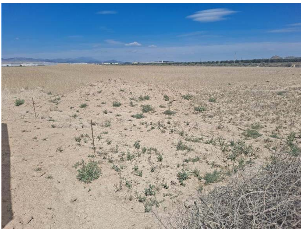
Figura 8.9. Aspecto del acopio de tierra vegetal procedente de la cimentación de la caseta que albergará el centro de transformación
