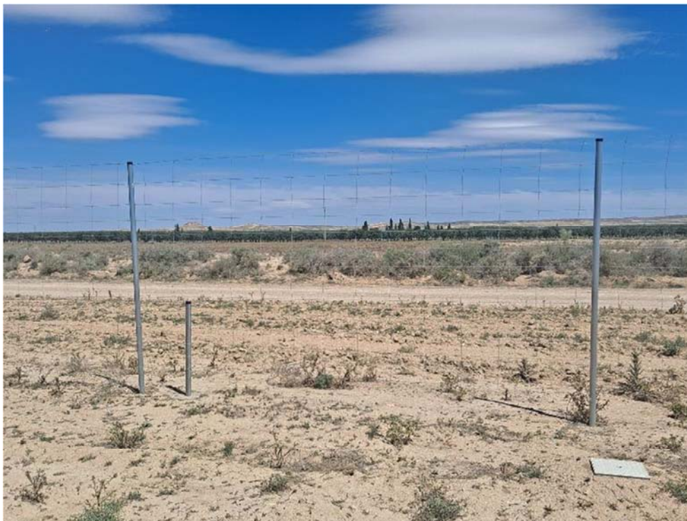
Figura 8.11. Vano del vallado sin placa de visibilidad
