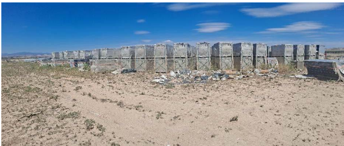
Figura 8.10. Aspecto de la planta "San Pedro A", con los acopios de material
