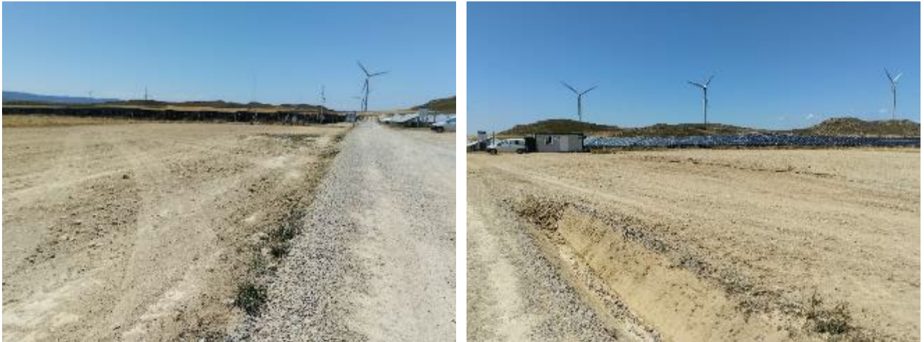
Terrenos afectados por la ejecución de la zanja y mayor parte del a campa, ya restaurados
