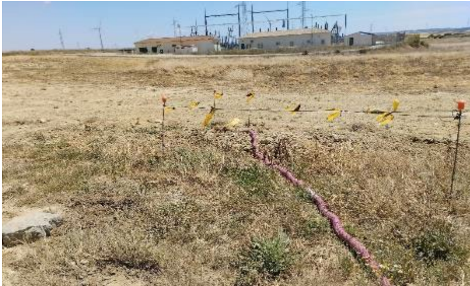
Conexión eléctrica SET-Campa, que aún no ha podido ser retirada
