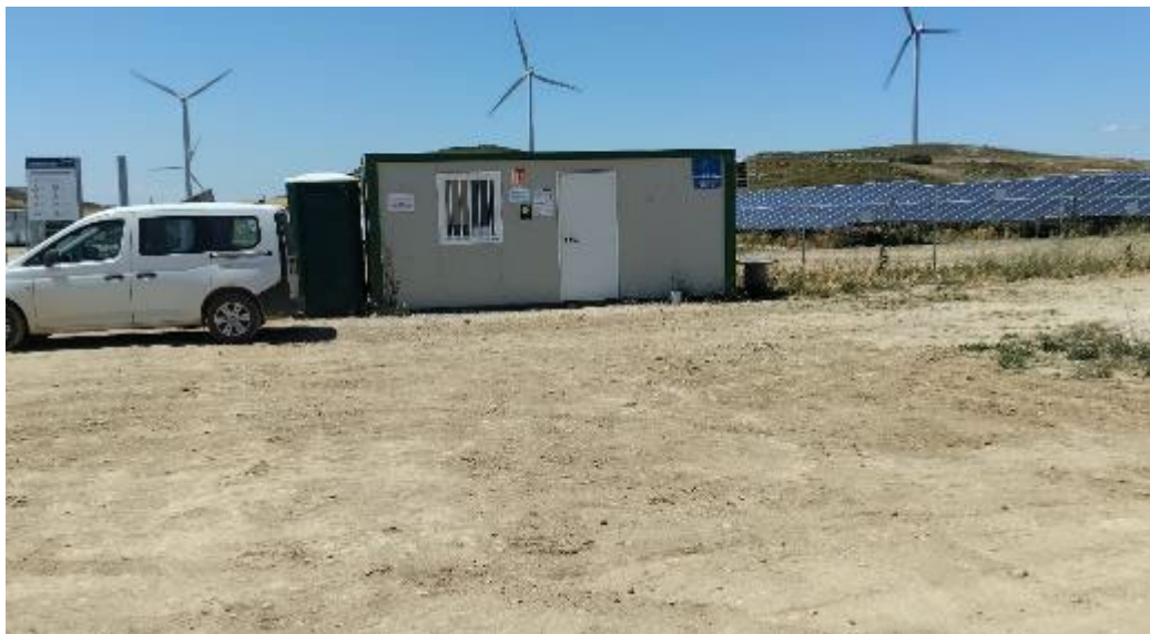
Caseta y baños aún en la campa, y últimas superficies pendientes de descompactado
