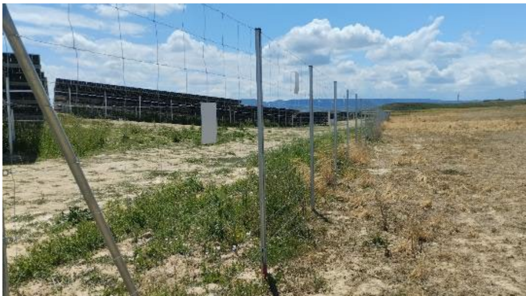
Cerramiento en perfecto estado. No se detectan colisiones de aves ni quirópteros
