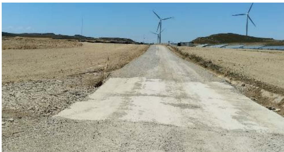
Pequeño badén y cuneta reperfilada, en el vial de acceso a la planta
