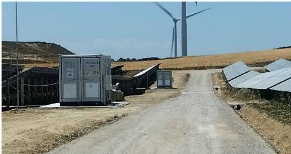
Aceras de los CT, y pasos salvacunetas, terminados
