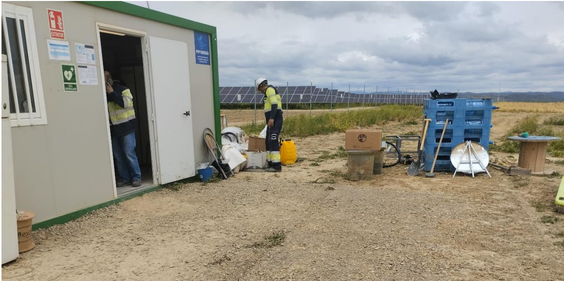
Retirando documentación y equipos de la caseta de oficinas, en la campa de obras, el 25-04-24
