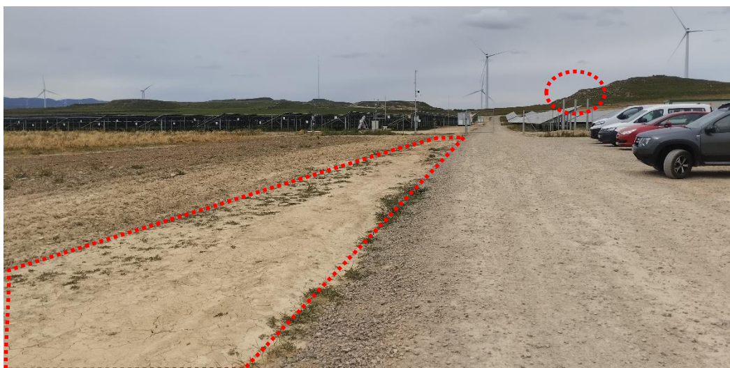
Suelos a descompactar y soportes de la cartelería por instalar
