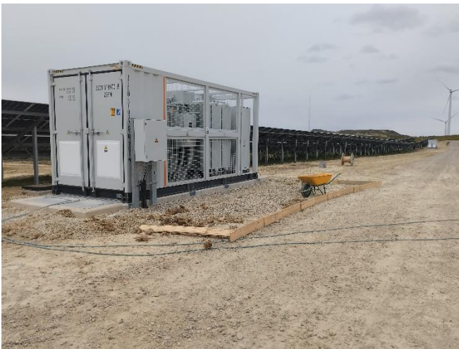
CT con las aceras en ejecución, y vial interior de la planta, pendiente de perfilar cunetas en sus márgenes
