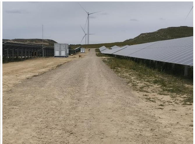
CT con las aceras en ejecución, y vial interior de la planta, pendiente de perfilar cunetas en sus márgenes
