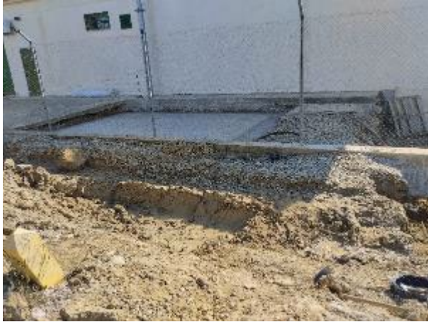
Cimentación del edificio prefabricado que se añadirá a la SET, y contenedor de escombros pendiente de retirarse.
