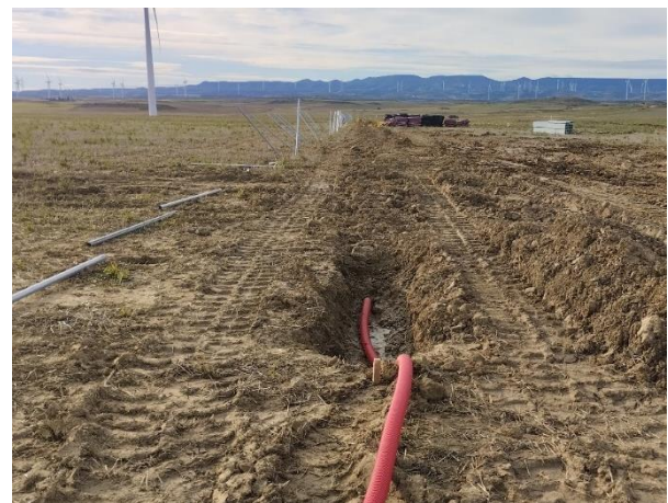
Zanja perimetral en ejecución, que va siendo tapada por tramos
