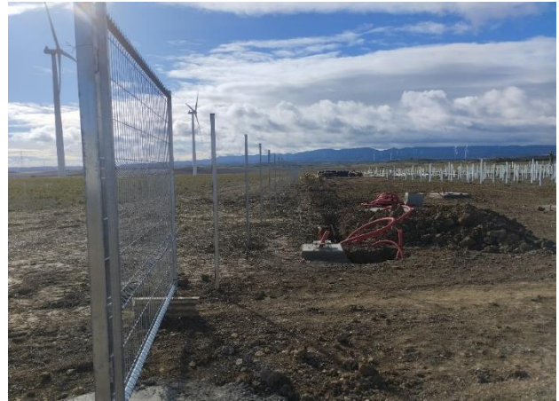
Preparando los hoyos de colocación de los postes de cerramiento, y postes y puerta ya colocados
