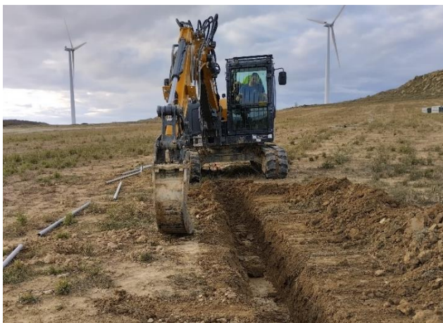
Zanja perimetral en ejecución, que va siendo tapada por tramos
