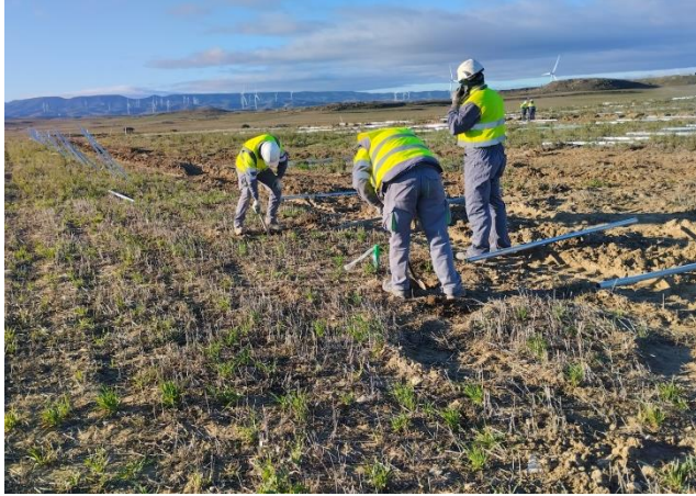
Preparando los hoyos de colocación de los postes de cerramiento, y postes y puerta ya colocados
