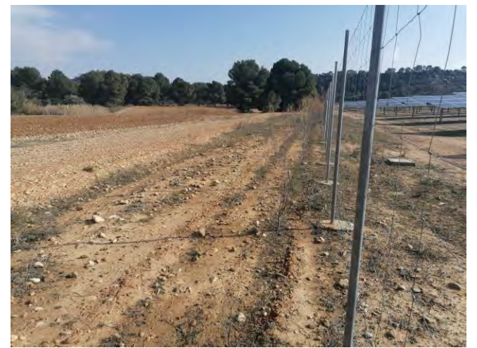
Fotografía 28.- Estado de la pantalla perimetral, lado Norte (semi-recinto Este), pantalla visual en el tramo próximo al Camino Natural del Ebro (GR-99). Enero.
