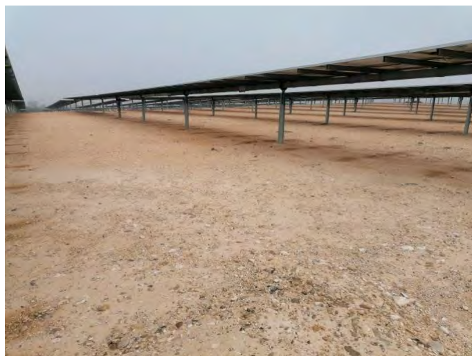
Fotografía 06.- Estado del suelo en bloques de construcción reciente. Cubierta vegetal rala y escasa. Diciembre.
