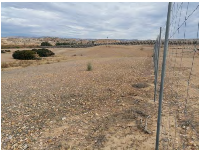
Fotografía 23.- Estado de la pantalla perimetral, lado Norte (semi-recinto Este), pantalla visual en el tramo próximo al Camino Natural del Ebro (GR-99). Noviembre.
