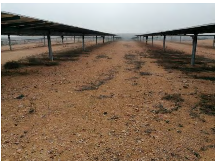
Fotografía 05.- Estado del suelo en bloques de construcción reciente. Cubierta vegetal rala y escasa. Diciembre.
