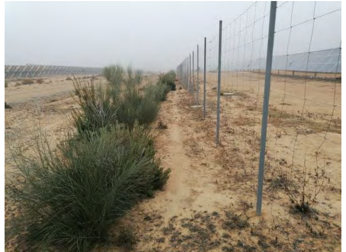
Fotografía 26.- Estado de la pantalla perimetral: Vallado de la pista central, semi-perímetro Oeste. Diciembre.
