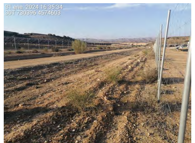
Fotografía 30.- Estado de la pantalla perimetral en torno a la pista central (semi-recinto Este). Enero.
