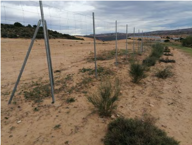
Fotografía 19.- Estado de la pantalla visual. Vallado de la pista central, semi-perímetro Oeste. Octubre.
