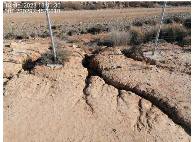
Fotografía 16. - Procesos erosivos. Cárcavas y arrastres bajo el vallado debidas a lluvias torrenciales. Diciembre.
