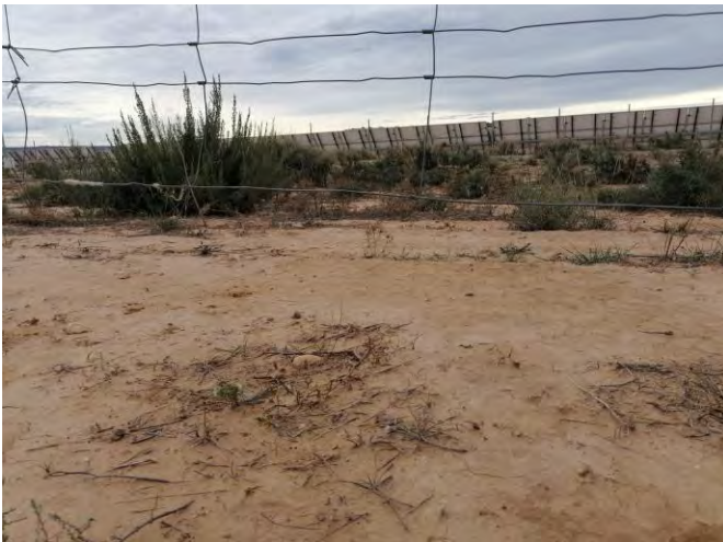
Fotografía 39.- Permeabilidad del vallado: espacio libre desde el suelo de más de 15 cm. Cuadros inferiores mayores de 300 cm 2 . Octubre.
