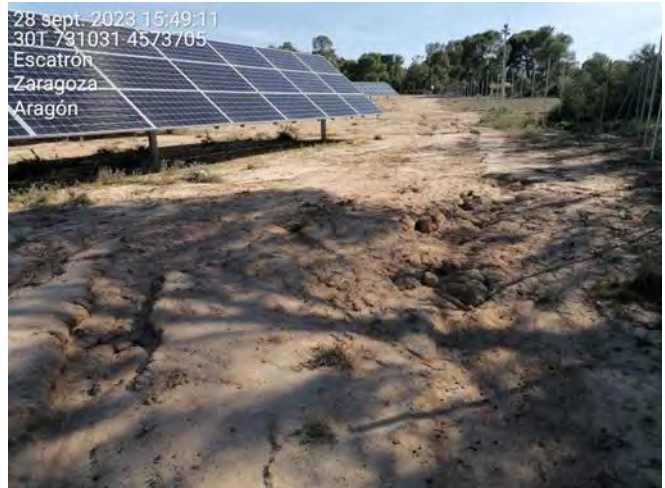
Fotografía 50.- Procesos erosivos. Inicio de cárcavas y arrastres en caminos.
