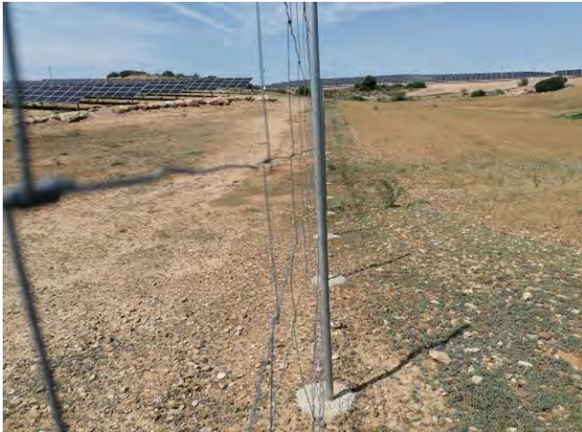
Fotografía 19.- Estado de la pantalla visual en el tramo próximo al Camino Natural del Ebro (GR-99). Plantación perimetral de tamariz ensemi-recinto Este (lado Norte).
