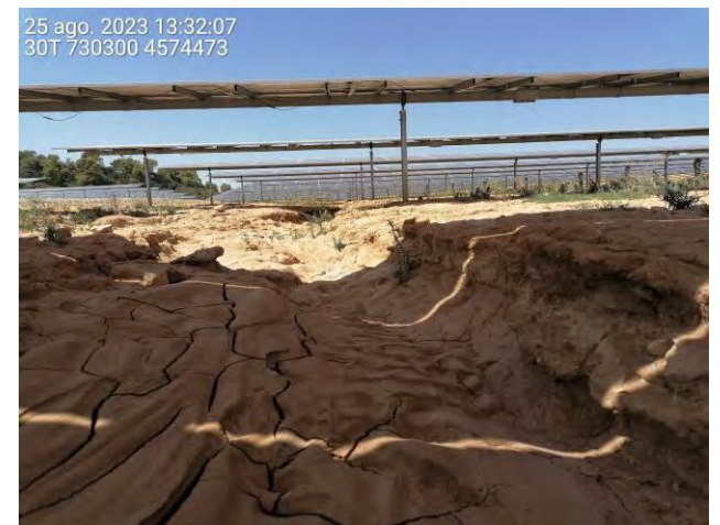
Fotografía 35.- Procesos erosivos. Cárcavas y arrastres bajo seguidores.
