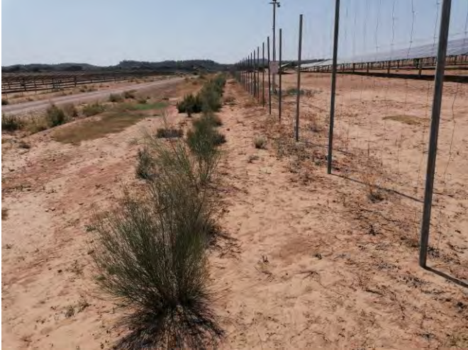
Fotografía 13.- Estado de la pantalla perimetral: Vallado de la pista central, semi-perímetro Oeste.
