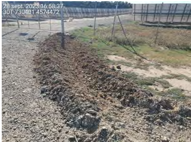
Fotografía 52.- Procesos erosivos. Reparación de cuneta colmatada.
