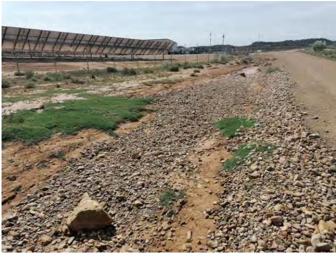
Fotografía 31.- Procesos erosivos. Estado de la cuneta de la pista central tras las últimas tormentas.
