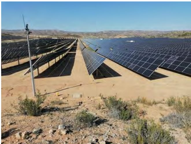
Fotografía 17.- Estado de la vegetación natural dentro del perímetro vallado.
