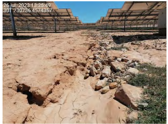
Fotografía 34.- Procesos erosivos. Inicio de cárcavas por lluvias torrenciales.
