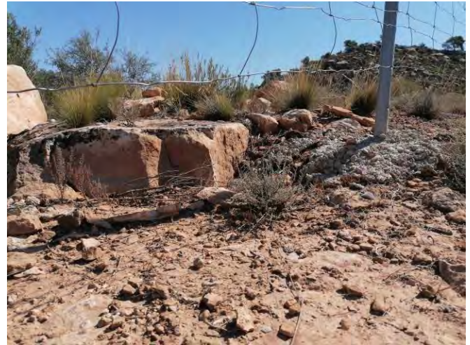
Fotografía 10.- Permeabilidad del vallado: Espacio inferior bajo el vallado mayor de 15 centímetros.
