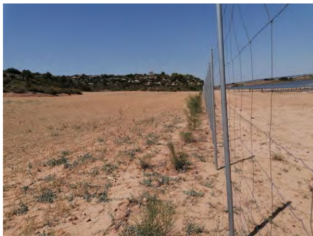
Fotografía 20.- Estado de la pantalla perimetral: Vallado del lado Sur, semi-perímetro Oeste.
