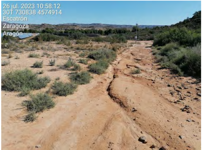
Fotografía 26.- Procesos erosivos. Inicio de cárcavas por lluvias torrenciales.
