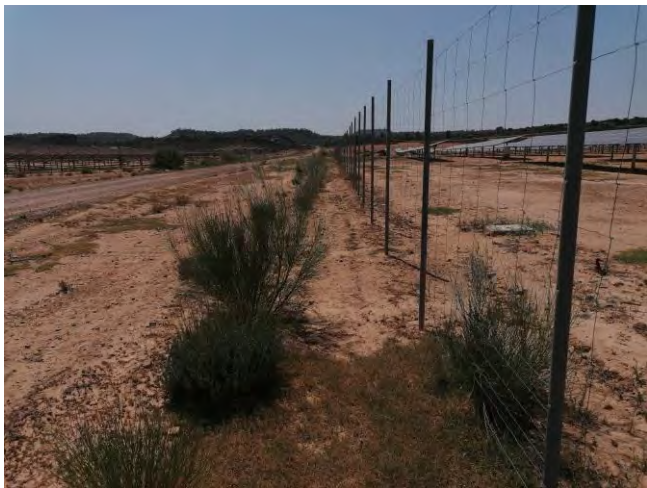
Fotografía 15.- Estado de la pantalla perimetral: Vallado de la pista central, semi-perímetro Oeste.
