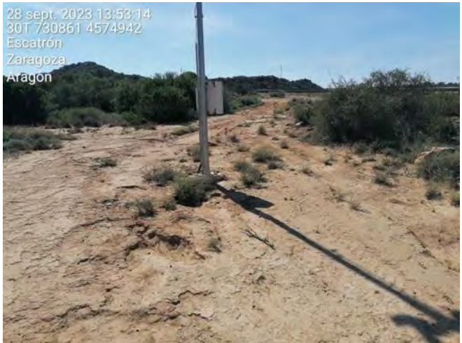
Fotografía 46.- Procesos erosivos. Inicio de cárcavas y arrastres en caminos.
