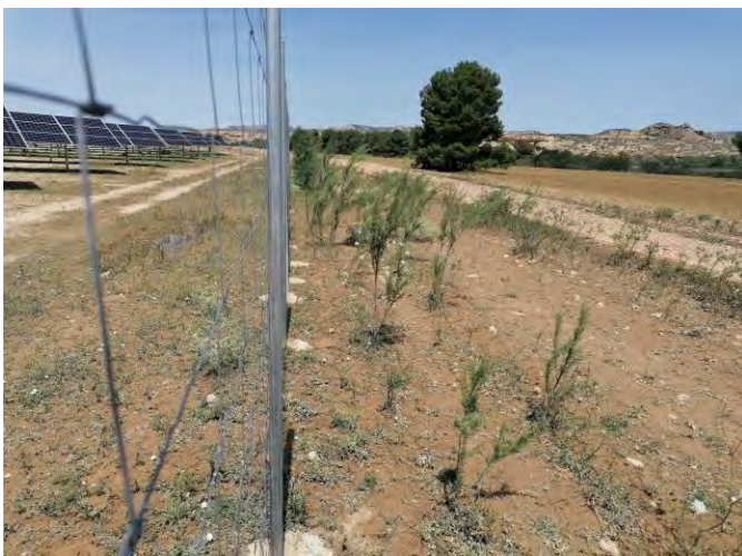
Fotografía 23.- Estado de la pantalla visual en el tramo próximo al Camino Natural del Ebro (GR-99). Plantación perimetral de tamariz en semi-recinto Este (lado Norte).
