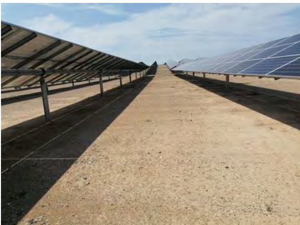
Fotografía 05.- Estado del suelo en bloques de construcción reciente. Cubierta vegetal rala y escasa.
