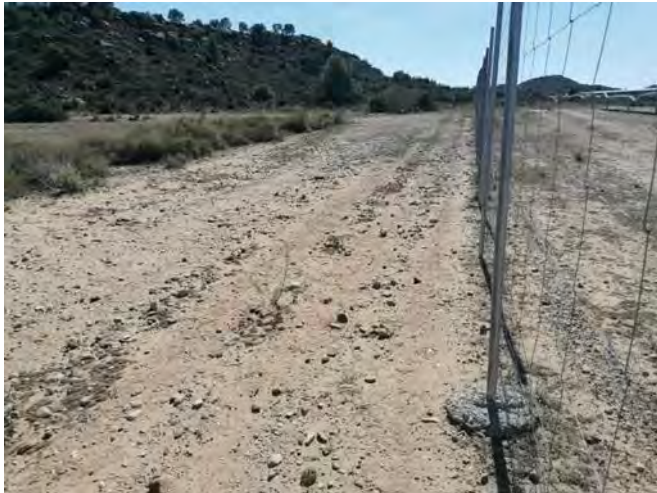
Fotografía 31. - Estado de la pantalla perimetral, lado Este (semi- recinto Este), pantalla visual en el tramo próximo al Camino Natural del Ebro (GR-99).
