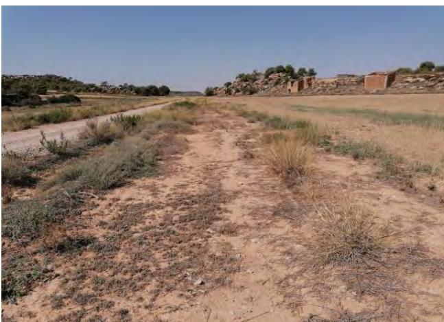
Fotografía 05. - Estado del suelo en línea de evacuación soterrada. Cubierta vegetal incipiente.
