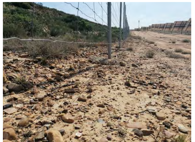
Fotografía 12. - Permeabilidad del vallado: Espacio inferior bajo el vallado mayor de 15 centímetros.
