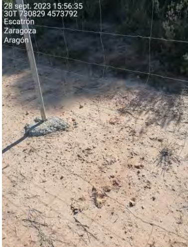
Fotografía 13.- Permeabilidad del vallado: huellas de jabalí cruzando el vallado.
