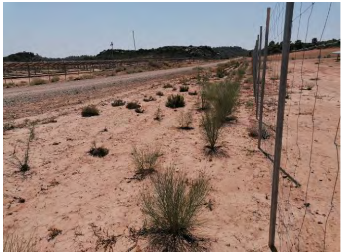
Fotografía 18.- Estado de la pantalla perimetral: Vallado de la pista central, semi-perímetro Oeste.
