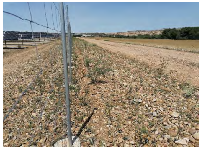
Fotografía 22.- Estado de la pantalla visual en el tramo próximo al Camino Natural del Ebro (GR-99). Plantación perimetral de tamariz en semi-recinto Este (lado Norte).
