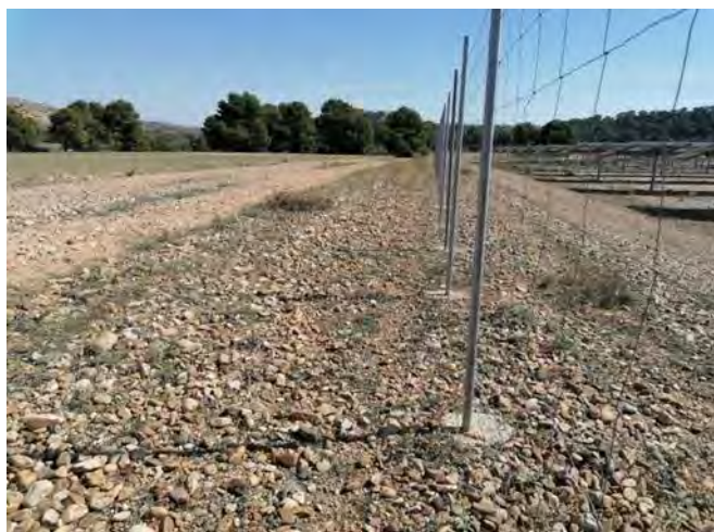
Fotografía 29.- Estado de la pantalla perimetral, lado Norte (semi-recinto Este), pantalla visual en el tramo próximo al Camino Natural del Ebro (GR-99).
