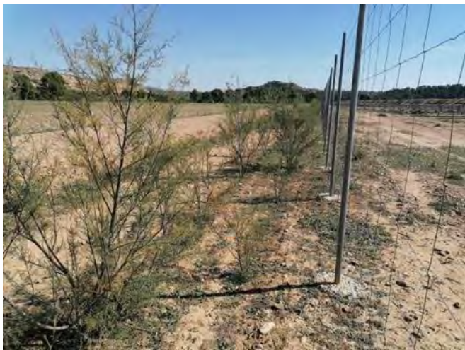
Fotografía 27.- Estado de la pantalla perimetral, lado Norte (semi-recinto Este), pantalla visual en el tramo próximo al Camino Natural del Ebro (GR-99).
