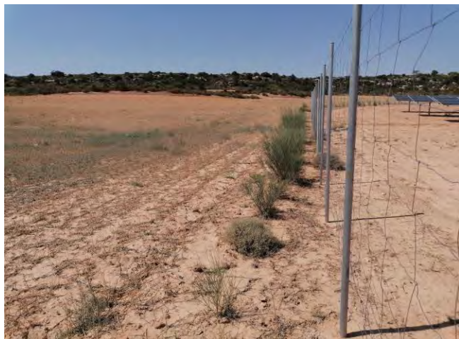
Fotografía 19.- Estado de la pantalla perimetral: Vallado del lado Sur, semi-perímetro Oeste.
