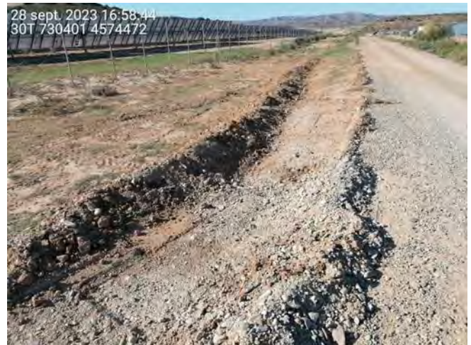
Fotografía 53.- Procesos erosivos. Reparación de cuneta colmatada.
