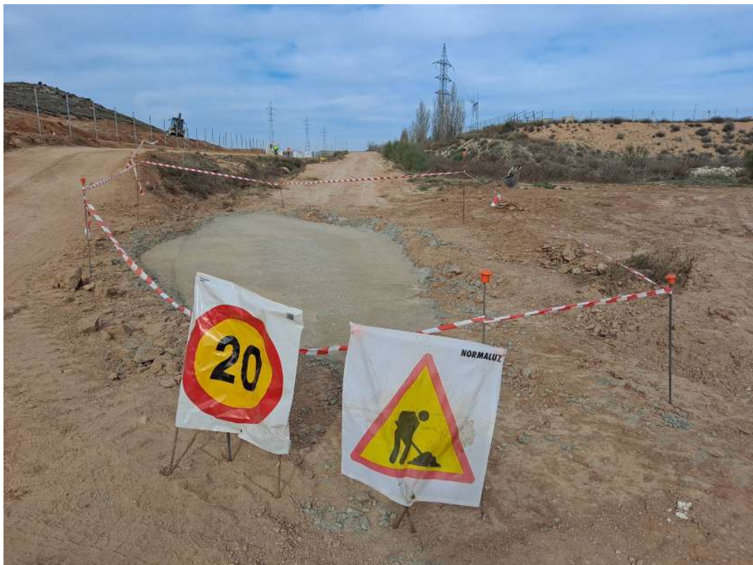
Figura 3. Señalización límite de velocidad
