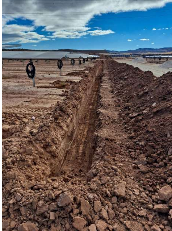
Figura 8. Tierra del zanjeo reutilizada para cerrar canalizaciones subterráneas
