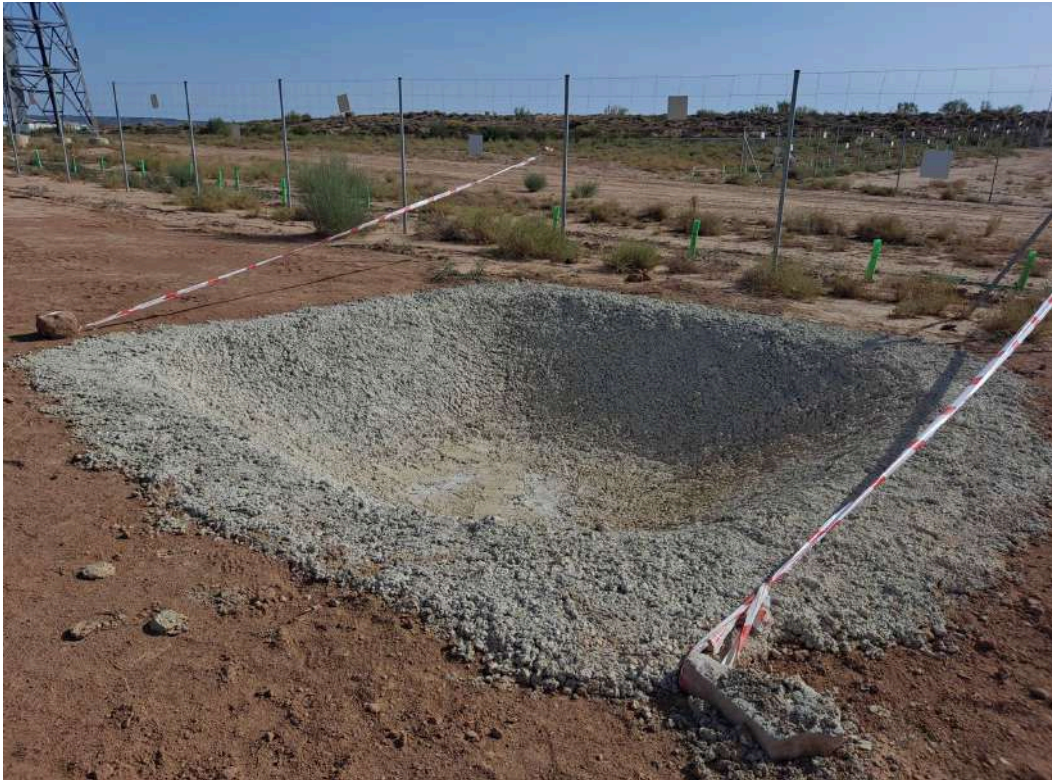
Figura 24. Balsa bebedero instalada
