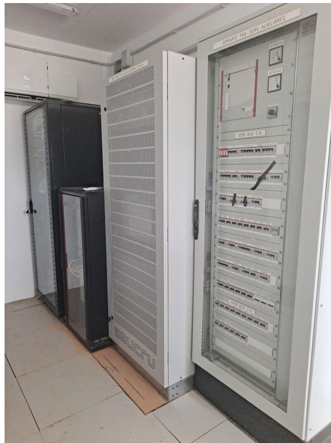
Fotografía 2. Cuadro eléctrico de la subestación PITARCO
