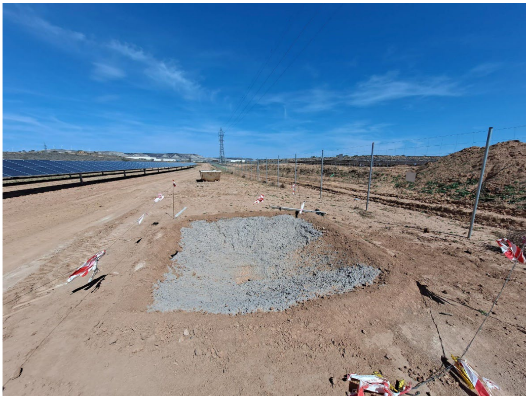
Fotografía 3. Balsa bebedero y refugio de anfibios terminada
