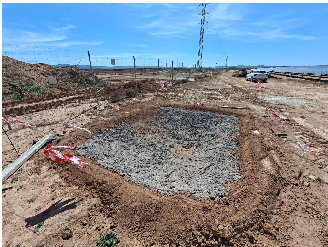
Fotografía 4. Reperfilado lateral de tierra
