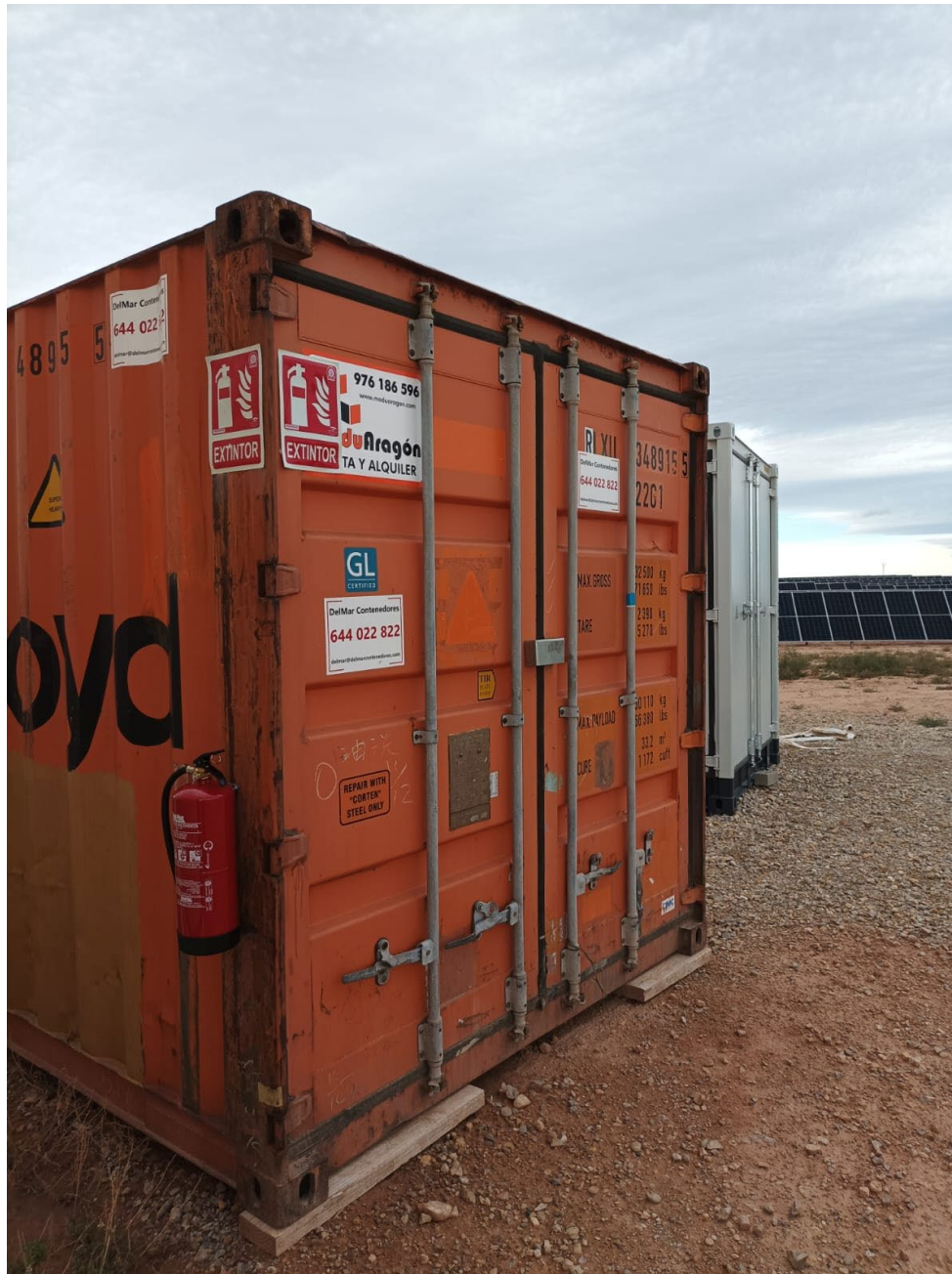
Fotografía 3. Extintor instalado en el contenedor de almacenamiento de residuos peligrosos
