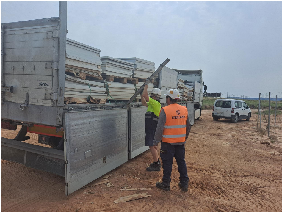
Fotografía 10. Carga y recogida de placas deterioradas por gestor autorizado
