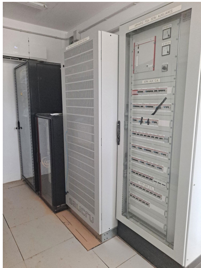
Fotografía 2. Cuadro eléctrico de la subestación PITARCO
