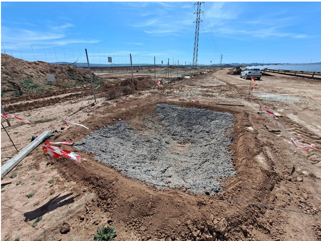
Fotografía 4. Reperfilado lateral de tierra
