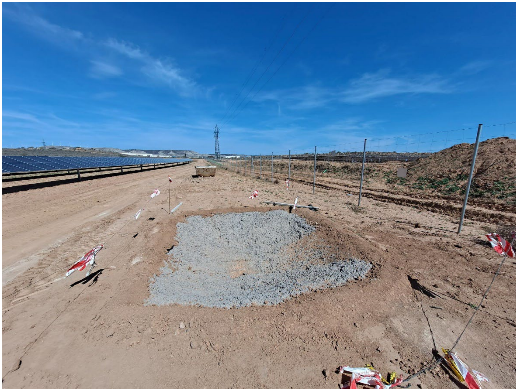
Fotografía 3. Balsa bebedero y refugio de anfibios terminada
