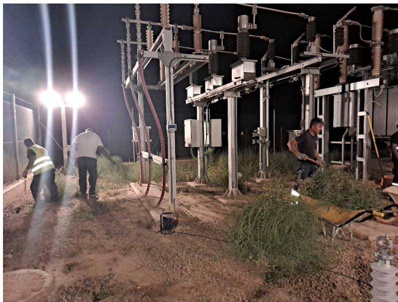
Fotografía 2. Trabajos de desbroce en la subestación
