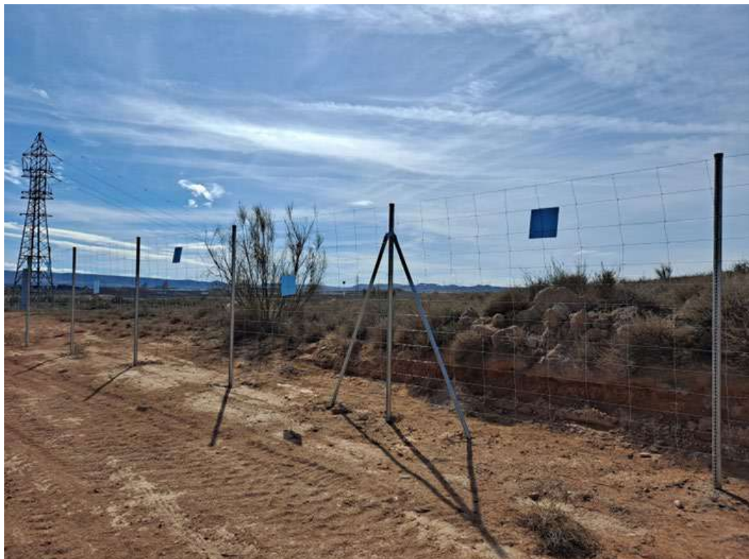
Figura 2. Vallado perimetral con placas anticolidión
