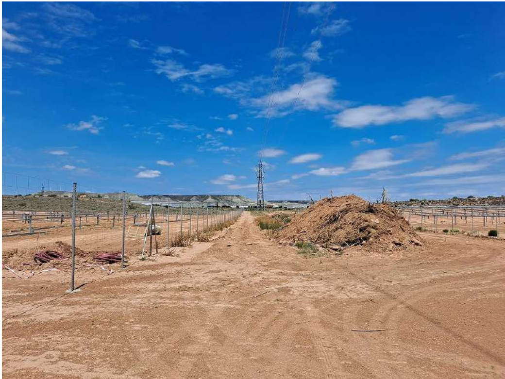
Figura 7. Tierra reutilizada in situ en el talud de entrada
