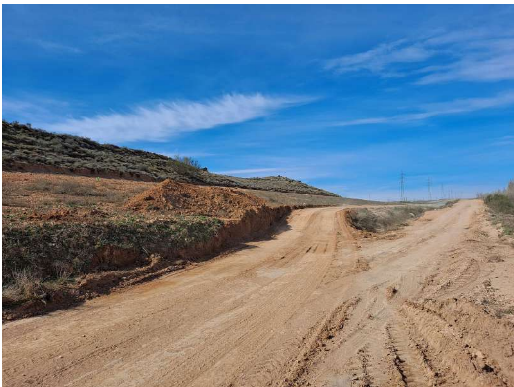
Figura 7. Tierra reutilizada in situ en el talud de entrada
