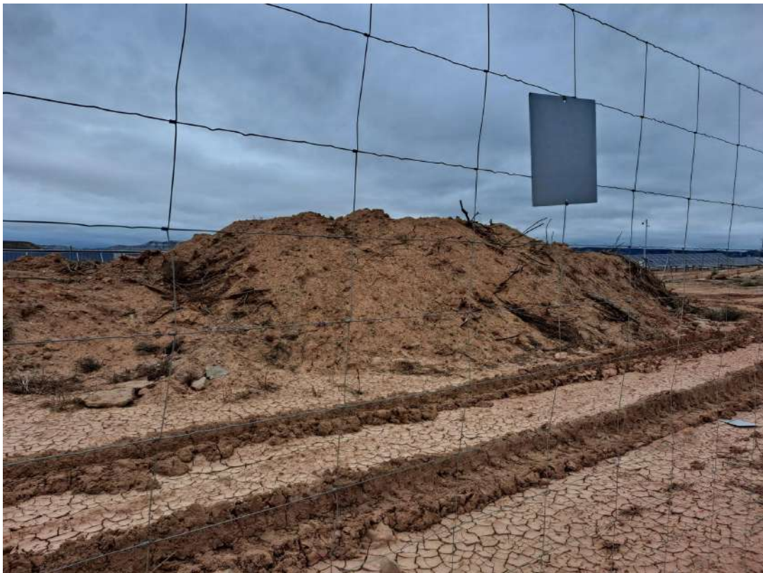
Figura 5. Caballones de tierra acopiados
