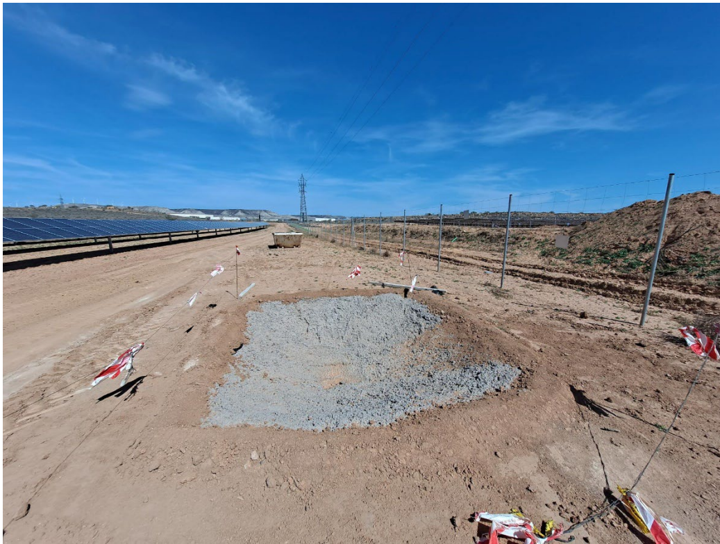
Fotografía 3. Balsa bebedero y refugio de anfibios terminada
