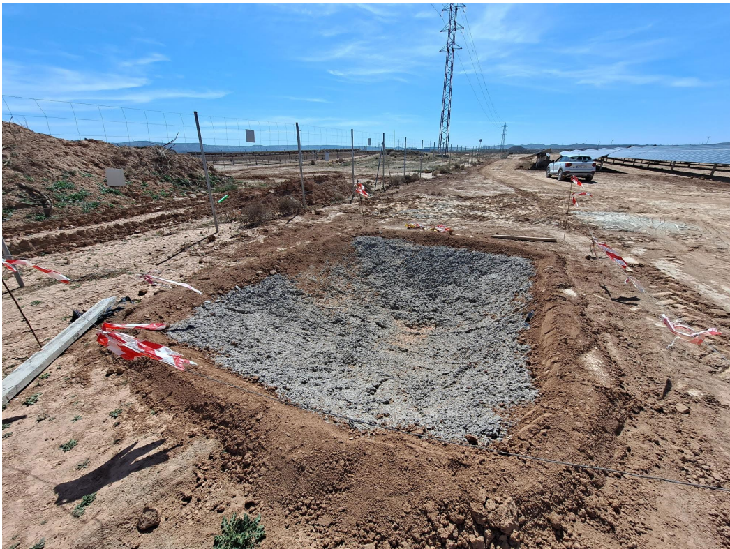
Fotografía 4. Reperfilado lateral de tierra
