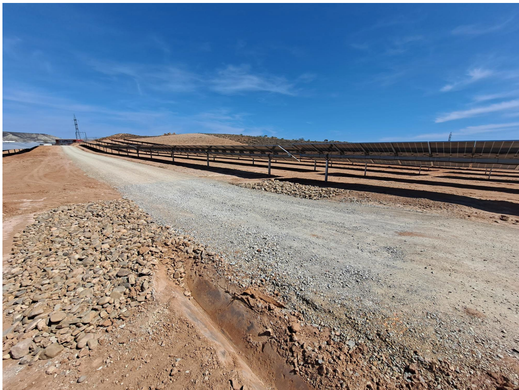
Fotografía 2. Cunetas y refuerzo con gaviones
