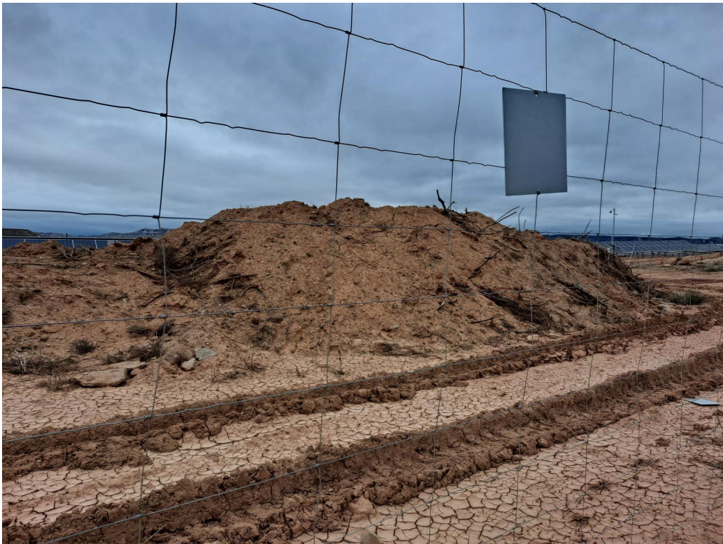
Fotografía 5. Reutilización de la tierra acopiada in situ
