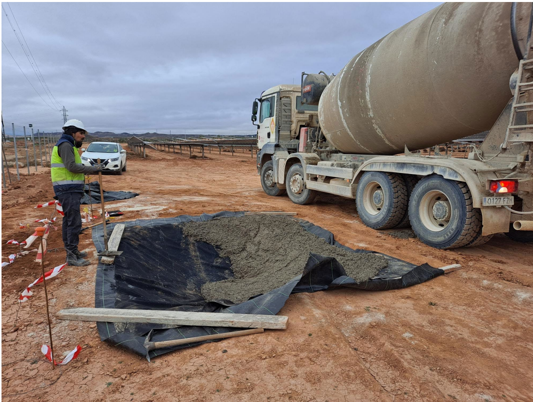
Fotografía 3. Construcción balsa bebedero de anfibios
