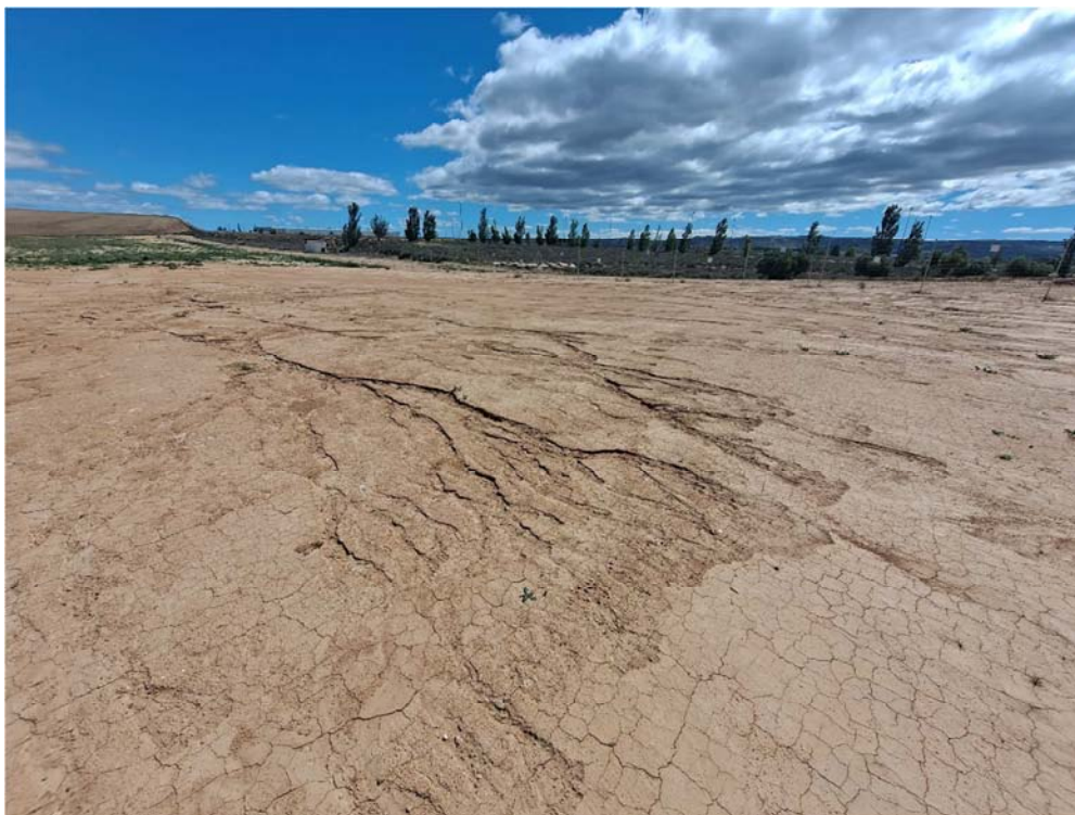
Figura 8.9. Nuevos regueros erosivos identificados en el cuadrante suroccidental del recinto
