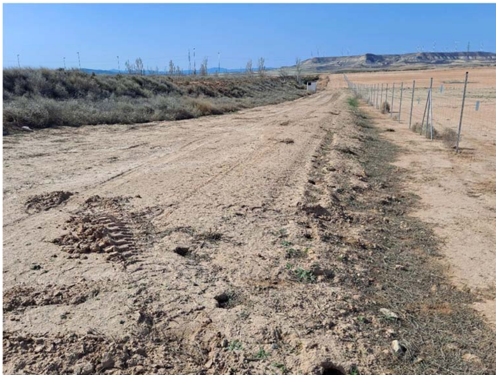
Figura 8.6. Aspecto del único acopio de tierra vegetal que queda, en el límite sureste, compactado y con marcas de rodadas
