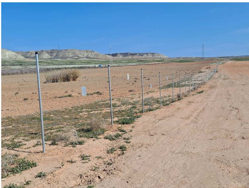
Figura 8.1. Aspecto del vallado ya repuesto. Vista del vallado en el límite norte.
