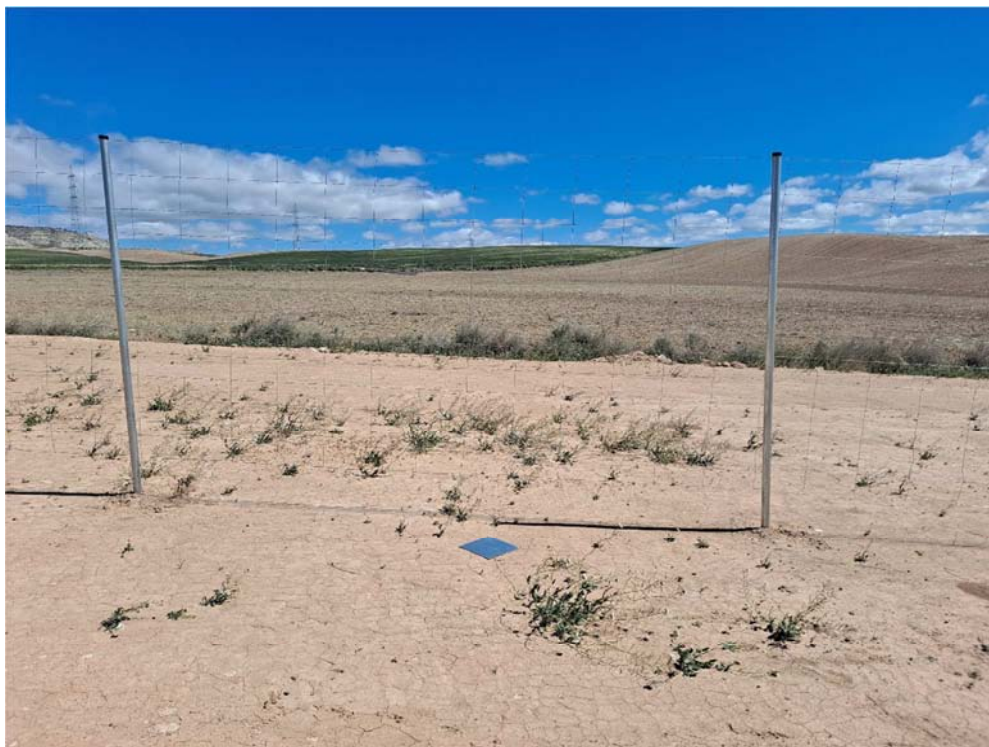
Figura 8.10. Uno de los dos vanos sin placa de visibilidad. Esta se observa en el suelo.
