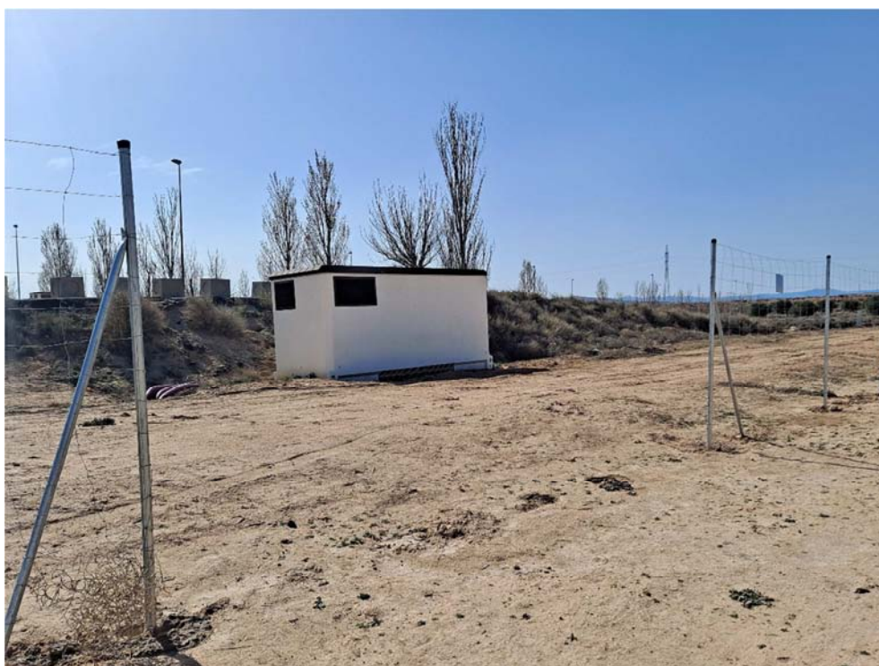
Figura 8.7. Nuevo acceso realizado en el extremo sureste del vallado, abierto junto al acopio de tierra vegetal. El acceso a la planta por este punto obliga a circular por encima del acopio de tierra vegetal, degradándolo y compactándolo.
