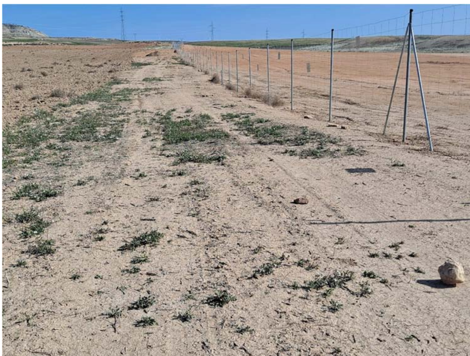
Figura 8.4. Aspecto del extremo noroccidental de la parcela tras el extendido de la tierra vegetal acopiada
