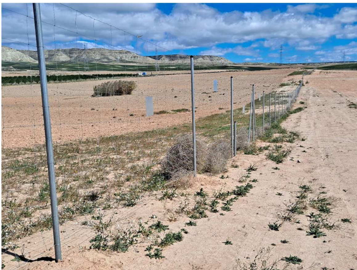
Figura 4.1. Vallado completamente repuesto en todo el perímetro de la planta
