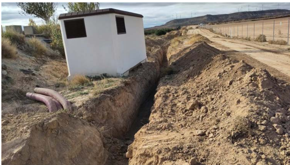
Figura 8.5. Zanja abierta junto al límite sur de la parcela, observada con fecha 15-11-2023. Los acopios de tierras se situaron parcialmente sobre los acopios de tierra vegetal.
