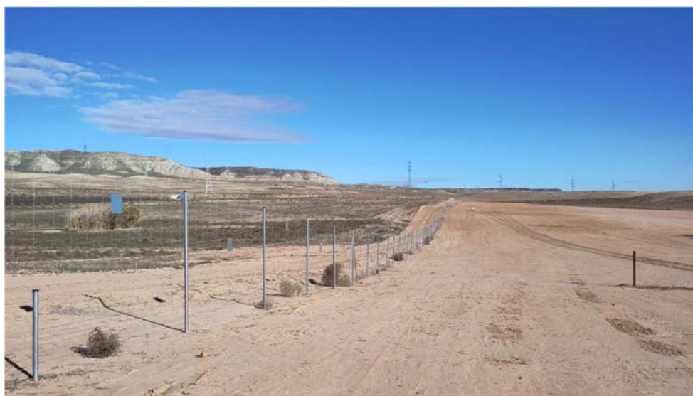
Figura 8.2. Tramo del vallado a fecha 13-12-2023, ya arreglado
