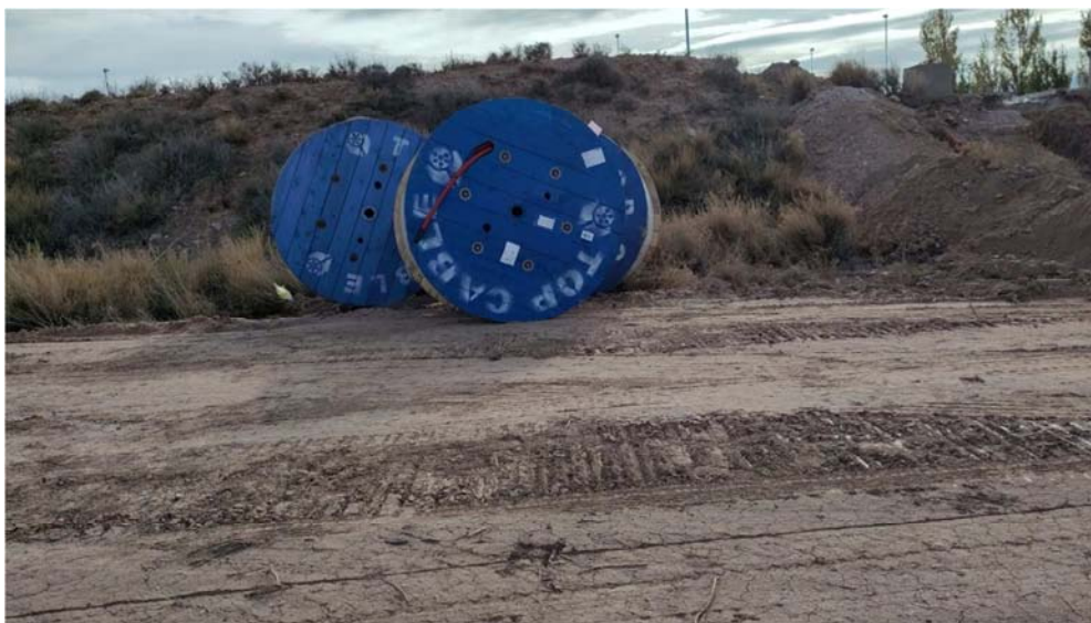
Figura 8.7. Bobinas de cable de gran tamaño situados parcialmente sobre la tierra vegetal acopiada
