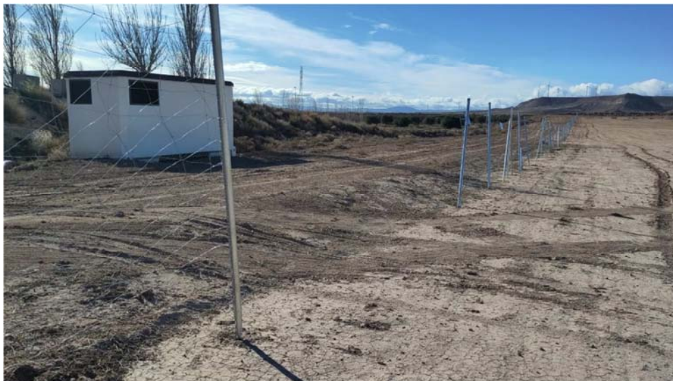
Figura 8.9. Marcas de circulación de vehículos en la zona donde se ha abierto el vallado, que afectan al acopio de tierra vegetal
