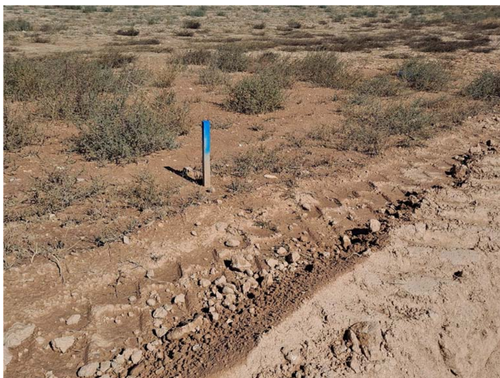
Figura 8.4. Estacas que limitan la zona de proyecto
