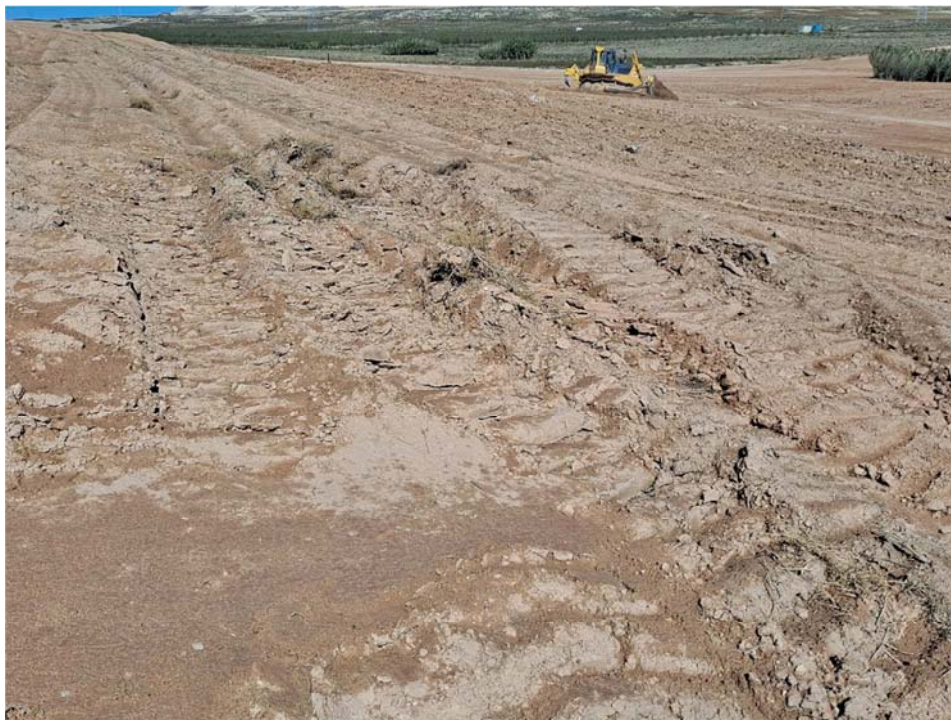
Figura 8.7. Acopios de tierra vegetal situados en el límite suroeste de la zona de proyecto. Se observan marcas de rodadas y tierra vegetal compactada (20-09-23)
