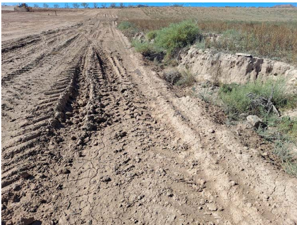
Figura 8.5. Acopios de tierra vegetal situados en el límite noroeste de la zona de proyecto. Intersectan parcialmente una zona de circulación preferente de agua que atraviesa la parcela, por lo que se observa una mayor cantidad de humedad y rodadas bastante marcadas en sobre los acopios (20-09-23)
