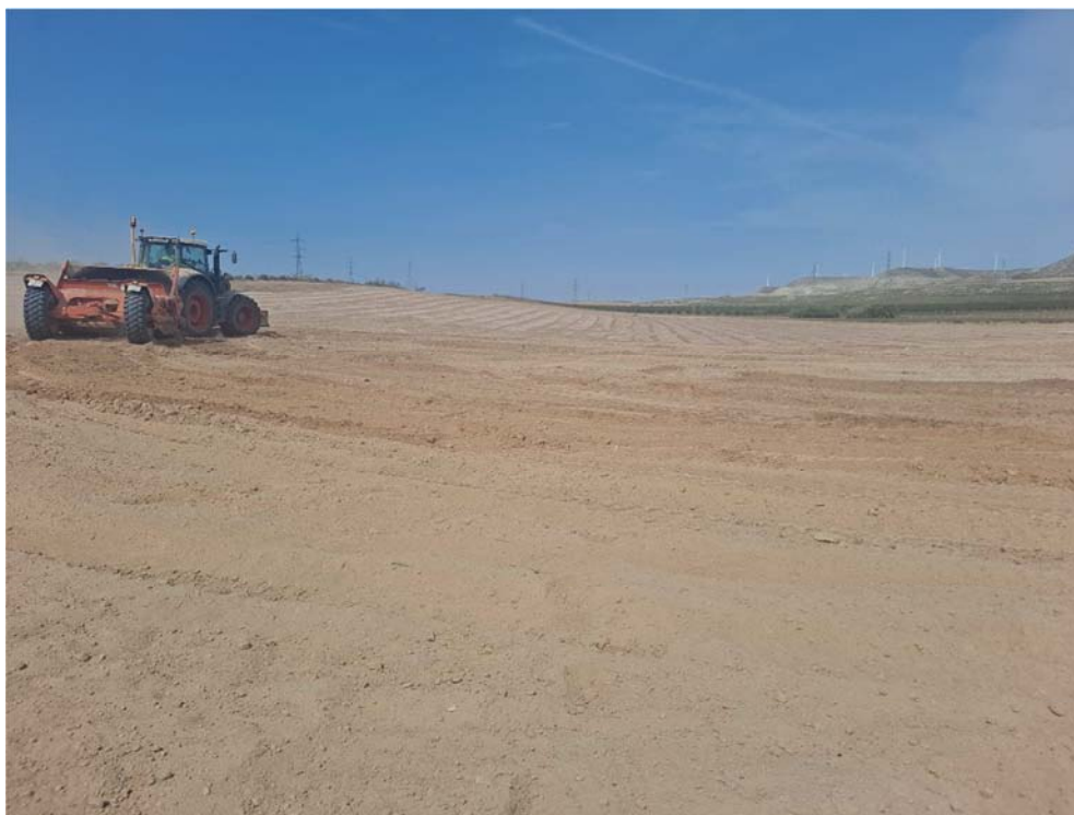
Figura 4.1. Movimientos de tierra para suavizar la topografía de la zona de proyecto
