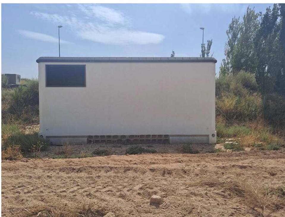
Figura 8.10. Caseta prefabricada, todavía sin uso, instalada en el límite sureste de la parcela
