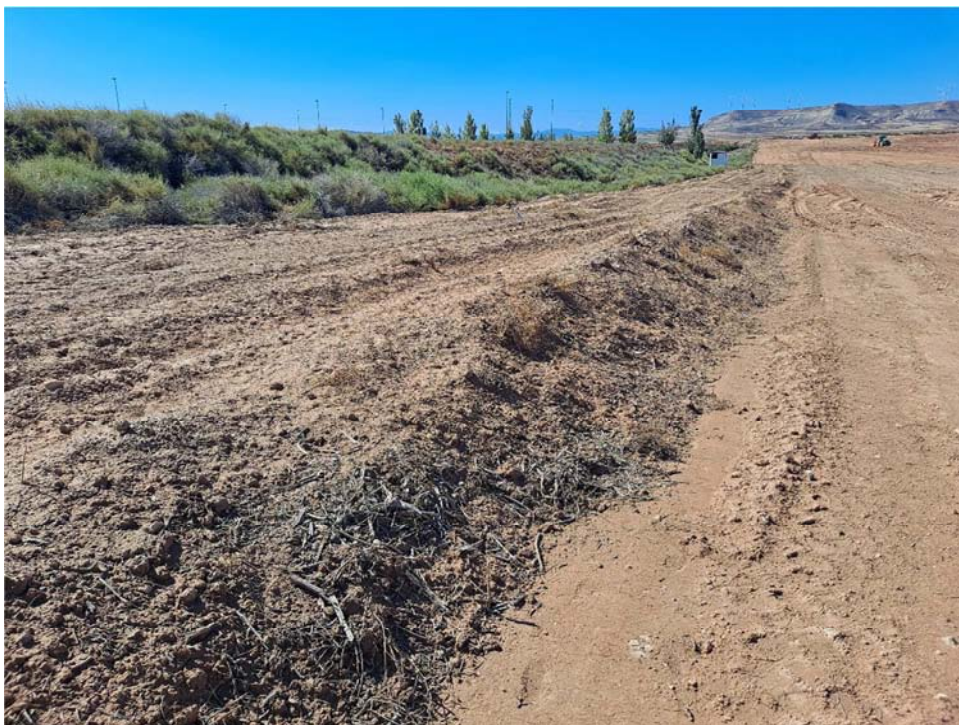
Figura 8.6. Acopios de tierra vegetal situados en el límite sureste de la zona de proyecto. En esta zona la tierra vegetal se encuentra en mejor estado (20-09-23)
