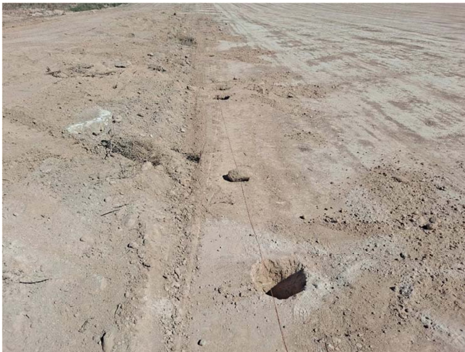
Figura 8.13. Aspecto de los acopios de tierra vegetal situados en el noroeste de la parcela a fecha 27-09-23, en los que se han eliminado las compactaciones y marcas de rodadas, junto con los hoyos para los postes del vallado. Se observa como estos acopios quedarán en una posición exterior al vallado.
