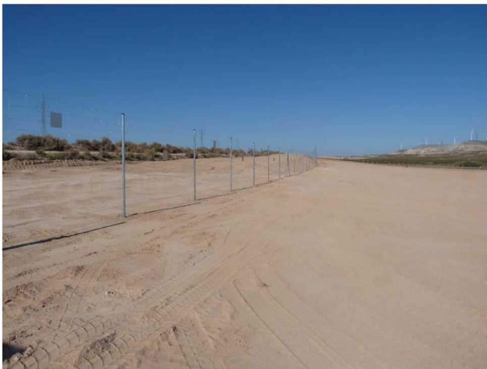
Figura 4.2. Vallado del recinto de la planta
