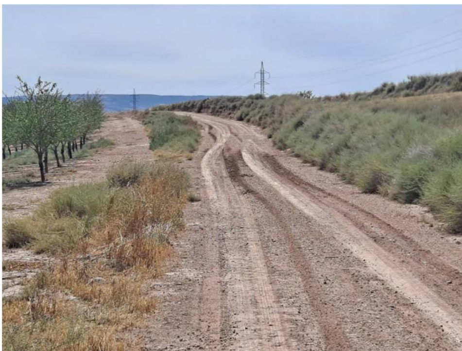
Figura 8.8. Camino de acceso a la zona de proyecto, en buen estado y sin obstáculos
