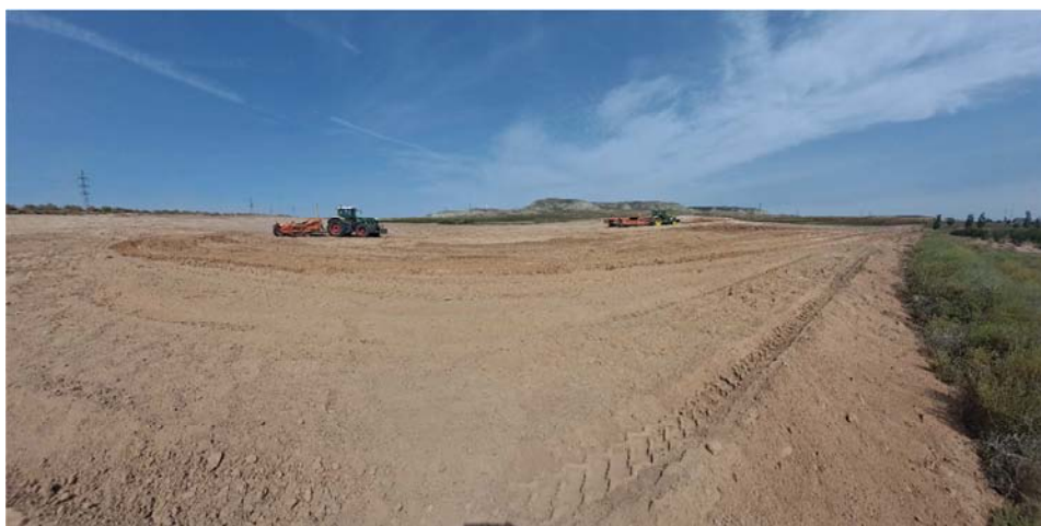
Figura 8.1. Trabajos de nivelación de la parcela
