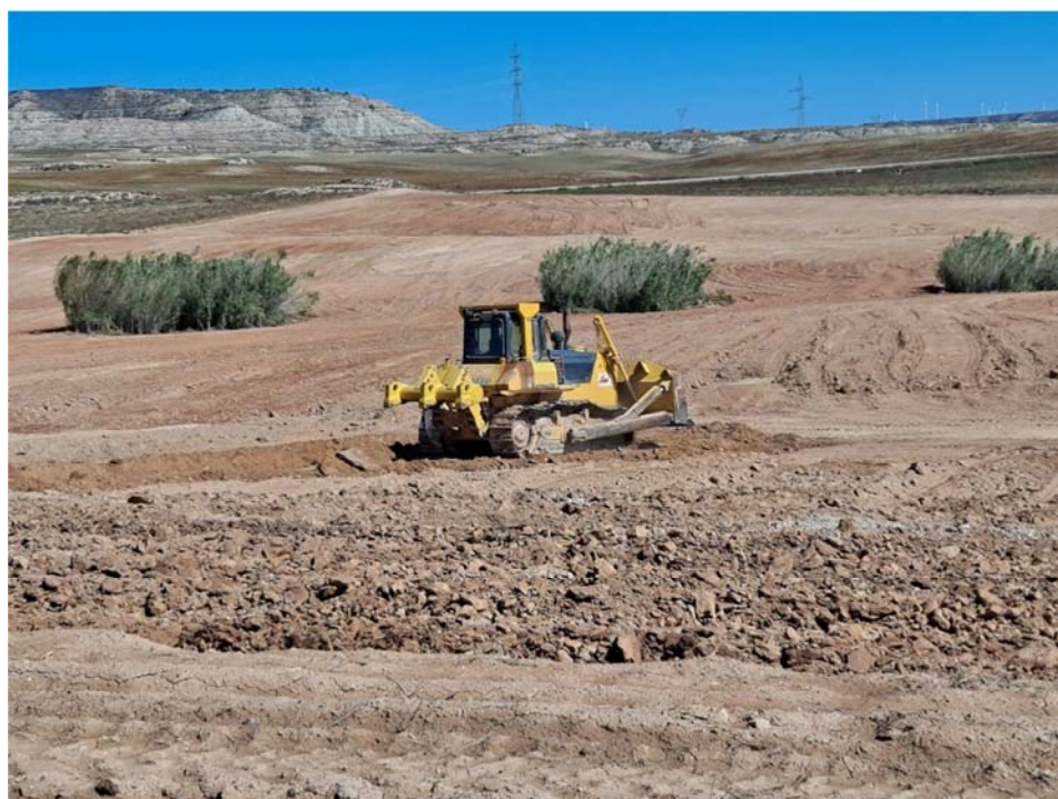
Figura 8.2. Movimientos de tierra para la nivelación de la parcela
