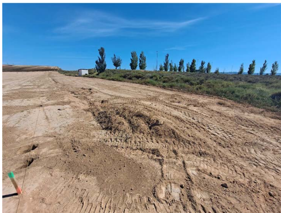
Figura 8.14. Aspecto de los acopios de tierra vegetal situados en el sureste de la parcela a fecha 27-09-23 junto a los hoyos para los postes del vallado, quedando igualmente los acopios en una posición exterior al vallado.
