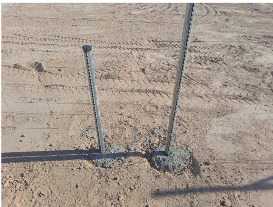
Figura 8.19. Paso de fauna abierto y tapón de plástico en el poste
