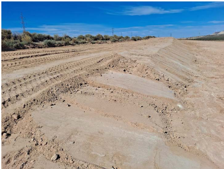
Figura 8.15. Terraplén en el extremo suroeste de la zona de proyecto. El acopio de tierra vegetal que se localizaba en esta zona ha sido mezclado con tierras procedentes de la nivelación de la parcela, dando lugar al terraplén
