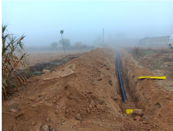
Fig. 2 Apertura de zanjas y acopios de material.
