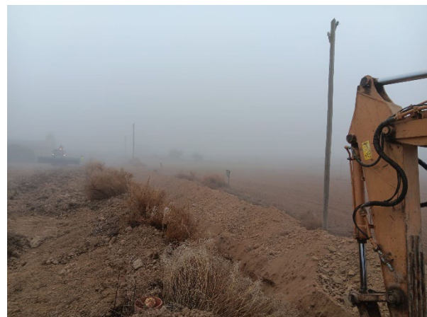
Fig. 1 Apertura de zanjas y acopios de material.
