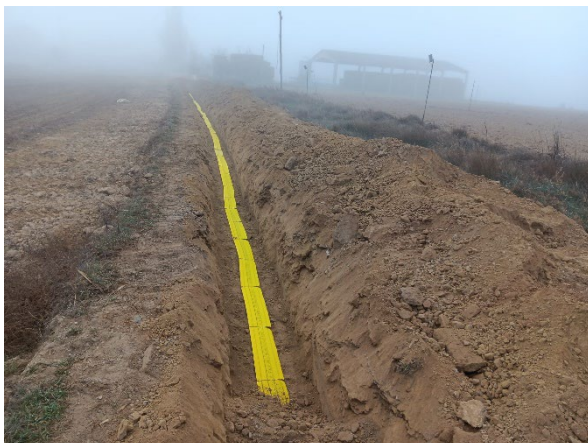
Fig. 1 Apertura de zanjas y acopios de material.
