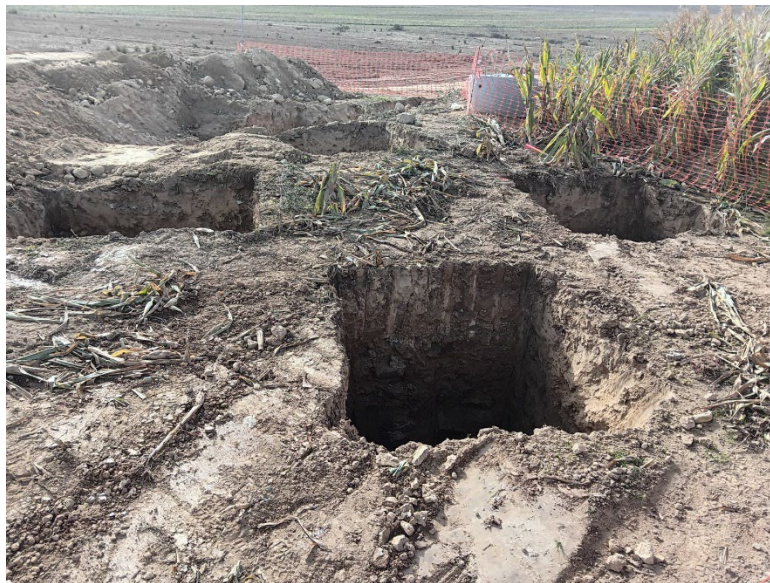
Fig. 1. Excavaciones para la construcción de apoyos.
