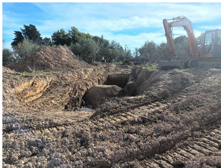
Fig. 2. Excavaciones para la construcción de apoyos.
