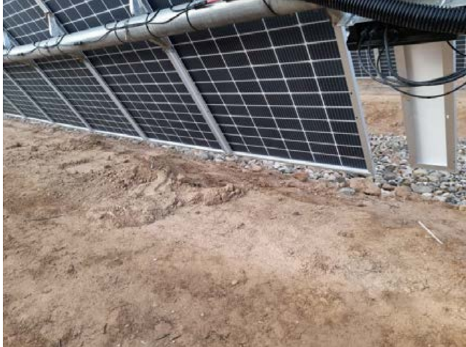
Fig. 3 Erosión en el canal Norte de drenaje de la parcela
