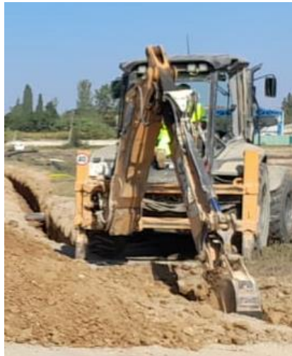
Fig. 1 Vehículos trabajando en la línea de evacuación.
