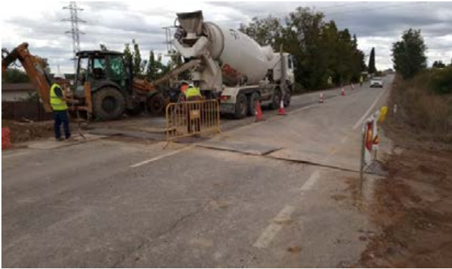
Fig. 2 Cruce con la carretera de la línea soterrada de media tensión.
