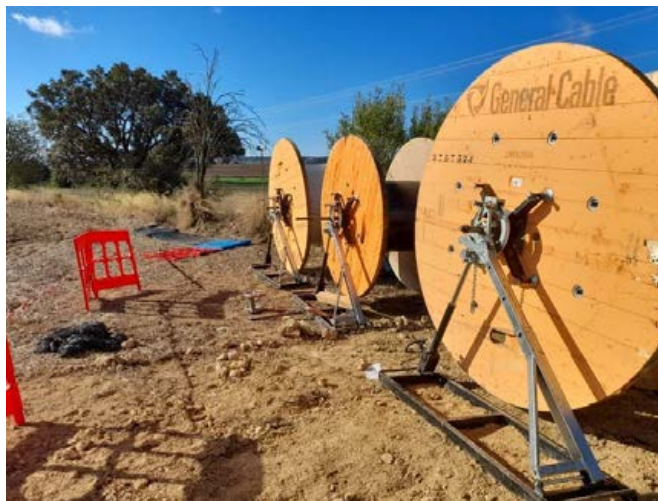
Fig. 1 Tendido de cable de media tensión por tubo soterrado en zanja tapada.
