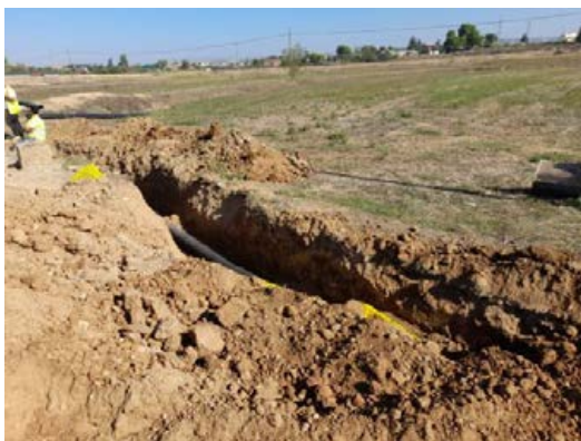
Fig. 1. Zanjas abiertas junto al gaseoducto (2)
