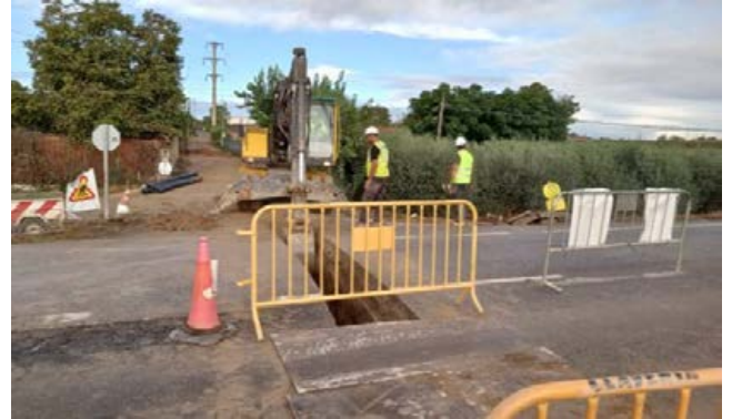
Fig. 2 Cruce con la carretera de la línea soterrada de media tensión.
