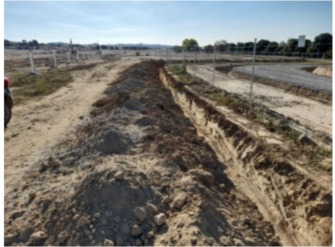
Fig. 1. Apertura de zanjas y cordón de tierra.
