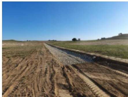
Fig. 2 Drenaje interior con cantos rodados.
