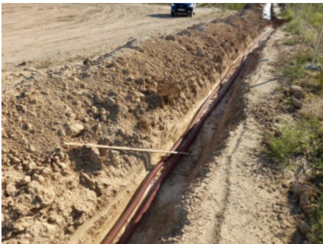
Fig. 2. Apertura de zanjas con tablas salva caídas de fauna.
