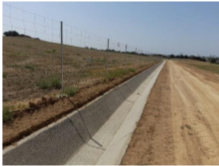
Fig. 1 Drenaje hormigonado en la zona Este del interior de la parcela
