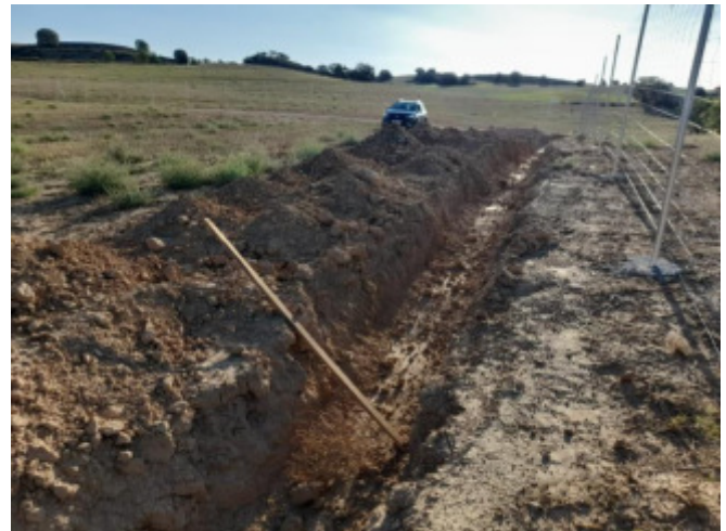
Fig. 2. Apertura de zanjas con tablas salva caídas de fauna.
