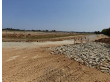
Fig. 4 ODT y vado instalados en el camino exterior de la planta.
