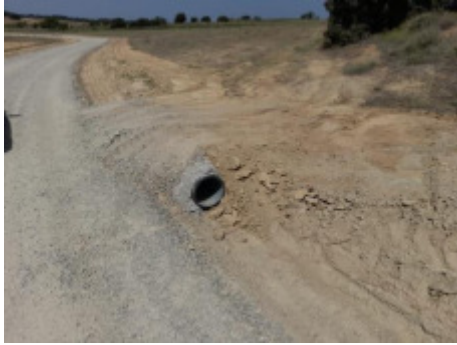
Fig. 4 ODT y vado instalados en el camino exterior de la planta.
