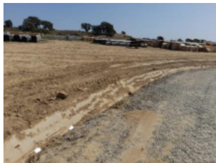
Fig. 3 Drenaje excavado en tierra de la parte centro-oeste de la planta.
