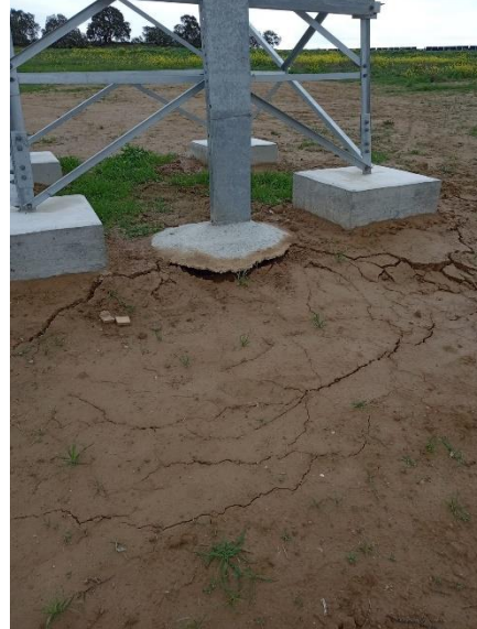
Fig. 3 Erosión en el apoyo 1 de la Línea de alta tensión.
