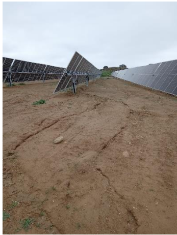
Fig. 1 Taludes poco erosionados de la parte Norte de la parcela.
