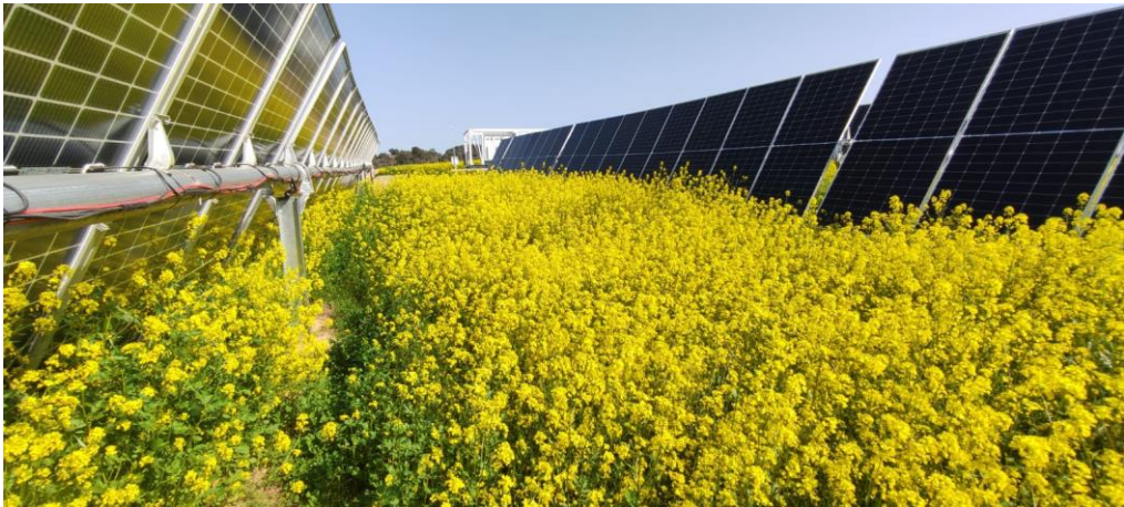
Foto 1. Vegetación crecida por la zona oeste de la planta
