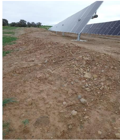
Fig. 1 Taludes poco erosionados de la parte Norte de la parcela.
