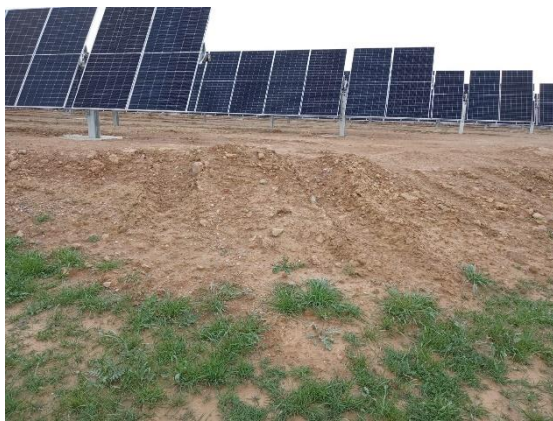
Fig. 2 Erosión en los taludes de la planta
