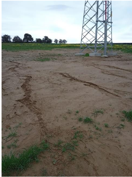
Fig. 3 Erosión en el apoyo 1 de la Línea de alta tensión.
