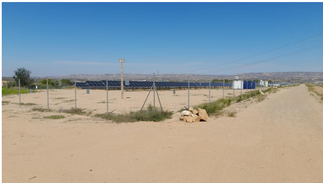
Foto 3. Vista del vallado perimetral de la planta. Apreciación de majano y caja nido.
