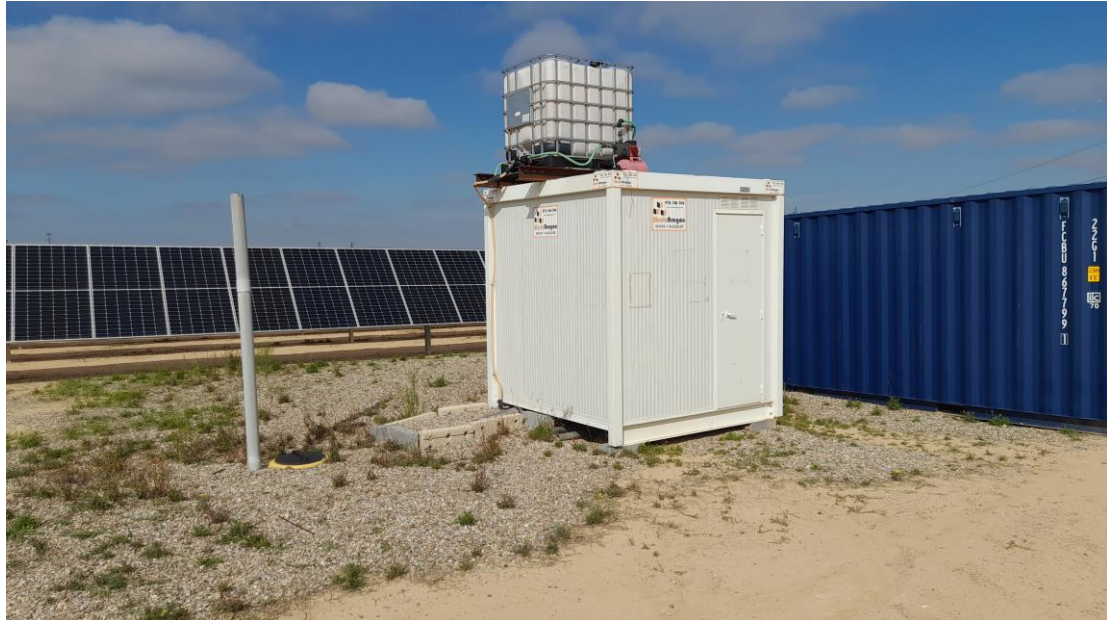
Foto 5. Instalaciones correspondientes a aseos en el interior de la planta . Actualmente en desuso ya que el personal de mantenimiento utiliza los correspondientes a la CTCC Peaker.
