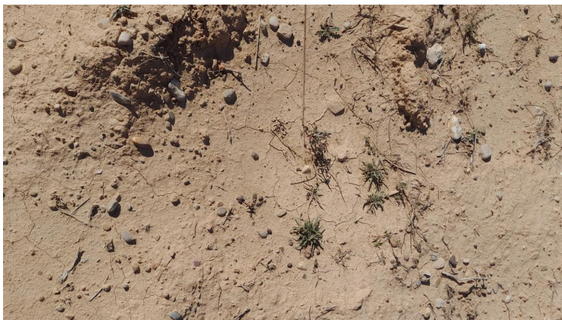
Foto 12. Apreciación de suelo agrietado en el interior del vallado.
