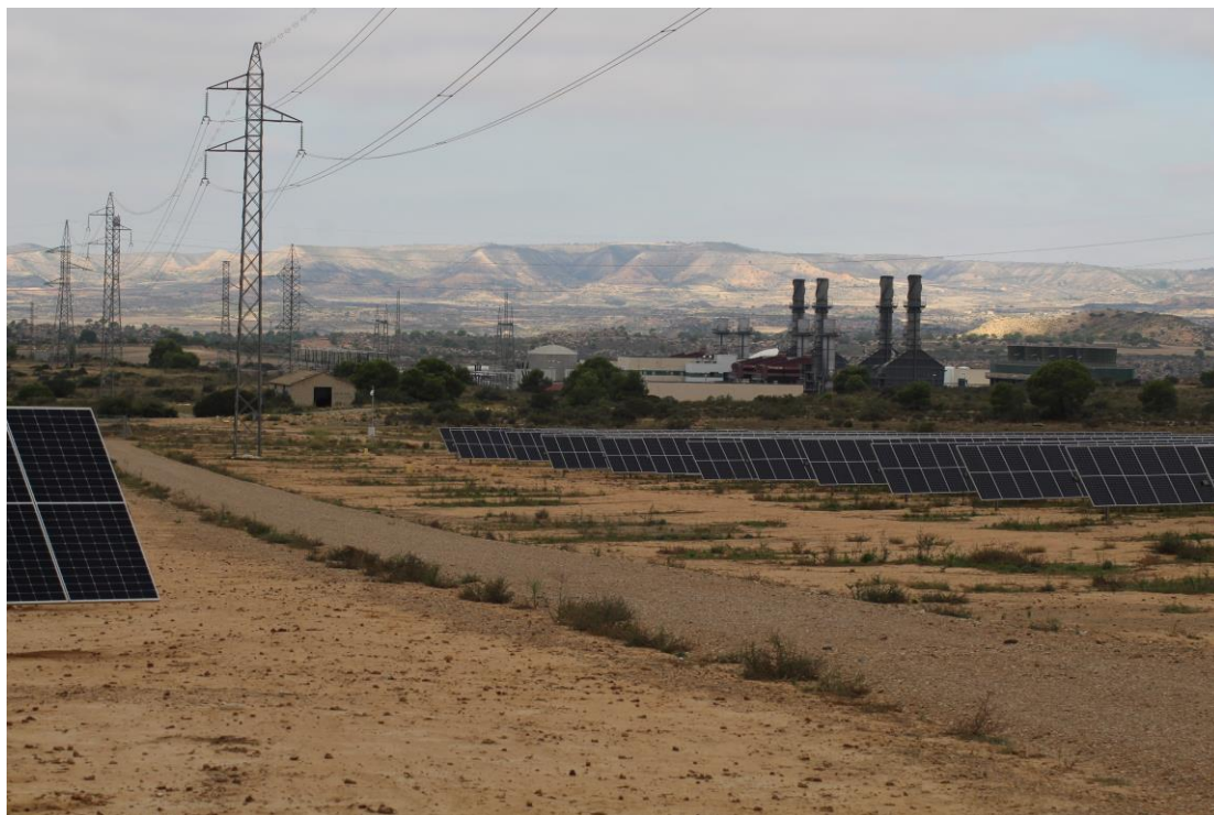
Foto 1. Vista general de la planta fotovoltaica.
