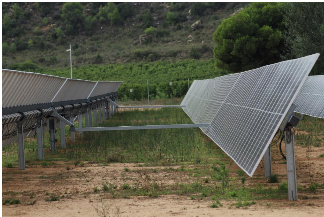
Foto 9. Vista de seguidores y vegetación natural creciendo entre ellos. Situación actual tras un desbroce mediante ganado tres semanas antes (Parte II).
