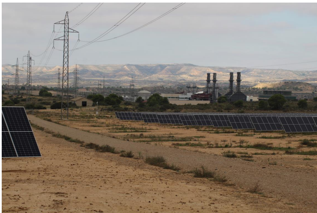
Foto 2. Vista general de la planta fotovoltaica. Septiembre 2023.
