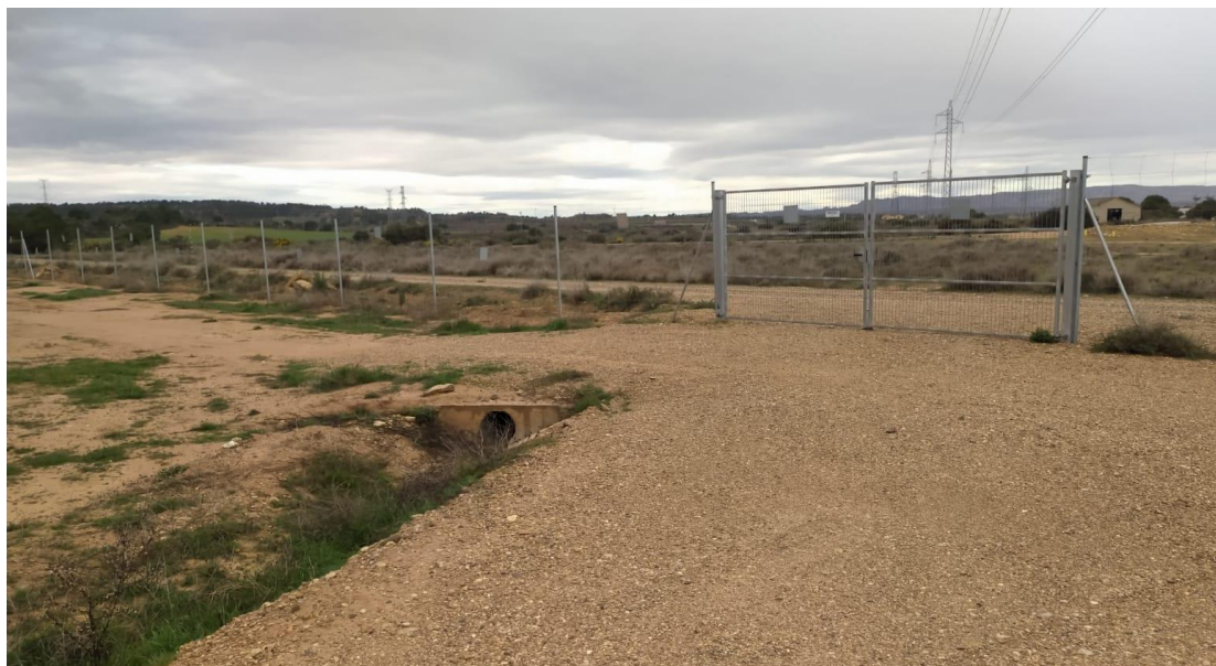
Foto 1. Vista del acceso al recinto sur de la planta fotovoltaica. Marzo 2023
