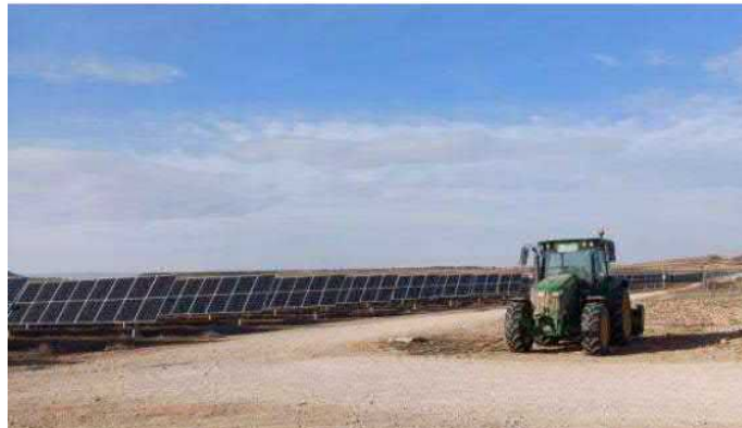
Imagen 6. Tractor utilizado para el control de la vegetación que crece en el interior de la planta fotovoltaica
