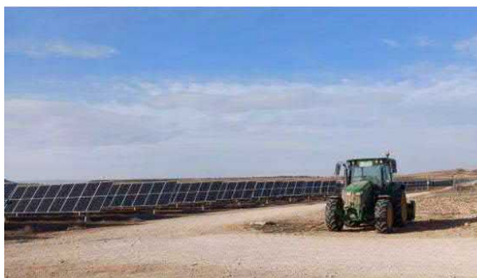
Imagen 4. Tractor utilizado para el control de la vegetación que crece en el interior de la planta fotovoltaica
