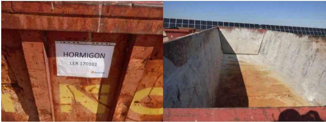
Imagen 25. Contenedor habilitado para el depósito de hormigón adecuadamente identificado
