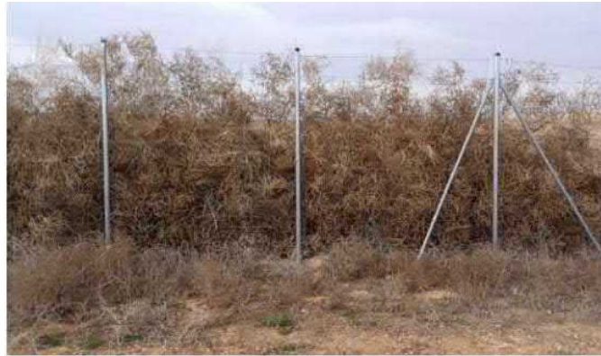
Imagen 5. Acumulaciones de capitanas en la cara exterior del vallado perimetral
