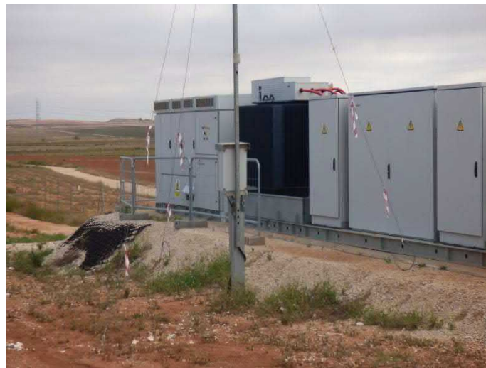
Imagen 6. Tiras de cinta de balizamiento instaladas en los cables de las torres anemométricas.
