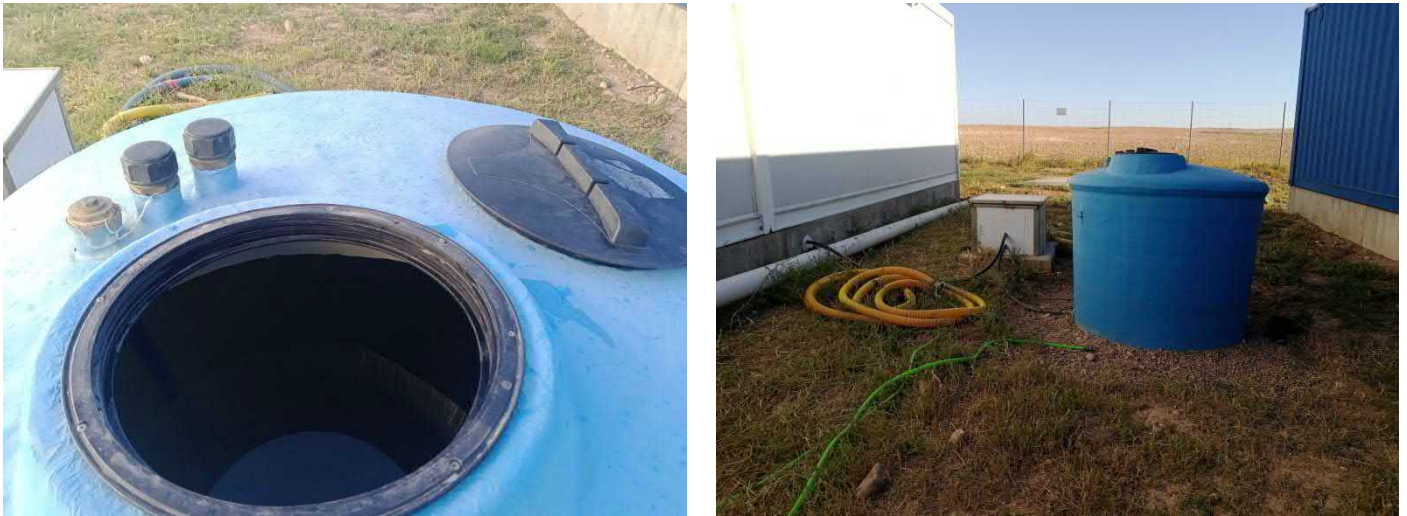
Imágenes 4 y 5. Depósito de agua limpia, vista interna y externa (imágenes izquierda y derecha respectivamente).
