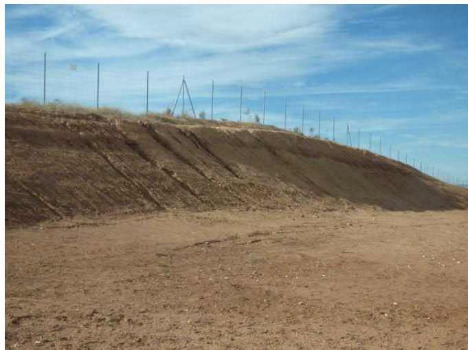
Imagen 3. Talud ubicado al sur de la planta fotovoltaica "Híjar I".
