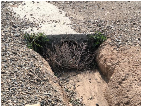
Izqda: drenaje taponado por vegetación. Drcha: estado de la cobertura vegetal en la planta
