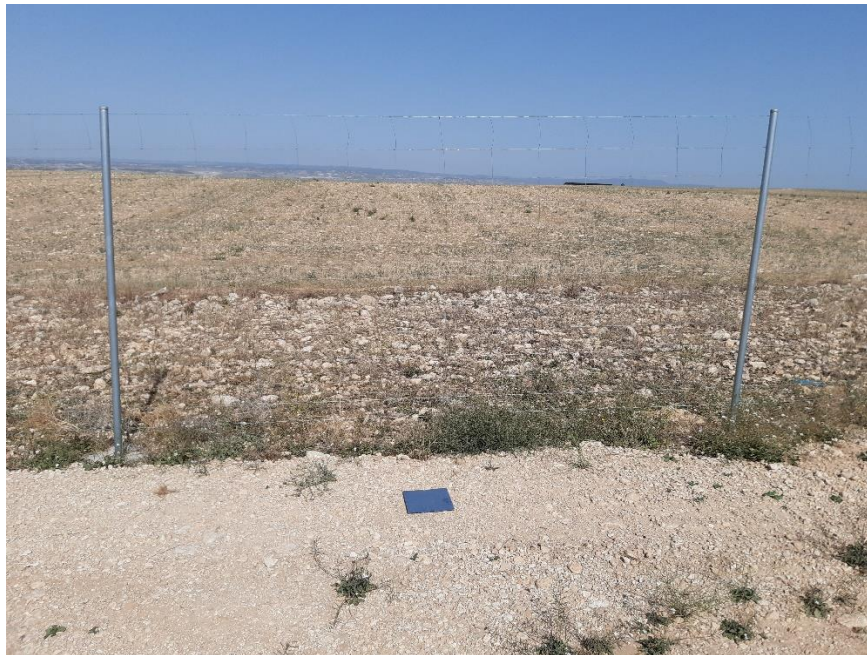
Fig. 1 Muestra de placa caída en vallado perimetral en margen oeste de la PFV en visita realizada en agosto.
