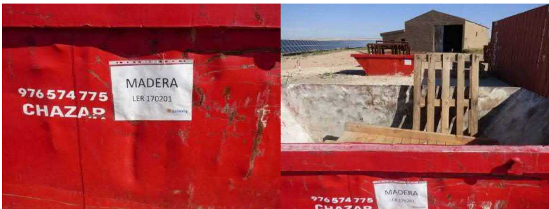
Imagen 23. Contenedor habilitado para el depósito de madera adecuadamente identificado
