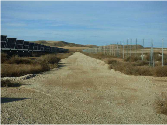
Imágenes 1 y 2. Procesos erosivos de los viales internos, que posteriormente han sido acondicionados.
