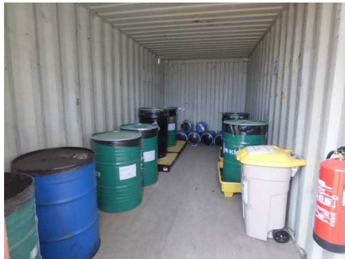
Imagen 23. Depósitos homologados e identificados conforme a la normativa vigente para el almacenamiento temporal de residuos peligrosos
