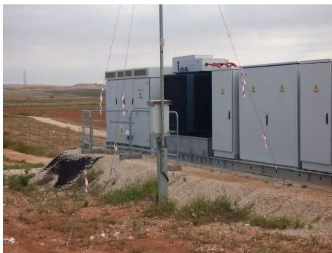
Imagen 7. Tiras de cinta de balizamiento instaladas en los cables de las torres anemométricas.
