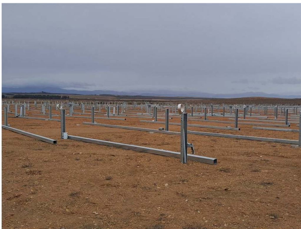
Figura 4.1. Aspecto de la planta a fecha 15-01-2024
