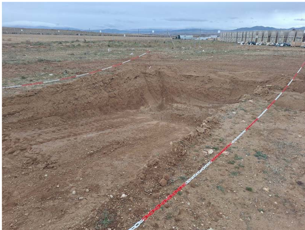
Figura 4.2 Rampa ejecutada para la carga y descarga de camiones
