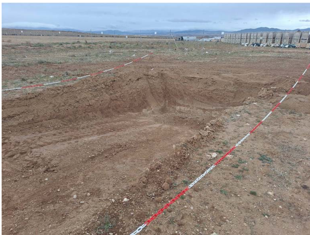
Figura 8.1. Rampa para la carga y descarga de los camiones situada entre las plantas "San Pedro" y "Épila"
