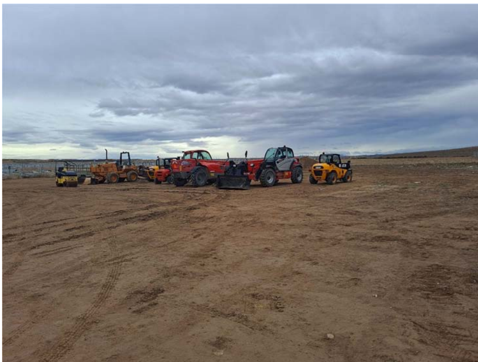
Figura 8.9. Parking de maquinaria situado entre las plantas "Épila" y "San Pedro"
