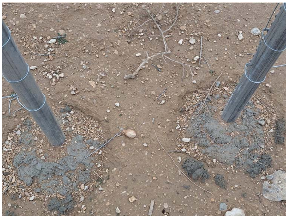
Figura 8.6. Alambres en el suelo junto a los pasos de fauna
